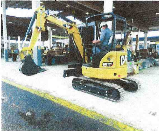
Prueba de maquinaria
