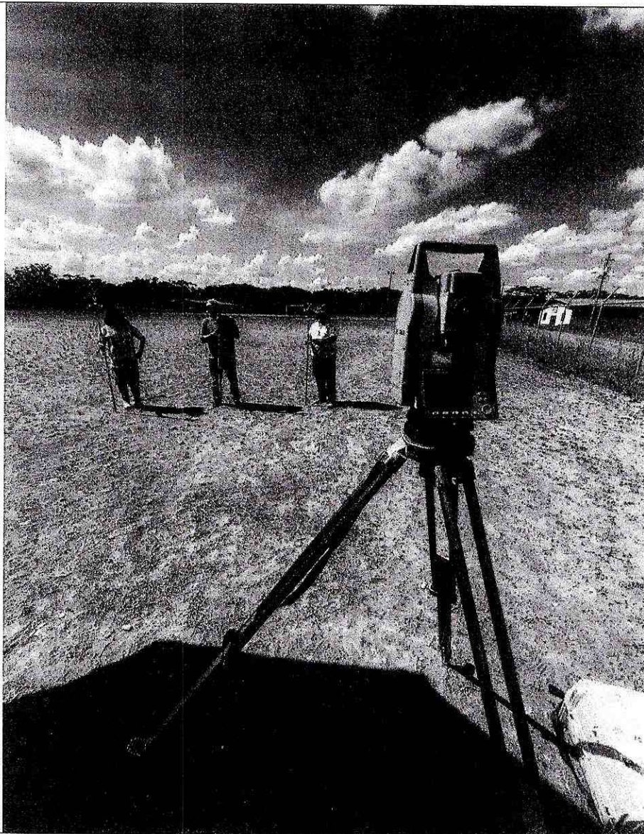
Foto 4: Levantamiento topográfico del proyecto de cancha de césped sintético
