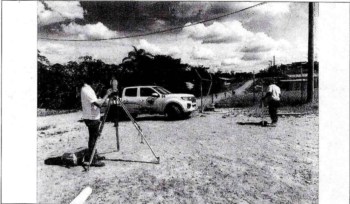
Foto 2: Definición de límites acorde a la distancia de establecida para la construcción de la cancha
