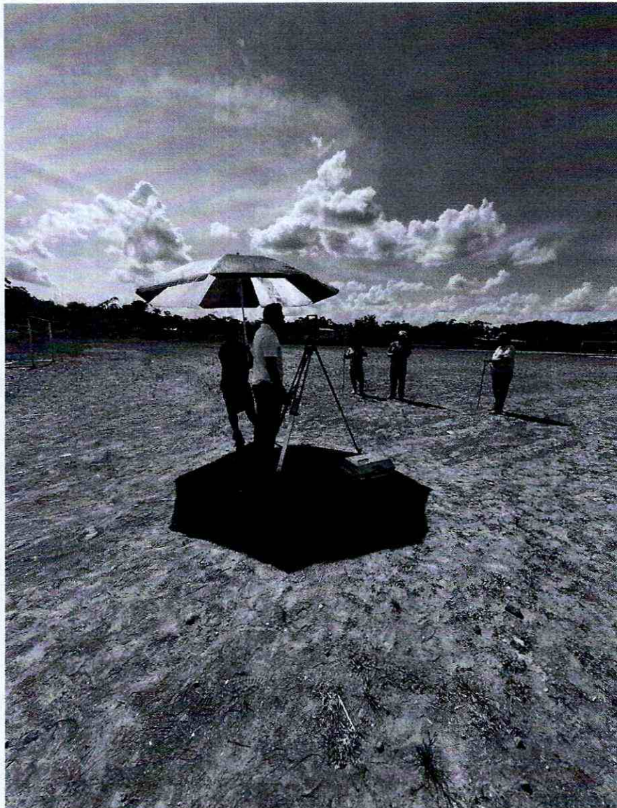
Foto 3: Levantamiento topográfico del proyecto de cancha de césped sintético
