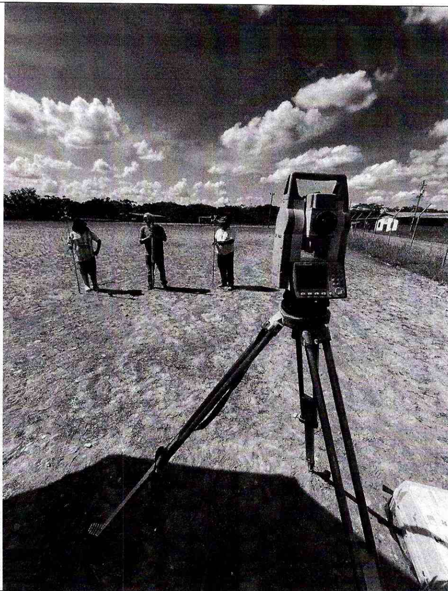
Foto 4: Levantamiento topográfico del proyecto de cancha de césped sintético
