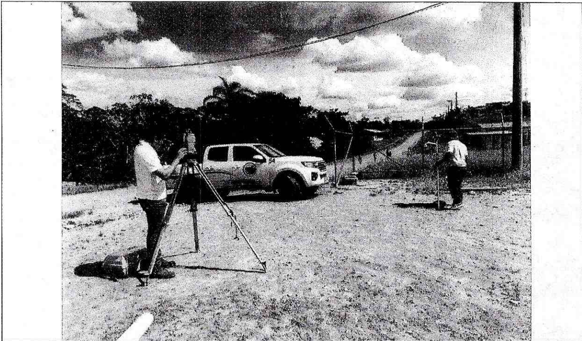
Foto 2: Definición de límites acorde a la distancia de establecida para la construcción de la cancha
