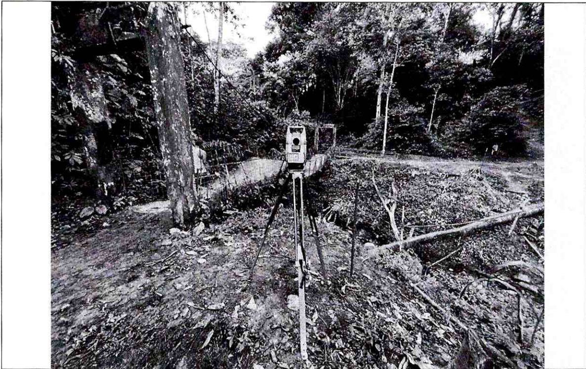
Foto 2: Levantamiento topográfico de puente peatonal sin nombre en la Comunidad Sarayaku
