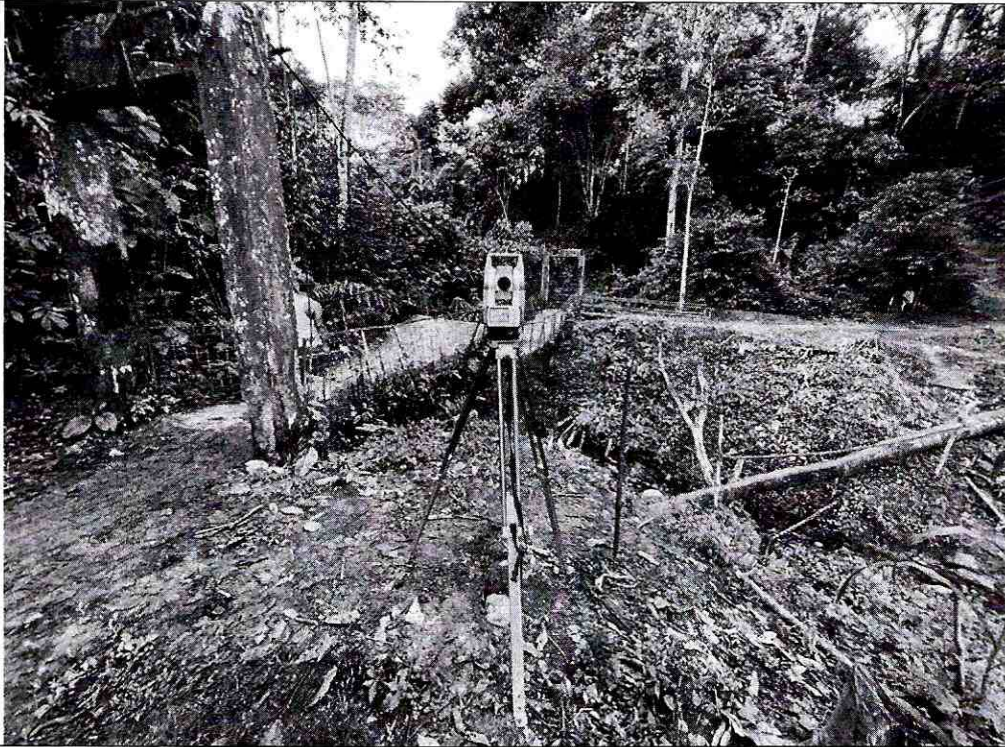
Foto 2: Levantamiento topográfico de puente peatonal sin nombre en la Comunidad Sarayaku
