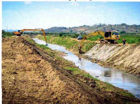
Limpieza de canales con excavadora de brazo largo
