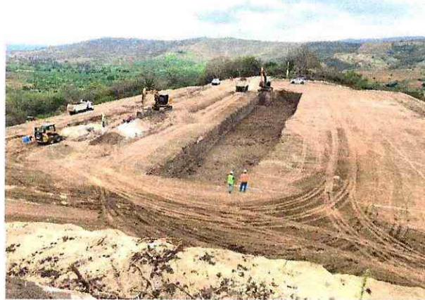
Infraestructura de riego y Drenaje en Manabí
