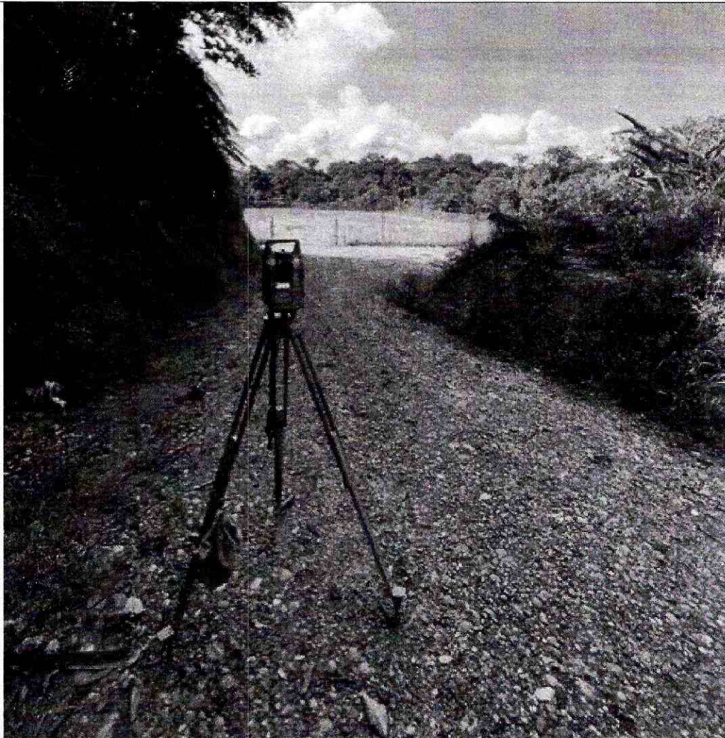
Foto 4: Llegada de levantamiento topográfico del proyecto de asfaltado a la plataforma petrolera abscisa 4+200
