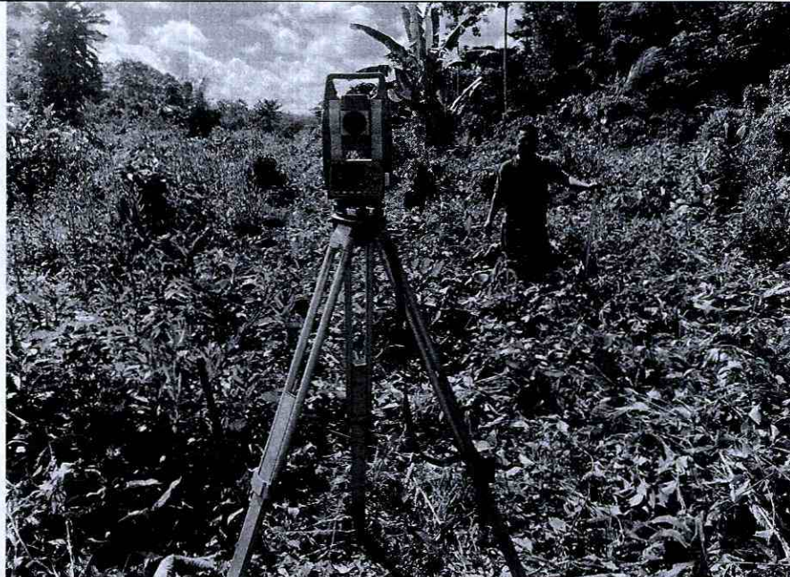
Foto 5: Levantamiento topográfico para proyecto de Construcción de una Pista en la Comunidad Llanchamacochap
