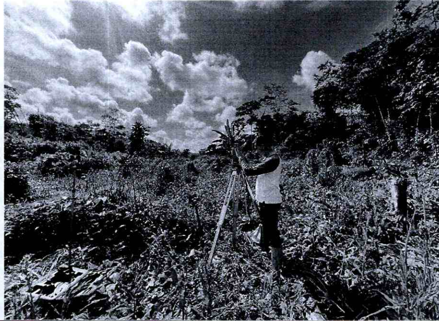
Foto 4: Levantamiento topográfico para proyecto de Construcción de una Pista en la Comunidad Llanchamacocha
