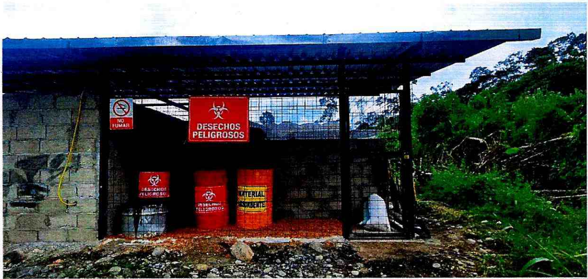
LUGAR DE ALMACENAMIENTO TEMPORAL DE DESECHOS
