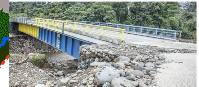
PUENTE RIO PINDO GRANDE
