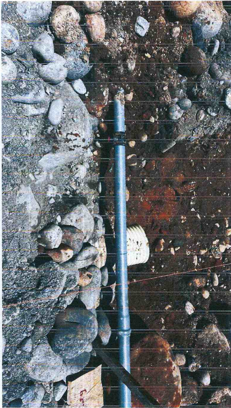
INSPECCION DE FUGAS DE AGUA
