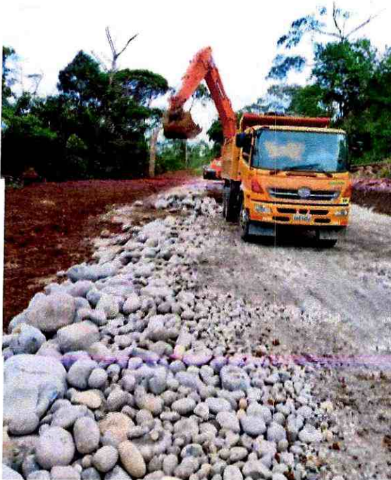
Transporte de material de desalojo
