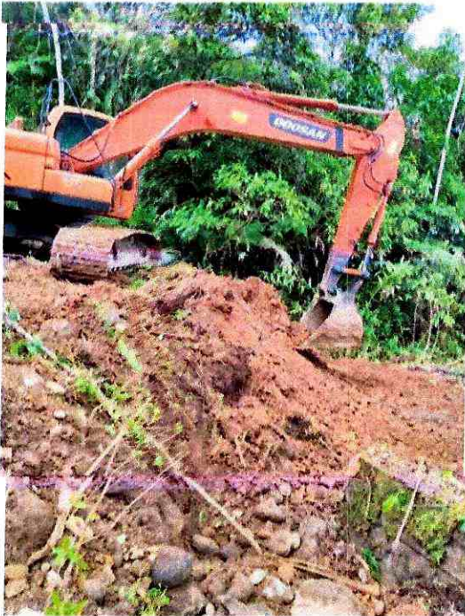
Limpieza y desbroce
