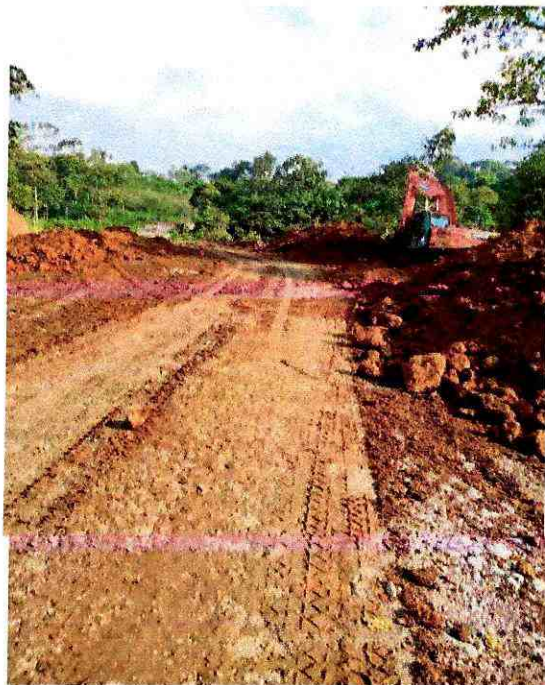
Movimiento de tierra
