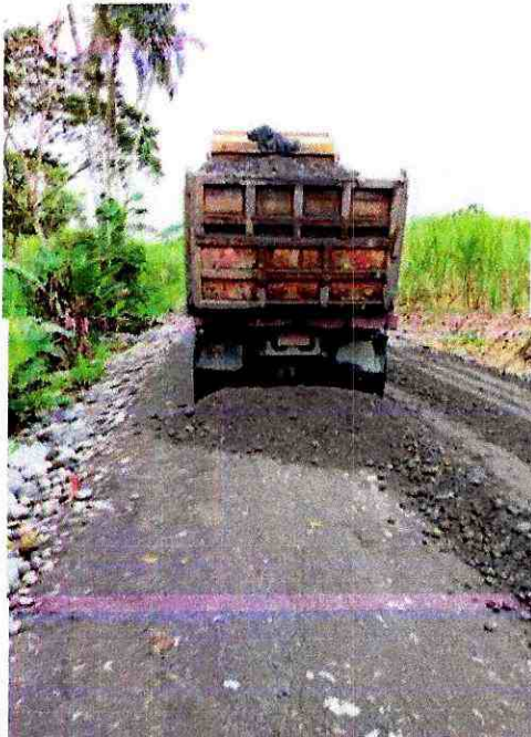
Transporte de material base granular
