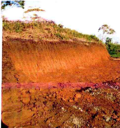
Limpieza y desbroce
