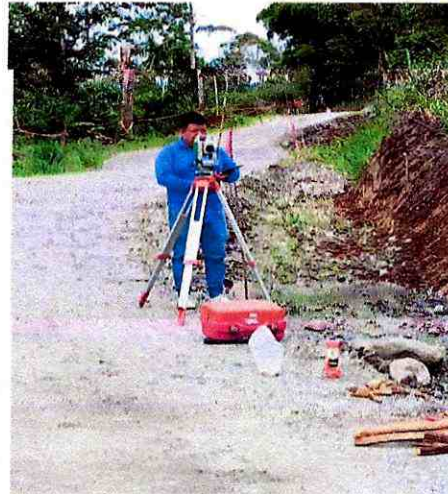
Replanteo y nivelacion
