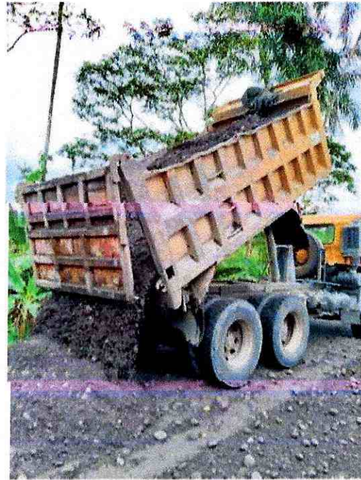
Transporte de material subbase clase 3
