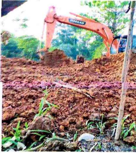
Excavación de movimiento de tierra
