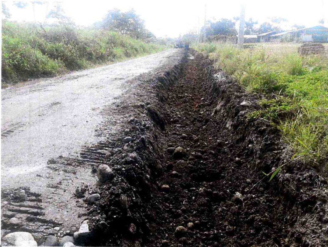
FOTO 13.- Excavación de cajas margen derecho.
