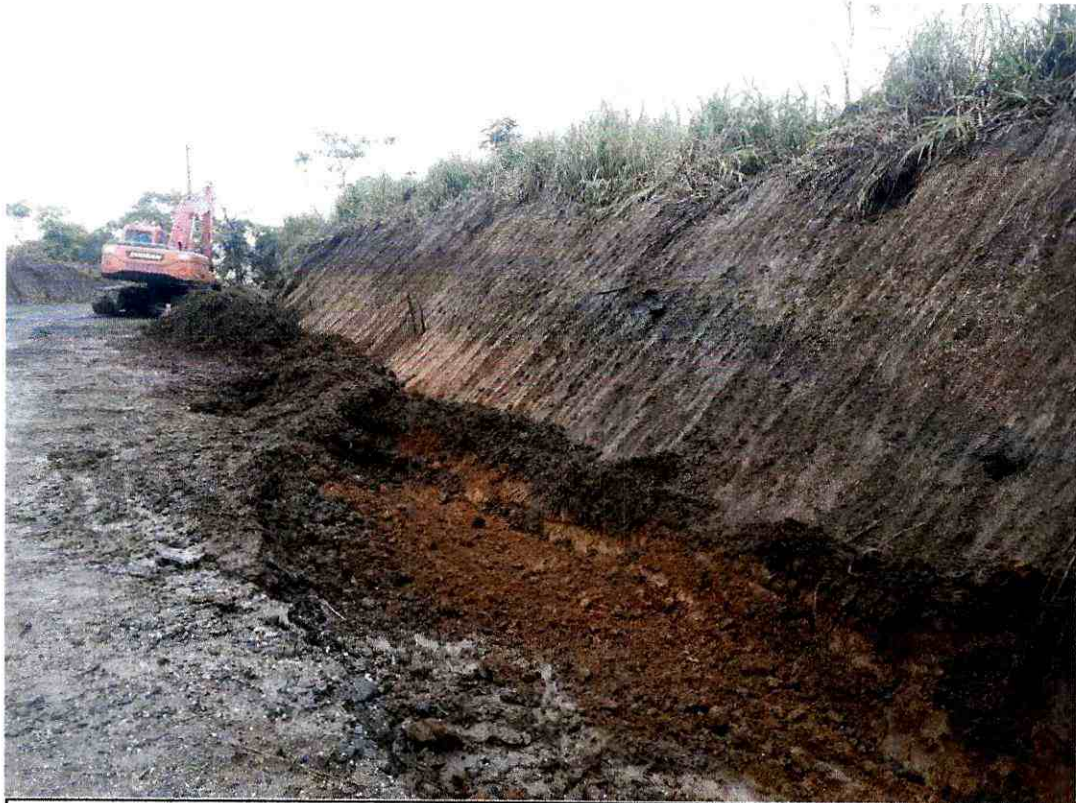
FOTO 7.- Excavación de cajeras y taludes margen derecho. ABCISA: 3+340 Fecha: 19 de junio del 2020
