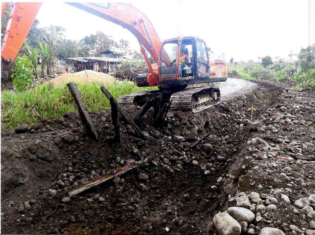
FOTO 14.- Excavación total de la vía.
