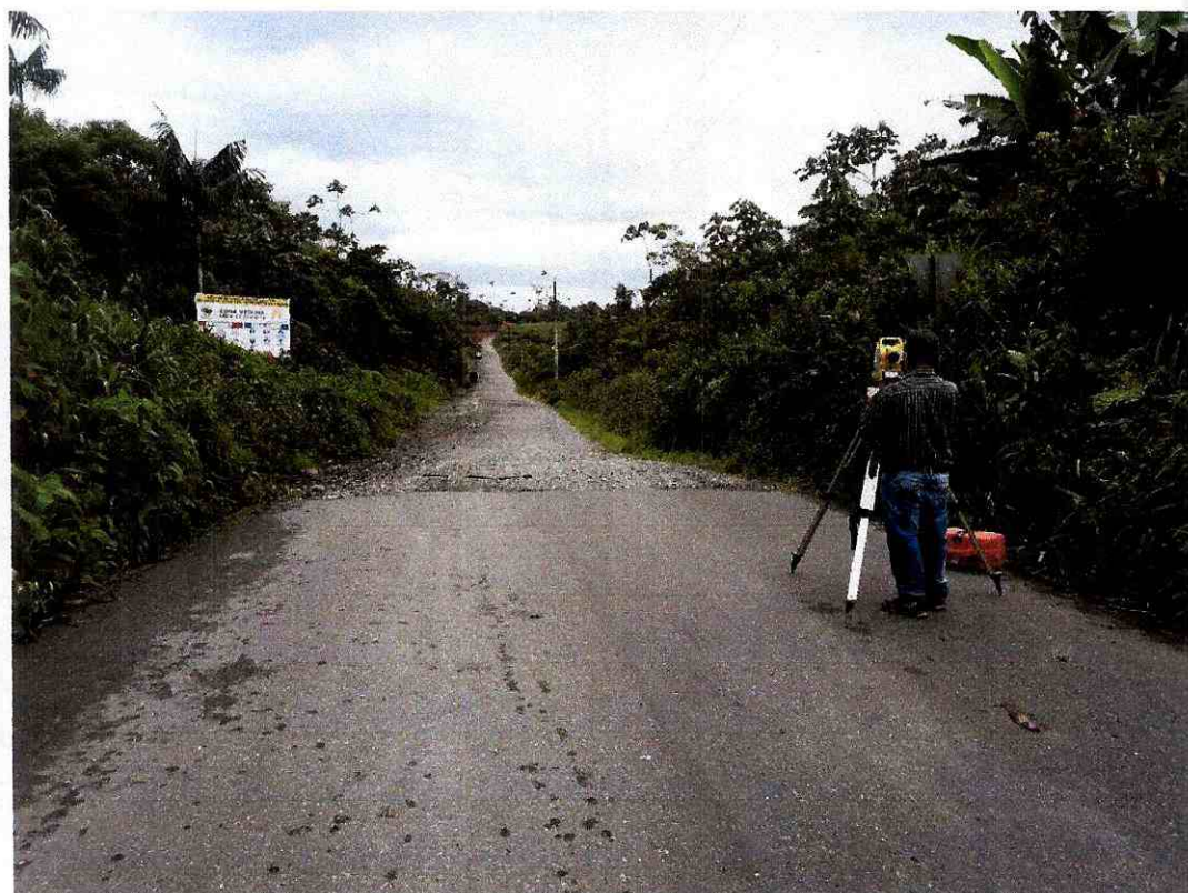
FOTO 2.- Vista del nivel de terreno inicial. ABCISA: 3+00 a la 3+320
