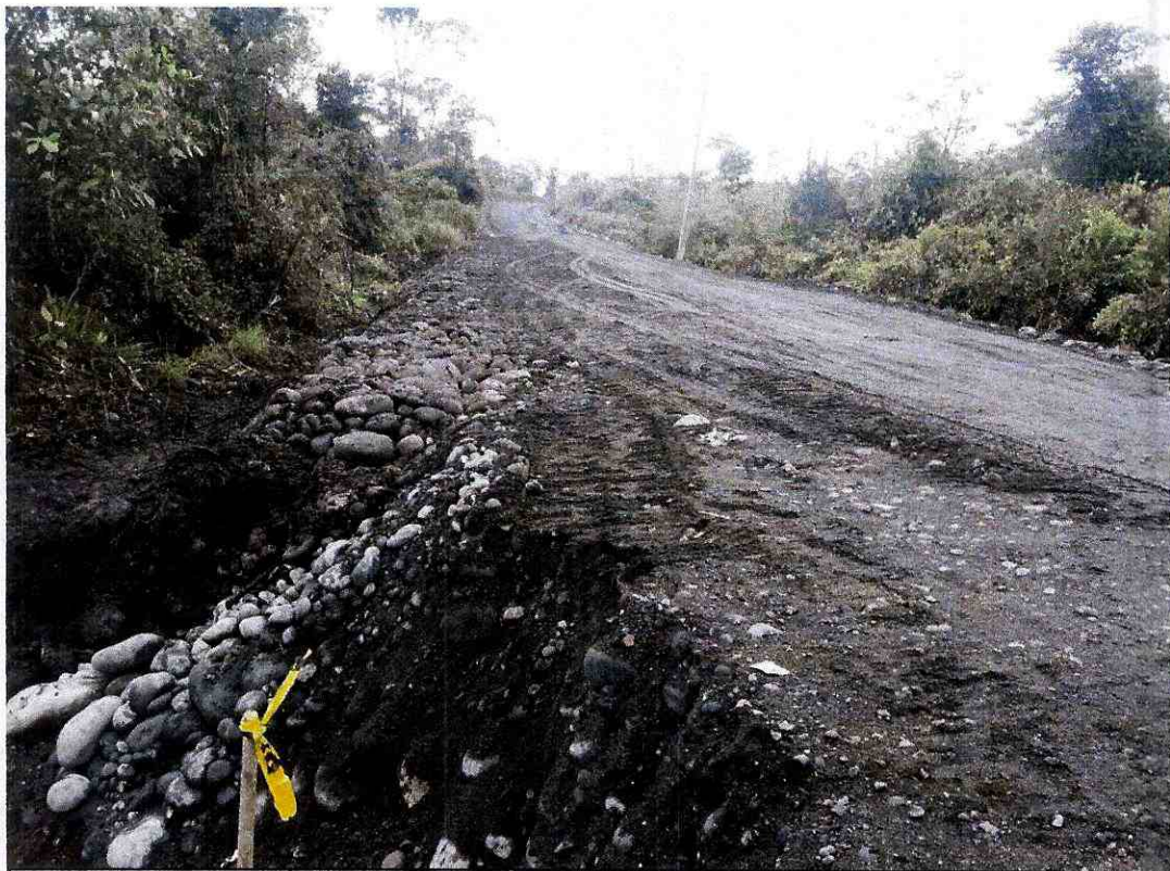
FOTO 20.- Excavación y relleno margen izquierdo ABCISA: 3+170
