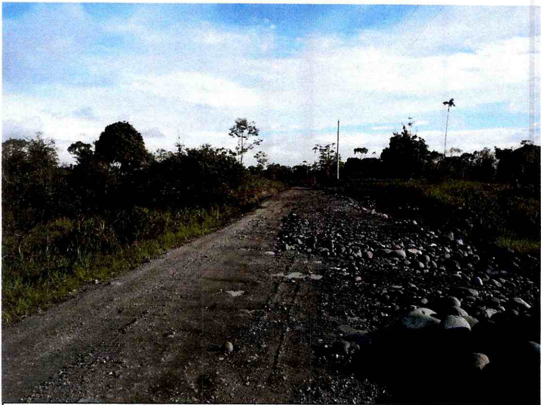
FOTO 8.- Instalación de mejoramiento en cajeras margen izquierdo y ancho de vía. ABCISA: 3+420 a la 3+520 Fecha: 20 de junio del 2020
