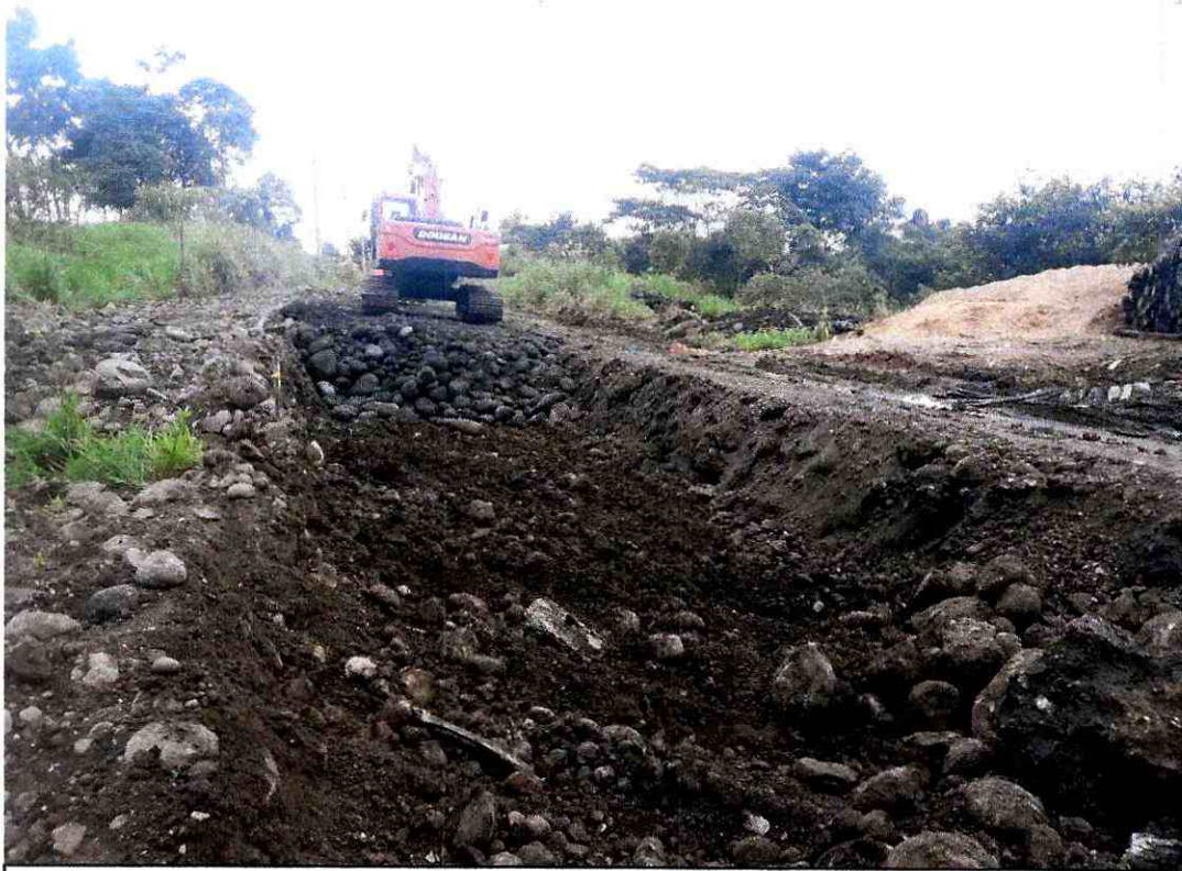
FOTO 15.- Relleno de vía total. ABCISA: 4+180
