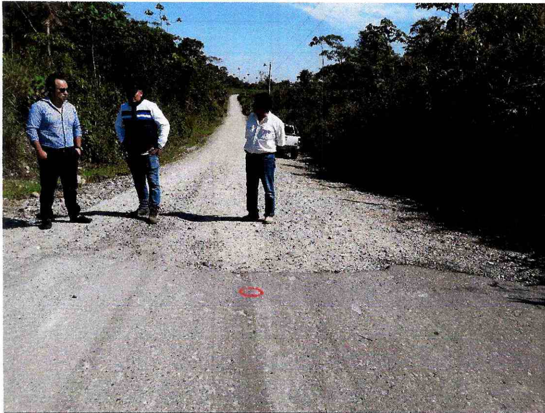
FOTO 1.- Instalación del Punto inicial del proyecto ABCISA: 3+00
