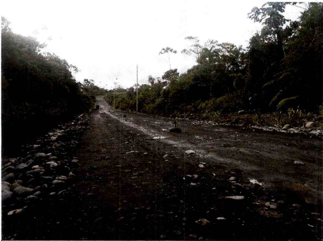
FOTO 16.- Excavación total de la vía. ABCISA: 3+020
