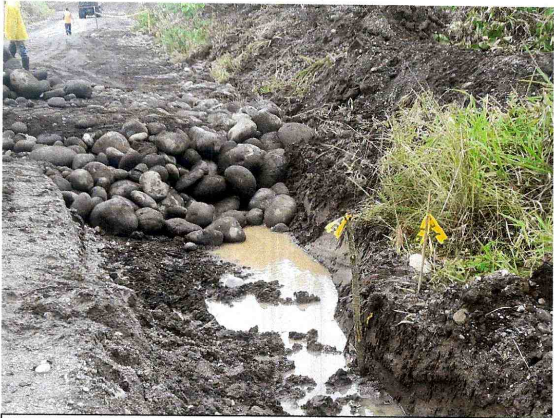
FOTO 11.- Relleno de cajas margen izquierdo. ABCISA: 3+720 Fecha: 26 de junio del 2020
