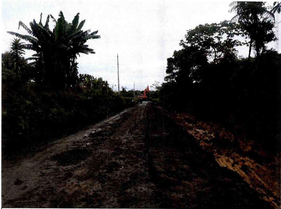
FOTO 12.- Excavación de cajas y taludes margen izquierdo. ABCISA: 3+760 a la 3+920 Fecha: 26 de junio del 2020
