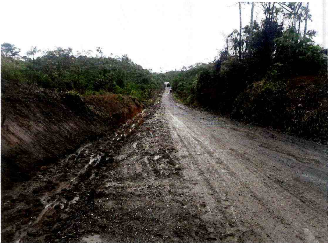
FOTO 6.- Excavación de cajeras margen derecho de la vía. ABCISA: 3+00 a la 3+320 Fecha: 19 de junio del 2020
