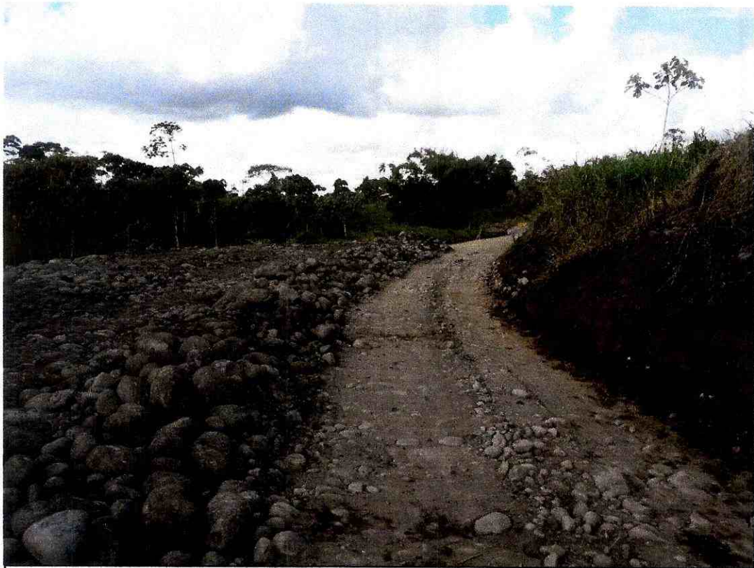
FOTO 19.- Relleno de vía total. ABCISA: 4+420
