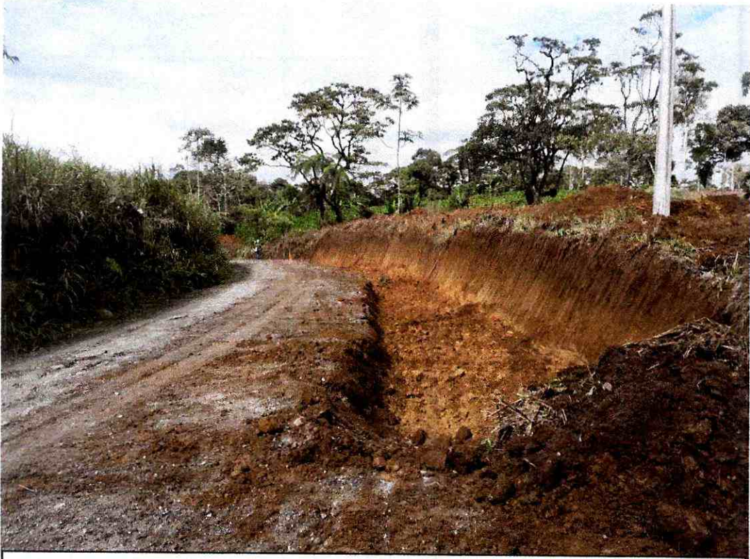
FOTO 3.- Excavación de cajeras y taludes al margen izquierdo de la vía ABCISA: 3+320 Fecha: 17 de junio del 2020
