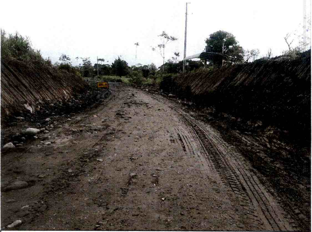
FOTO 10.- Excavación de cajas y taludes margen derecho e izquierdo. ABCISA:3+600 3+640 Fecha: 25 de junio del 2020
