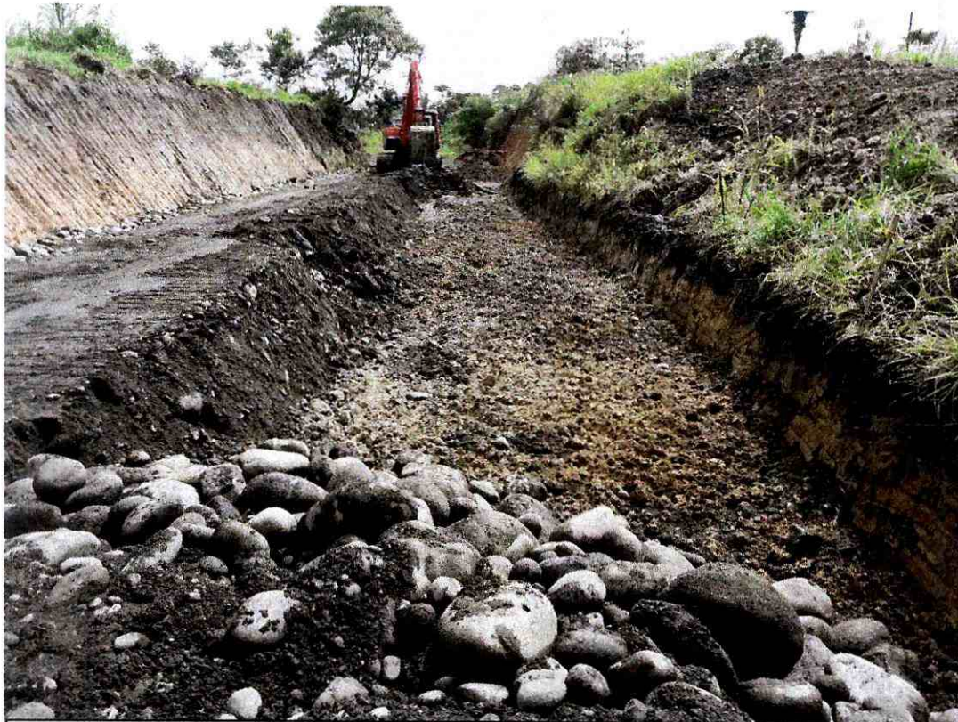
FOTO 17.- Relleno de vía total. ABCISA: 4+320
