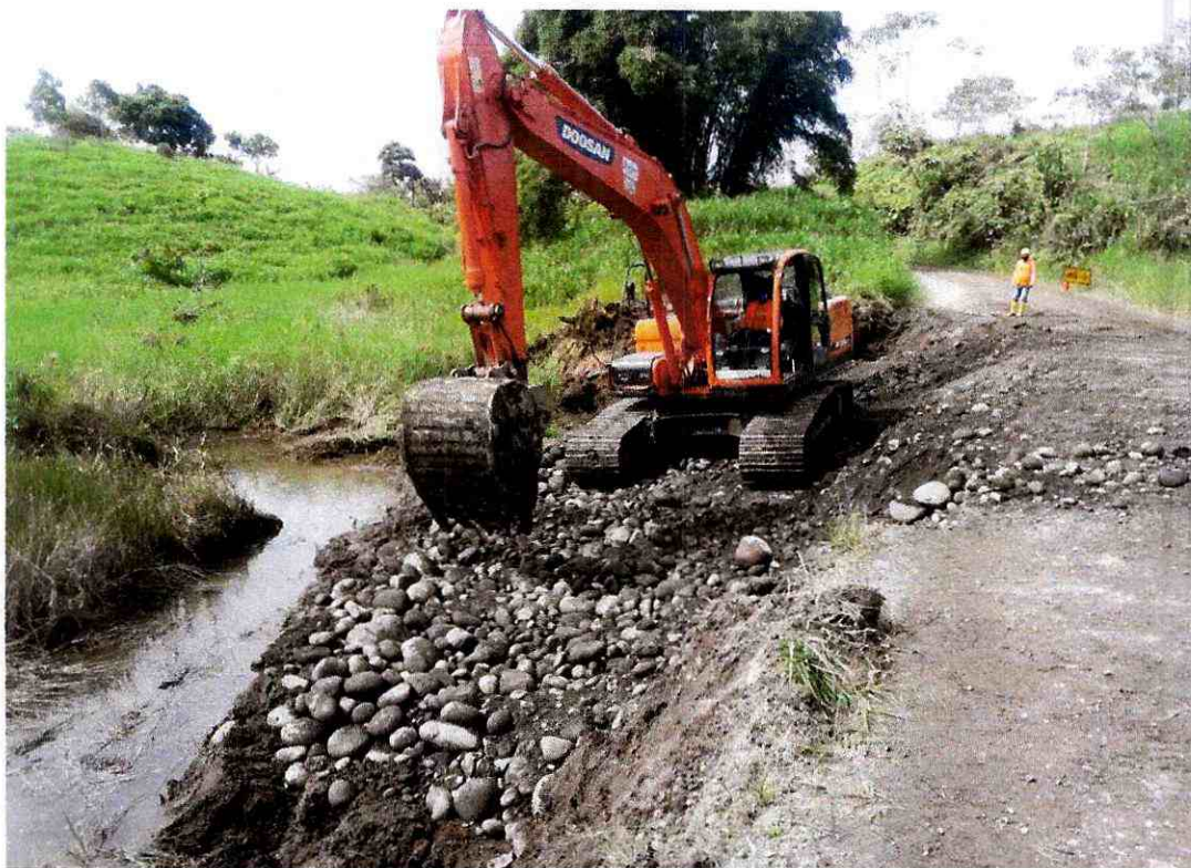
FOTO 18.- Excavación y relleno margen izquierdo ABCISA: 4+520
