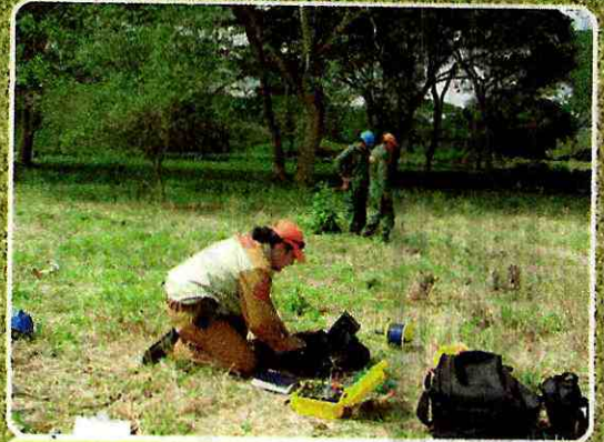
Cimentaciones: aulas escolares, edificaciones, tanques de reserva, plantas de tratamiento, sistemas de agua potable, muros de contención.
