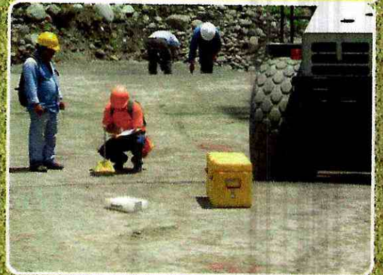
Vías: control de subrasantes, subbases, bases, geosintéticos, adoquinados, pavimentos.
