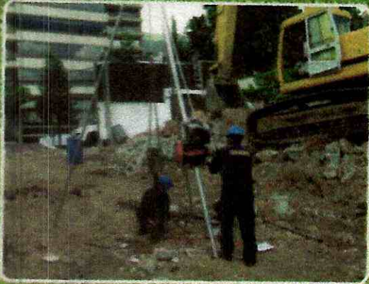
Alcantarillados: sanitarios, combinados, rellenos, mejoramientos y estabilizaciones de suelos.
