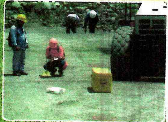
Vías: control de subrasantes, subbases, bases, geosintéticos, adoquinados, pavimentos.
