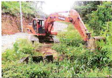
Excavación sin clasificar(mov.de tierra)
