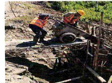
Muro de H.S. f'c=180\text{kg./cm}^2 tipo B(Cabezales)
