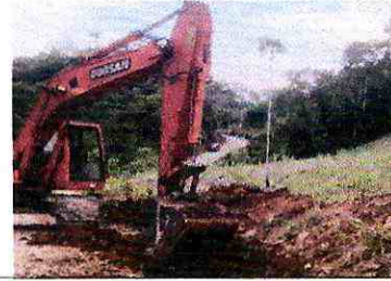
Excavación y relleno de estructuras menores
