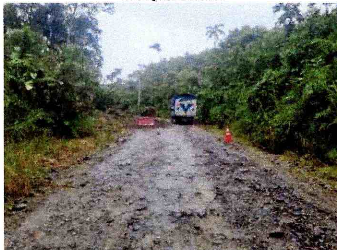
VIAS EN BUEN ESTADO PARA CIRCULACION Y MOVILIZACION DE LA MAQUINARIA
