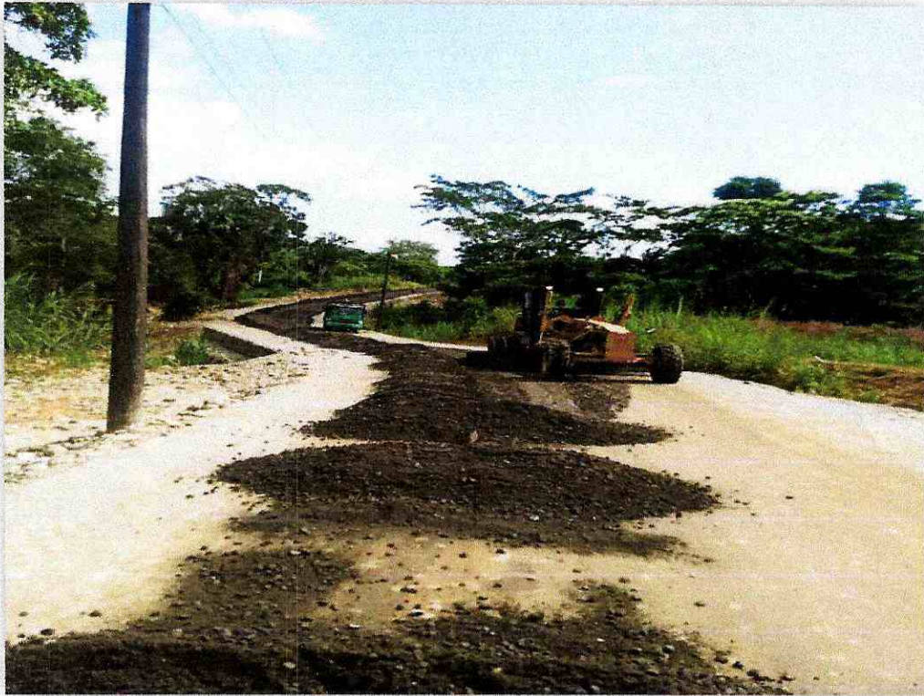
Rubro 8–Material de base granular de agregados (minada, cargada, regada)
