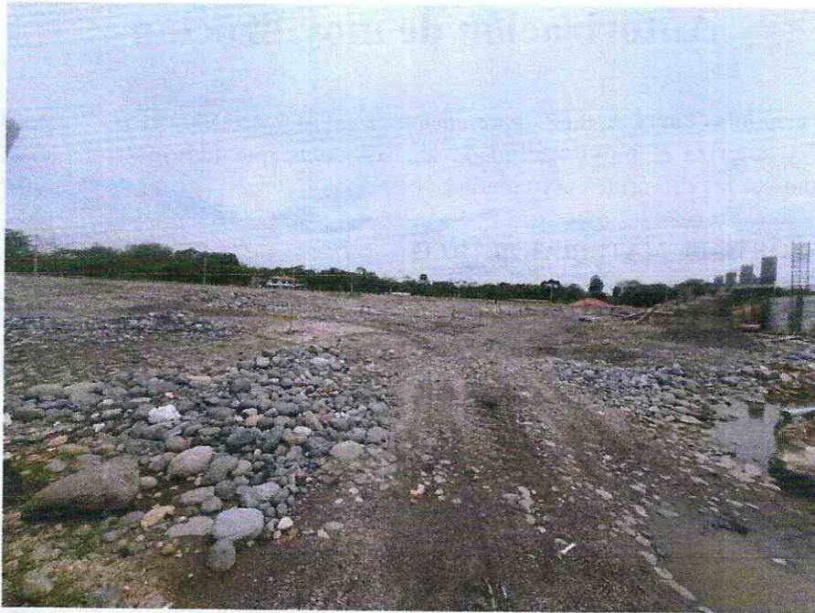
Anexo 20.- Área despejada para la movilización de la maquinaria.
