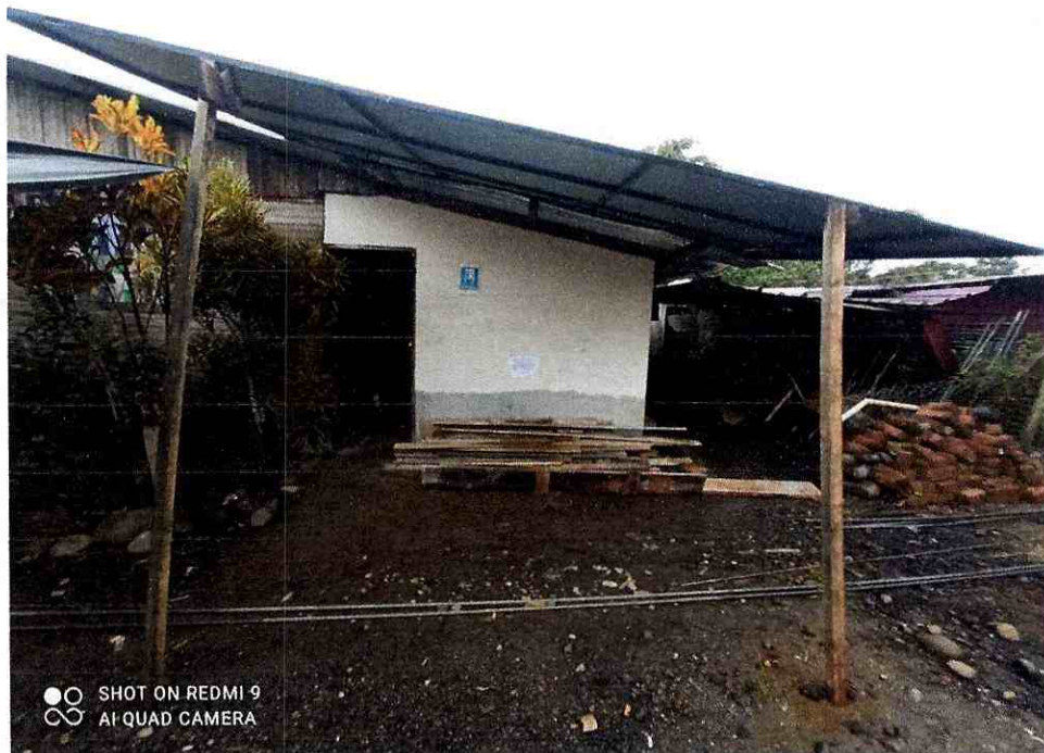
Anexo 14.- Almacenamiento temporal de residuos para su reutilización
