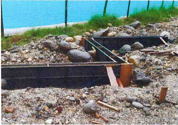
Encofrado de bordillo / Desencofrado
