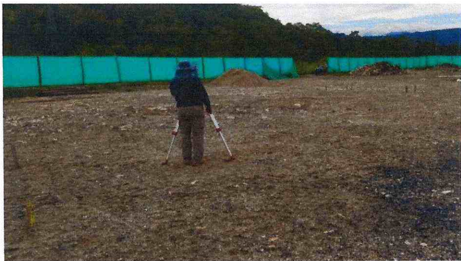
Replanteo y nivelación de bordillos.
