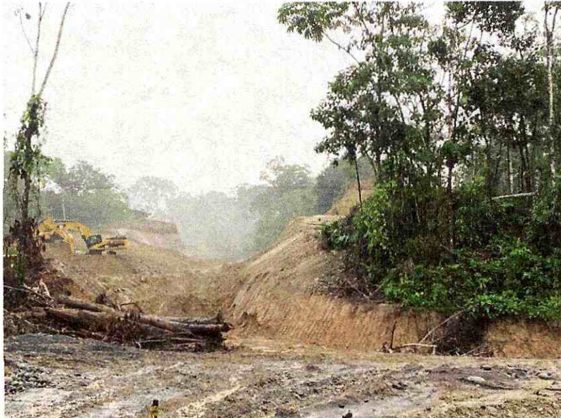
IMAGEN 4. Excavaciones en el acceso al puente
