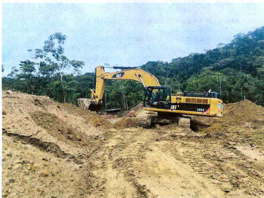
IMAGEN 1. Movimiento de Tierras en el Acceso al Puente
