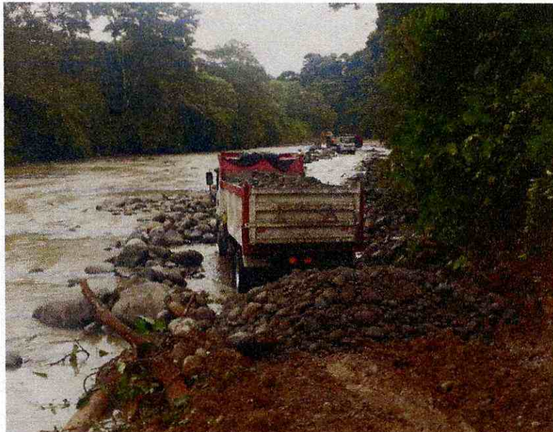
Rubro 49 – Transporte de material pétreo de subbase clase 3
