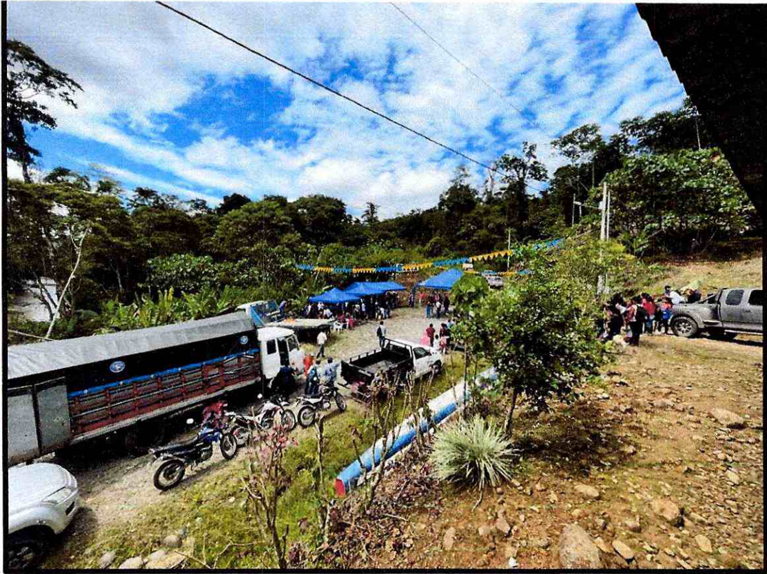
Socialización y colocación de la primera piedra
