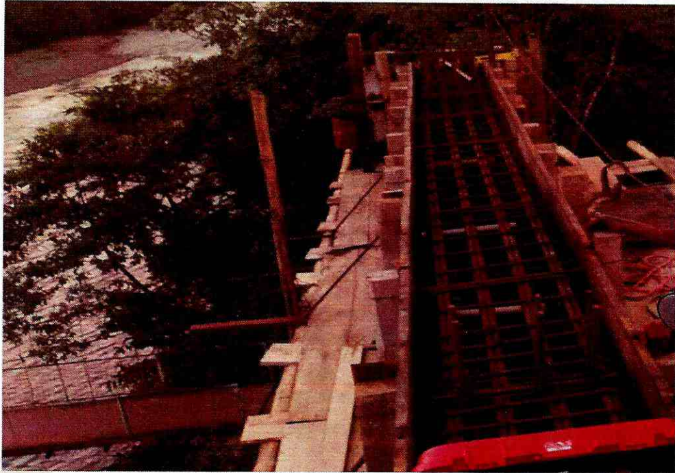
Armado de viga superior derecho
