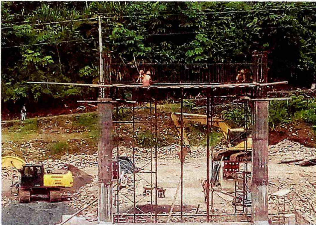
Armado de viga superior margen izquierdo.
