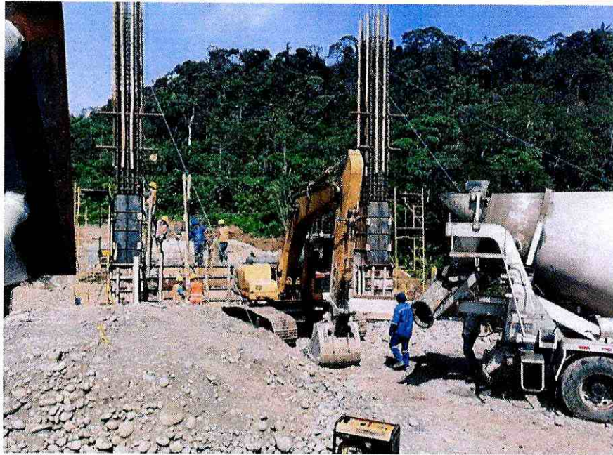
Fotografía 5. Acero de refuerzo en columnas
