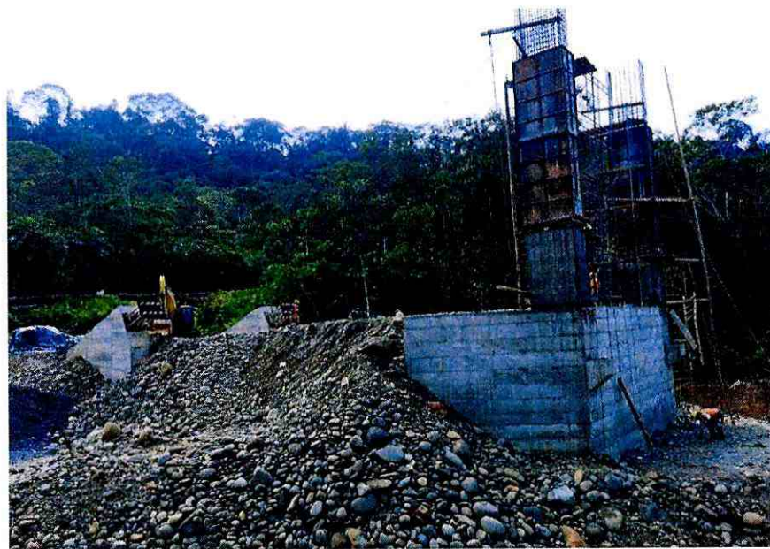
Fotografía 2. Fundido de columnas margen izquierdo.
