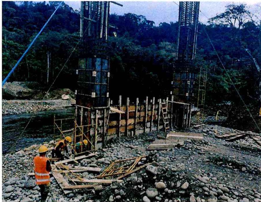
Fotografía 1. Acero de refuerzo y hormigón en columnas
