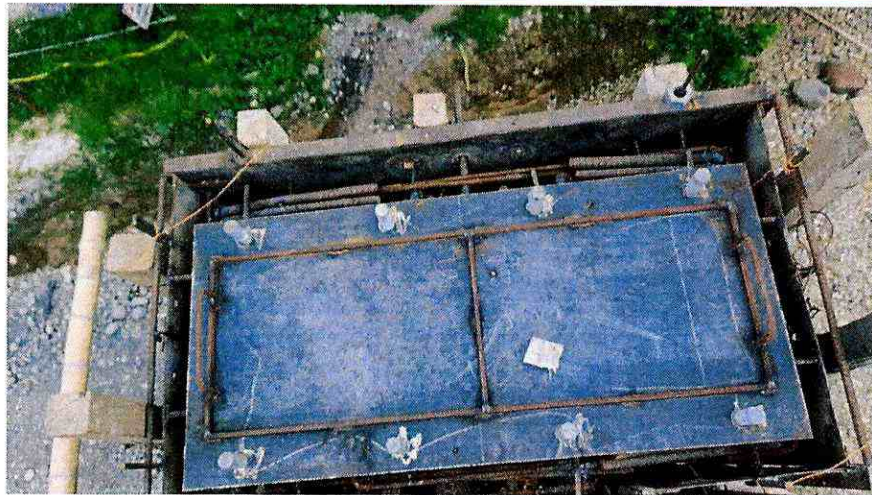
Fotografía 3. Colocación de placa previo a fundido de columnas
