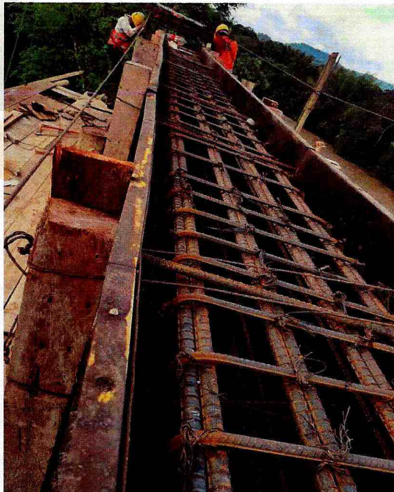
Armado de viga superior derecho
