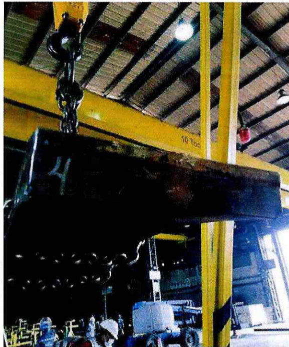
Fotografía 4. Acero A-588 maquinado CNC.
