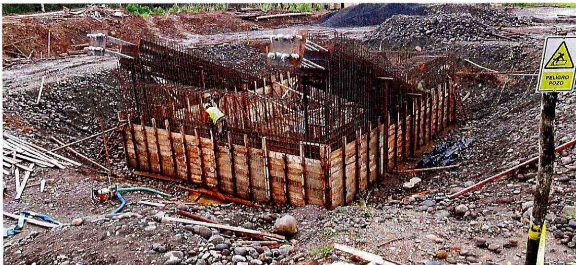
Excavación del cajón de anclaje derecho
