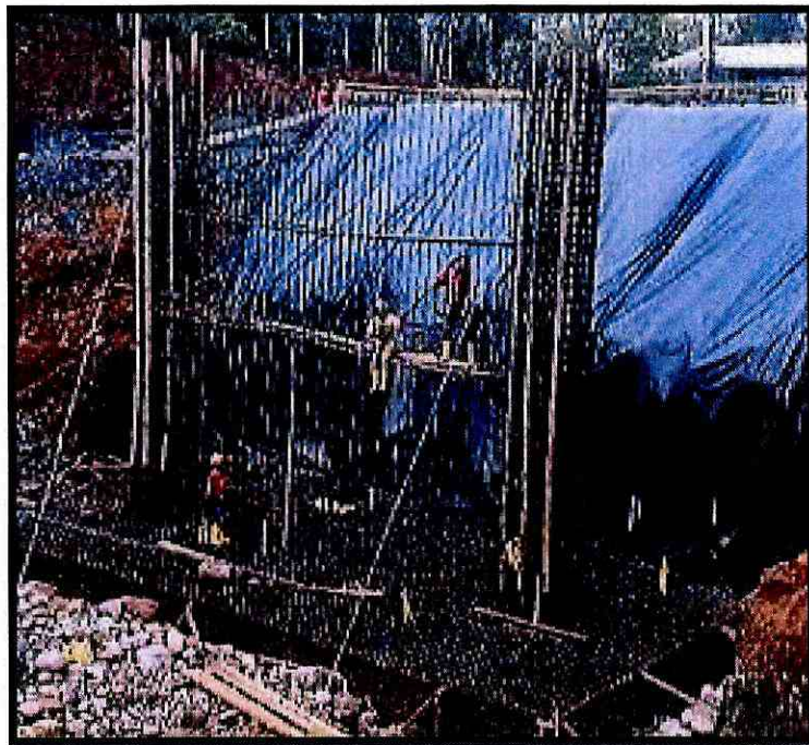
Fotografía 5. Incremento de acero de refuerzo en pantallas, margen derecho
