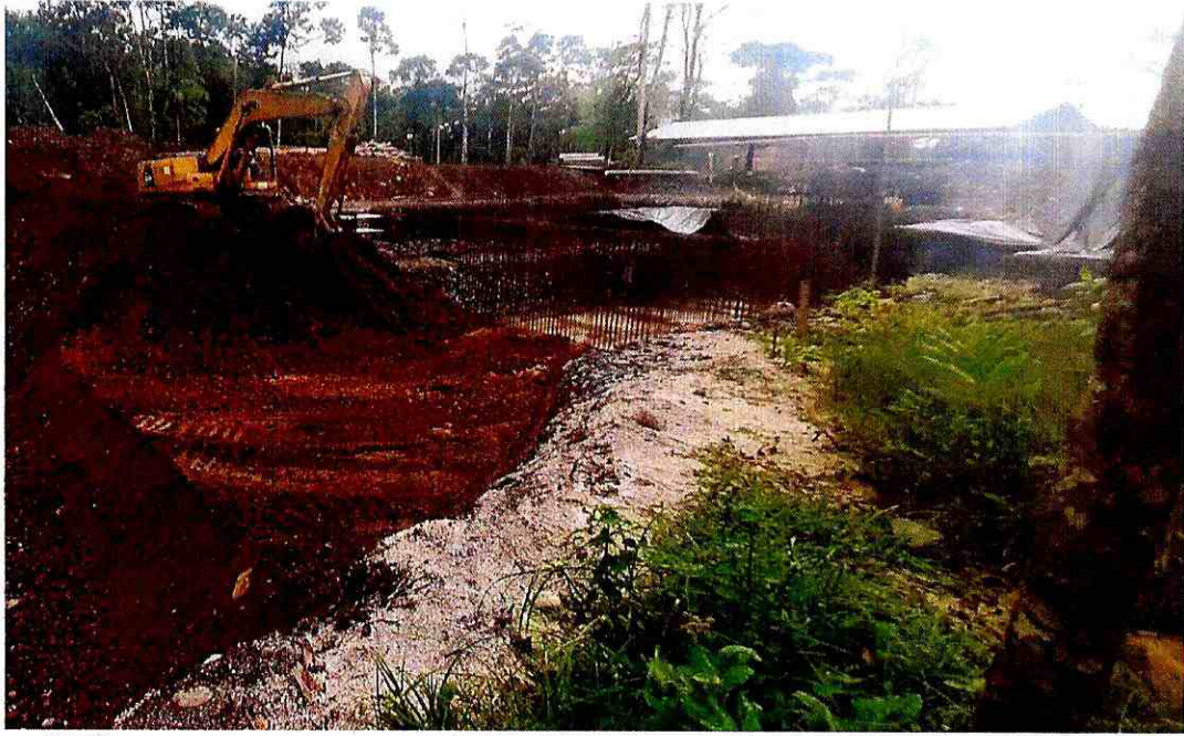
Excavación entre en anclaje y la torre
