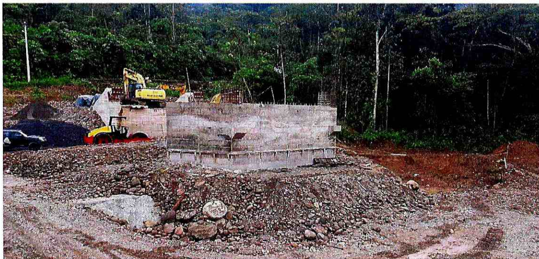
Muros torre izquierda terminados
