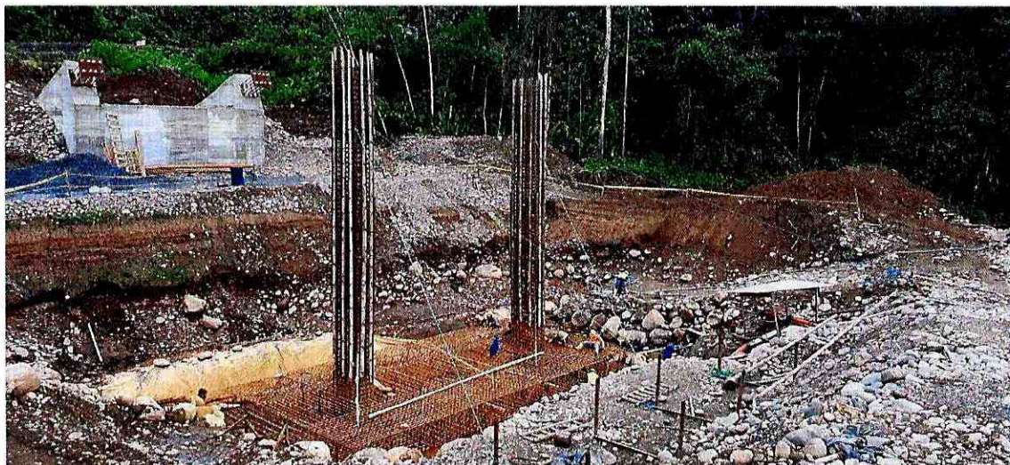
Montaje del primer tramo de columnas
