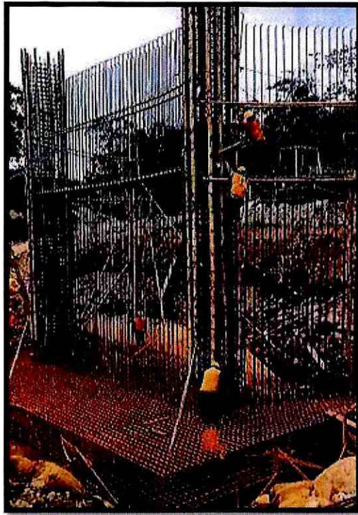
Fotografía 4. Incremento de acero de refuerzo en pantallas y muros, margen izquierdo
