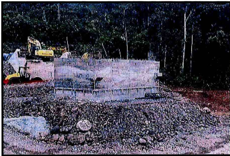
Fotografía 7. Fundido de pantallas y muros.
