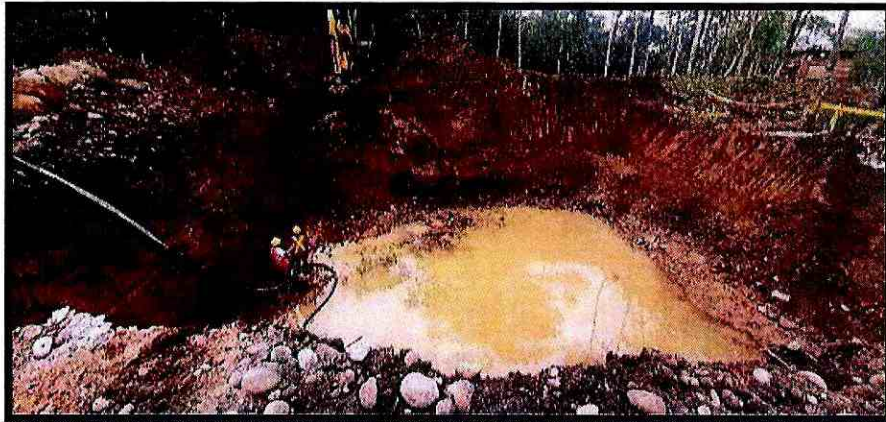
Fotografía 1. Incremento de excavación, margen derecho
