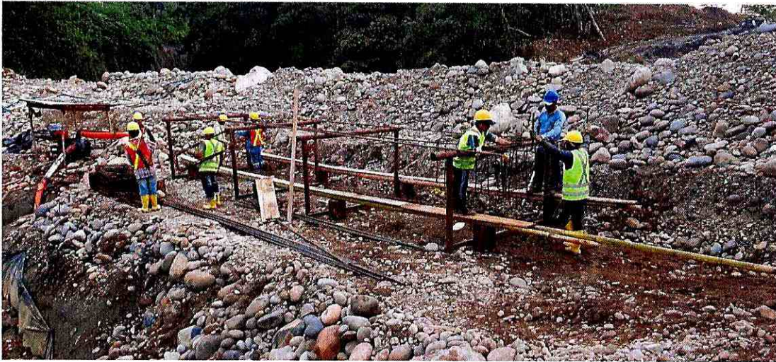
Armado y amarre de hierro de columnas
