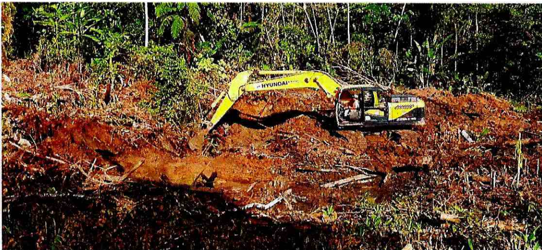
Excavación para cajón de anclaje margen izquierdo
