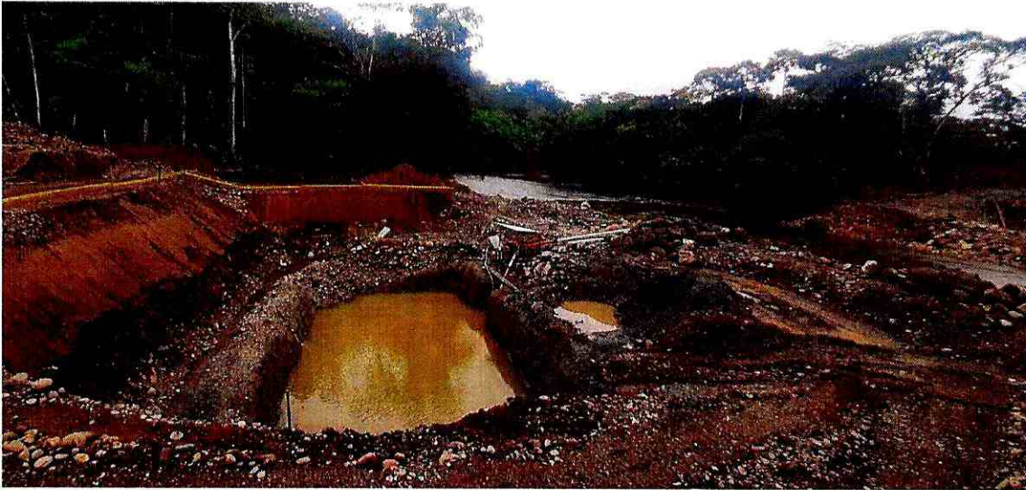
Excavación para torre izquierda Rubro 6: Acero de refuerzo en barras f_y=4200 kg/cm 2 (en puentes)
