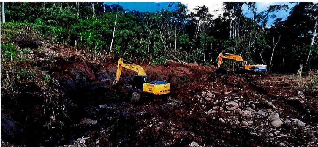
Excavación para cajón de anclaje margen izquierdo
