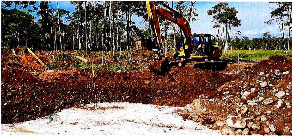
Excavación para cajón de anclaje margen derecho
