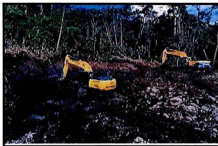
Fotografía 3. Incremento de excavación, margen izquierdo
