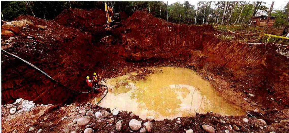
Excavación para cajón de anclaje margen derecho
