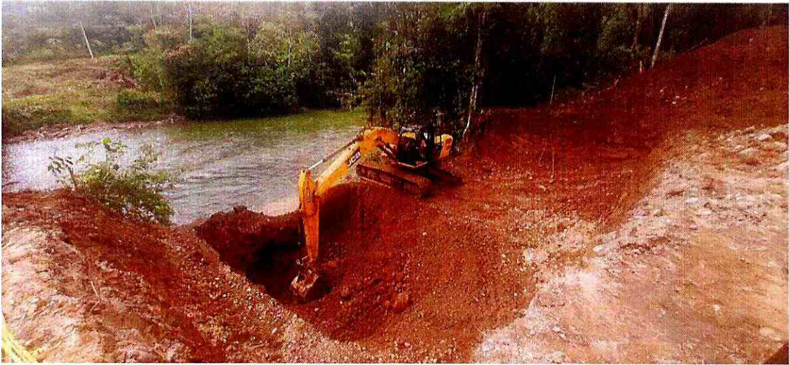
Excavación para cimiento de torre margen derecho
