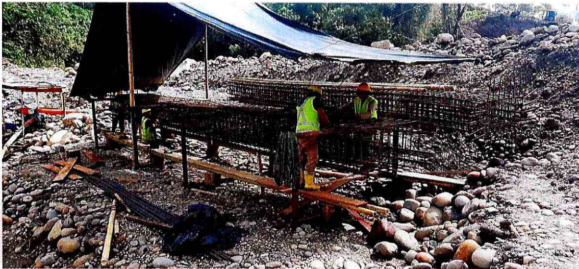
Armado y amarre de hierro de columnas
