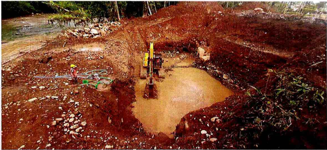
Excavación para cimiento de torre margen derecho
