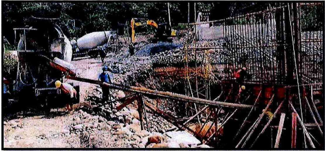
Fotografía 6. Incremento hormigón en muros, margen izquierdo
