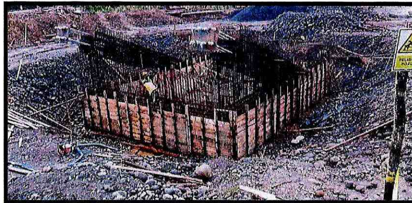
Fotografía 2. Incremento de excavación, margen derecho
