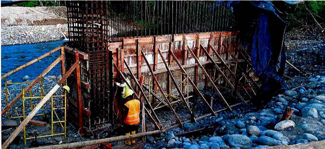
Encofrado tramo 2
