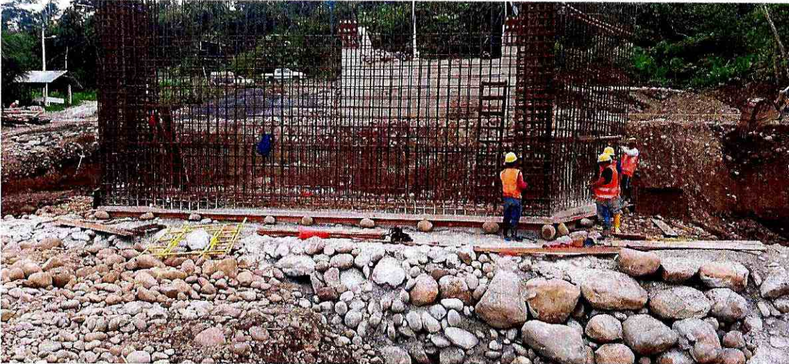
Viga intermedia, pantalla y muros de ala
