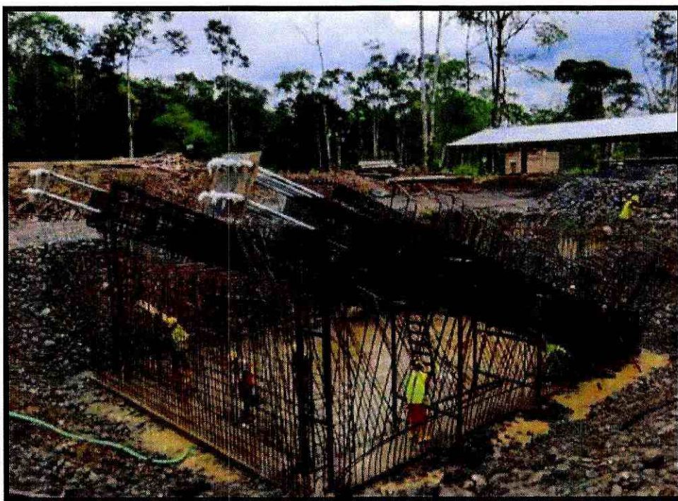
Fotografía 7. Anclajes margen derecho
