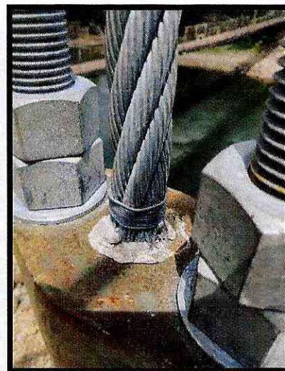
Fotografía 3. Revisión del proceso de soldadura e instalación de las péndolas
