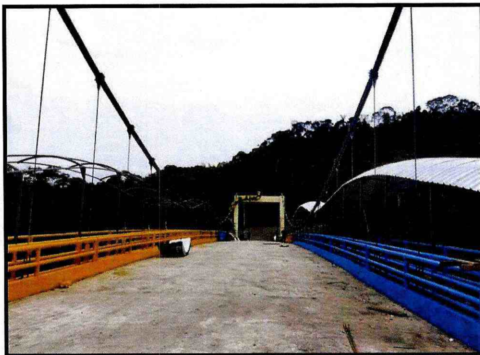
Fotografía 16. Estructura metálica en pasarelas peatonales.
