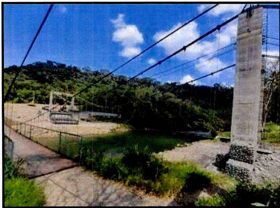
Fotografía 12. Montaje de estructura de Puente
