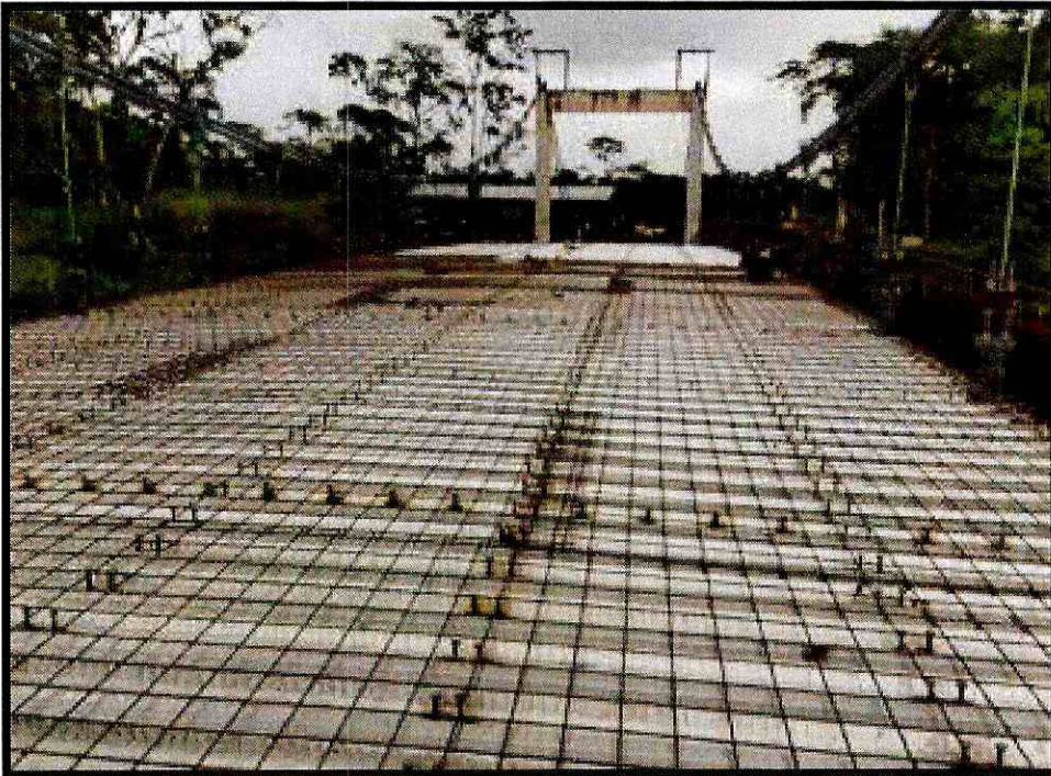
Fotografía 13. Montaje y armado de losa
