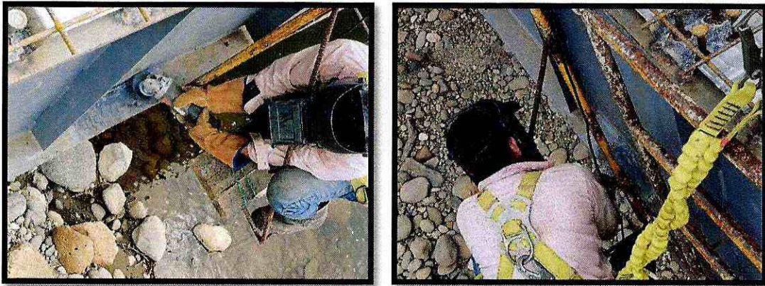
Fotografía 4. Inspección de proceso soldadura, limpieza con maquina de los cordones de soldadura
