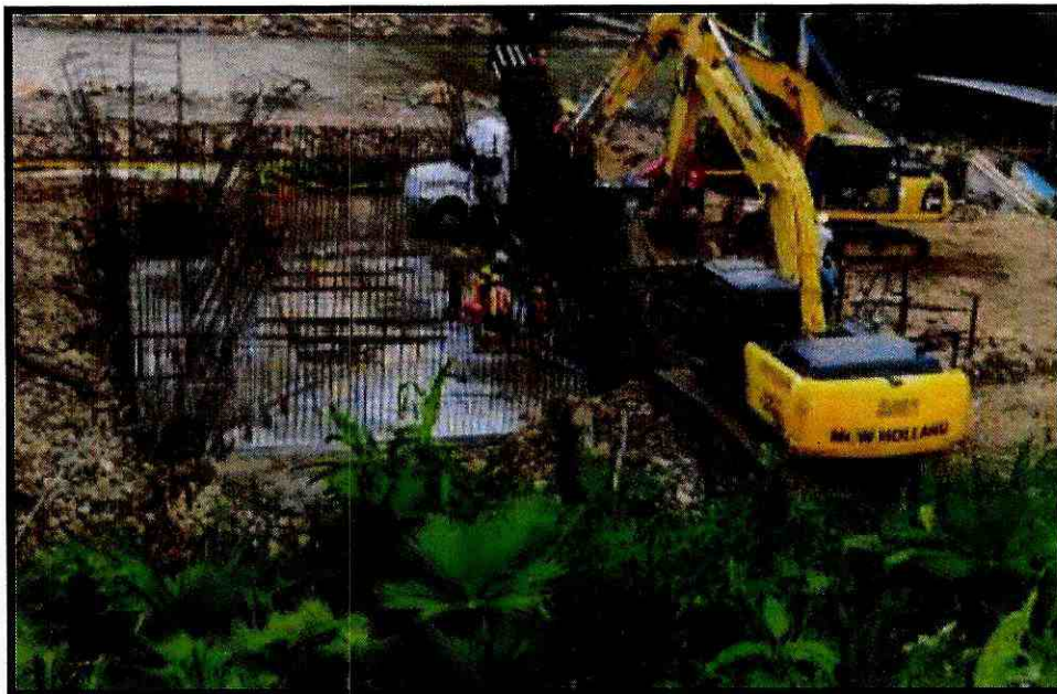
Fotografía 6. Colocación de elementos mecánicos de anclaje
