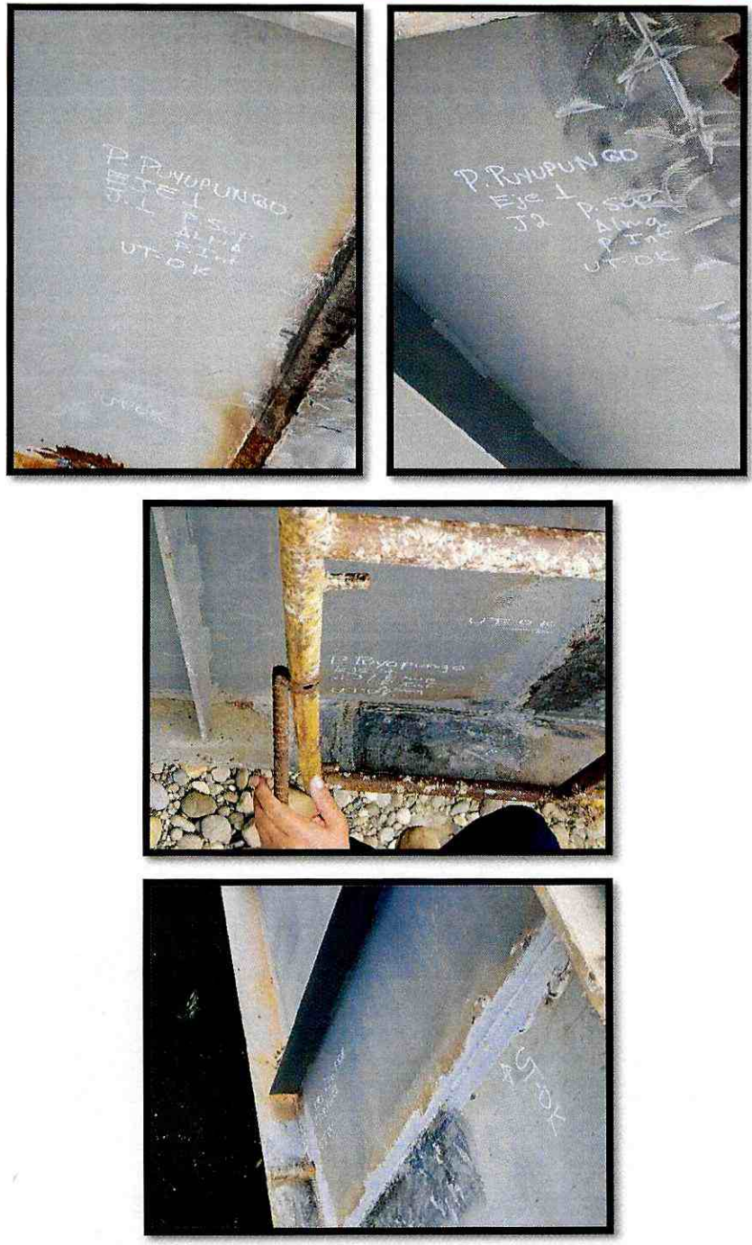
Fotografía 7. Inspección de proceso soldadura, registro de puntos inspeccionados
