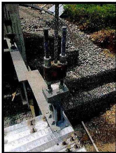
Fotografía 3. Revisión del proceso de soldadura e instalación de las péndolas
