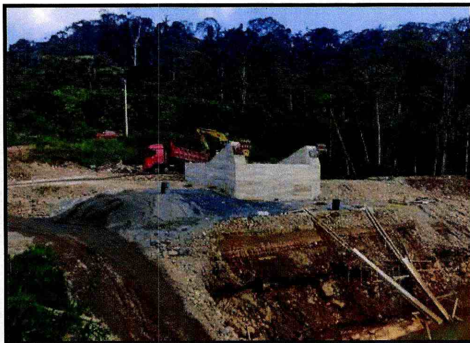
Fotografía 8. Fundido de anclajes
