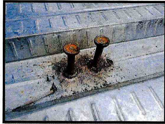
Fotografía 1. Inspección de proceso soldadura, puntos de anclaje al hormigón
