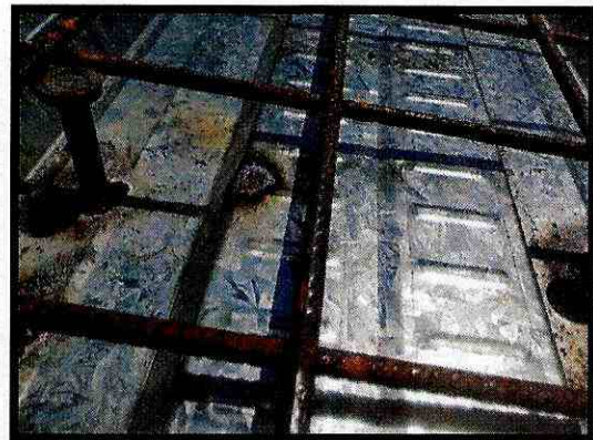
Fotografía 2. Inspección de proceso soldadura, instalación de malla electrosoldada.
