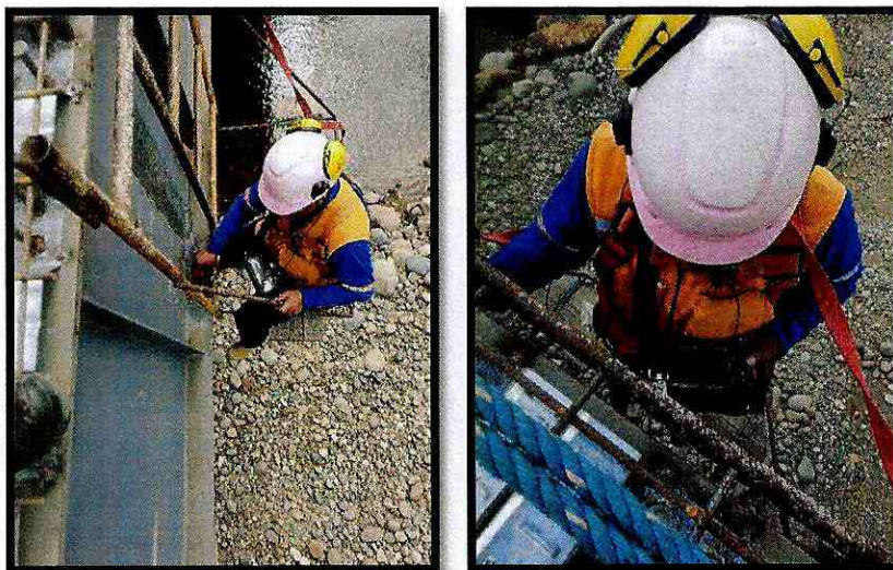
Fotografía 6. Inspección de proceso soldadura, ensayo de ultrasonido
