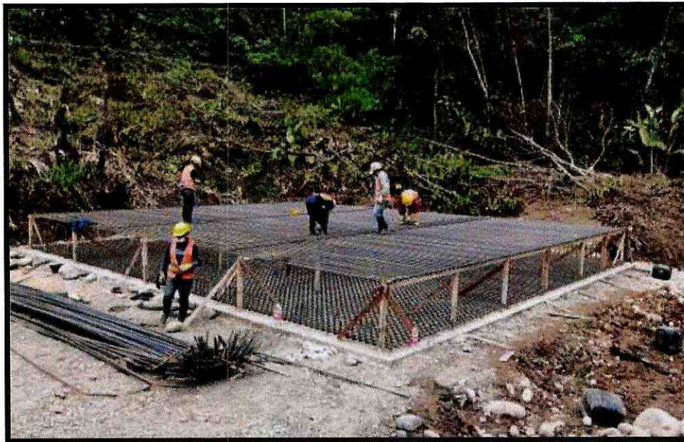
Fotografía 4. Cimentaciones en anclajes.
