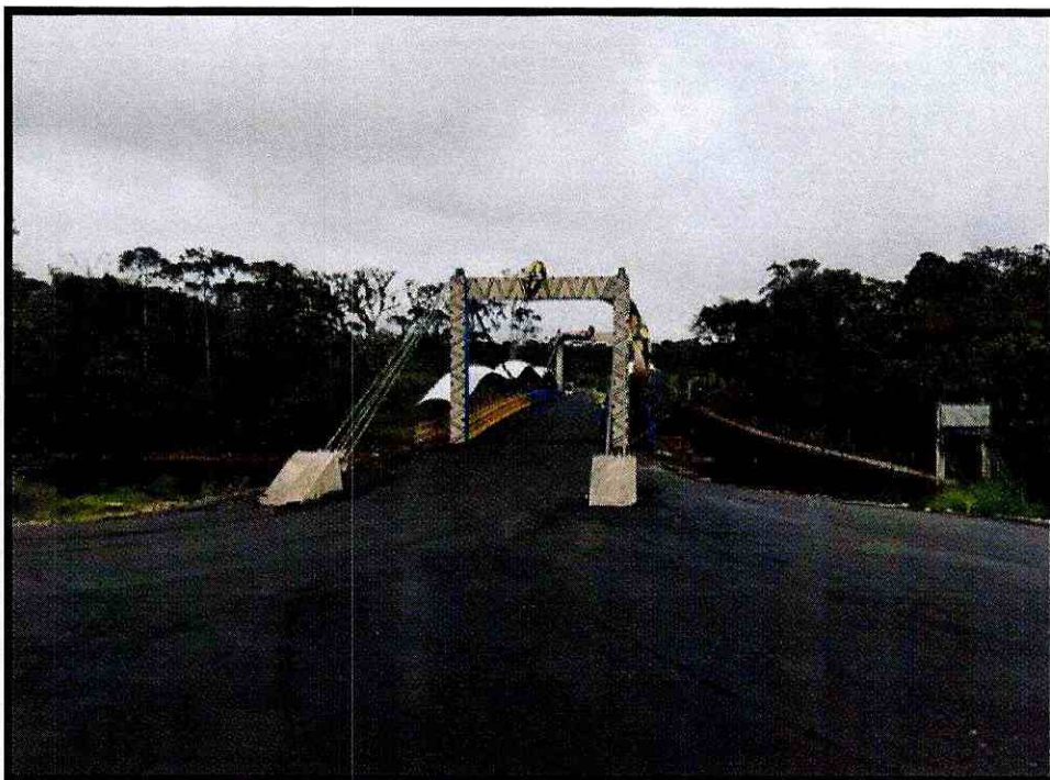
Fotografía 4. Asfaltado de accesos
