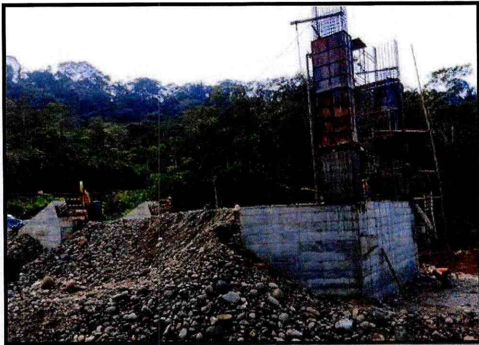
Fotografía 10. Torre margen izquierdo.
