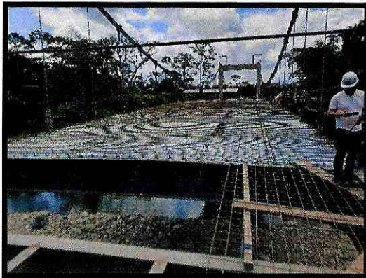
Fotografía 2. Inspección de proceso soldadura, instalación de malla electrosoldada.
