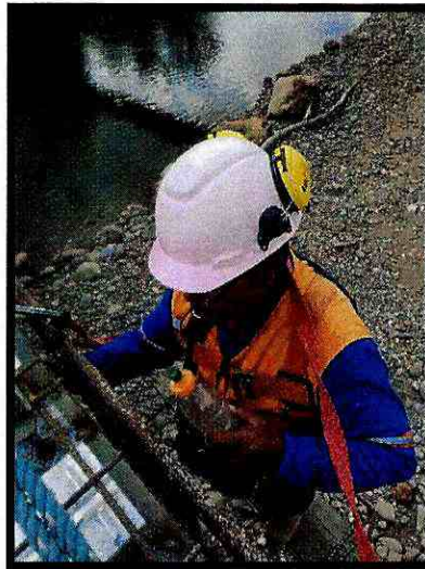
Fotografía 5. Inspección de proceso soldadura, limpieza con desengrasante
