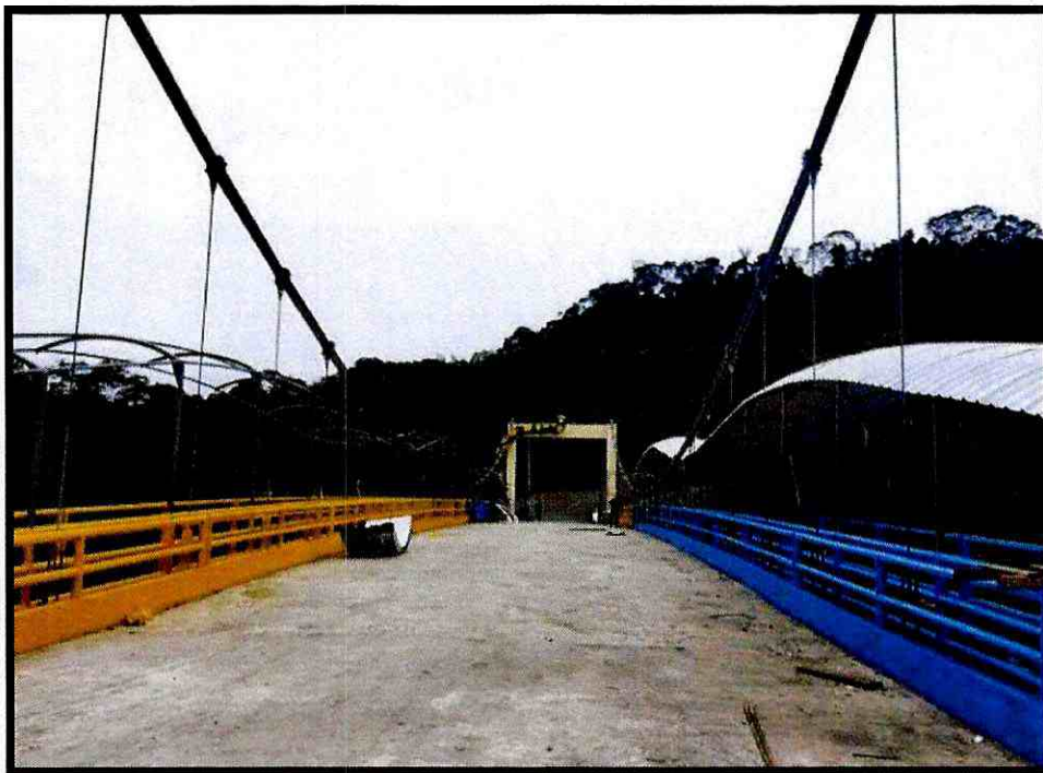
Fotografía 2. Estructura metálica en pasarelas peatonales.
