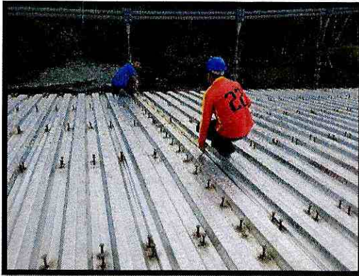
Fotografía 1. Inspección de proceso soldadura, puntos de anclaje al hormigón
