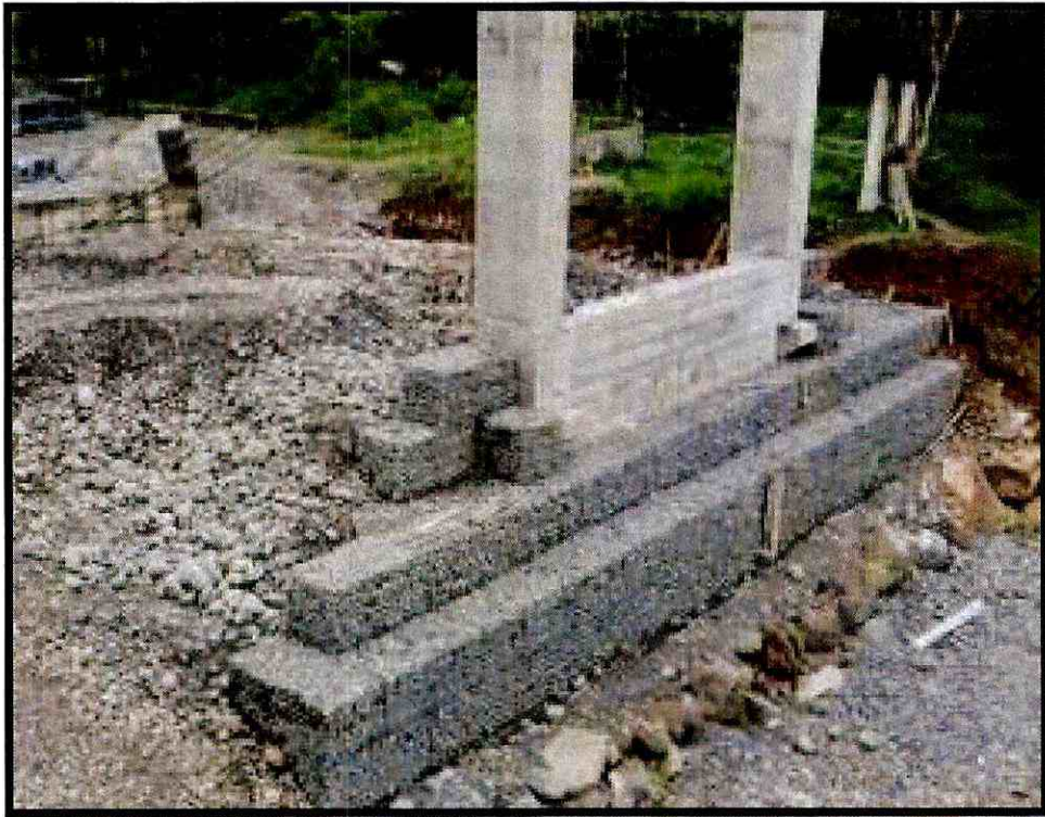
Fotografía 11. Gaviones margen derecho
