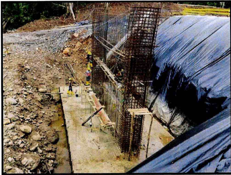
Fotografía 9. Muros margen derecho.
