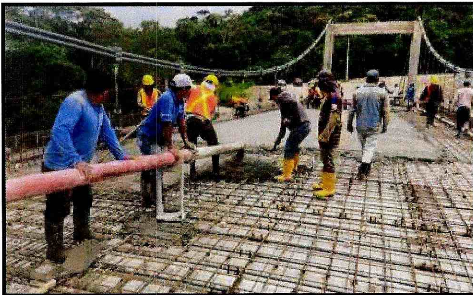
Fotografía 14. Fundido de losa
