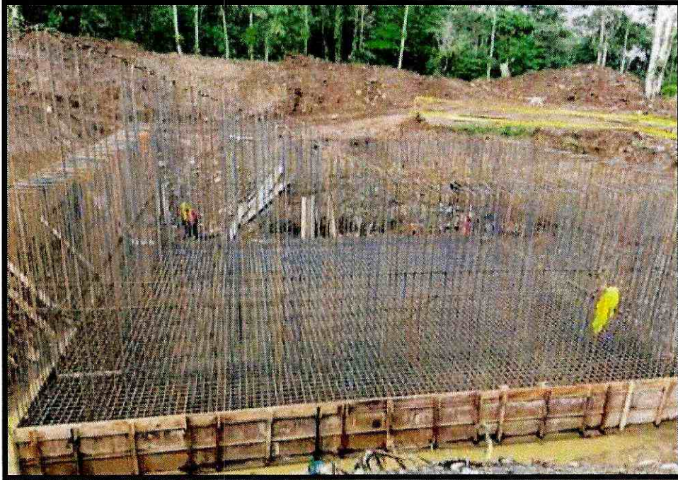
Fotografía 5. Armado de anclajes
