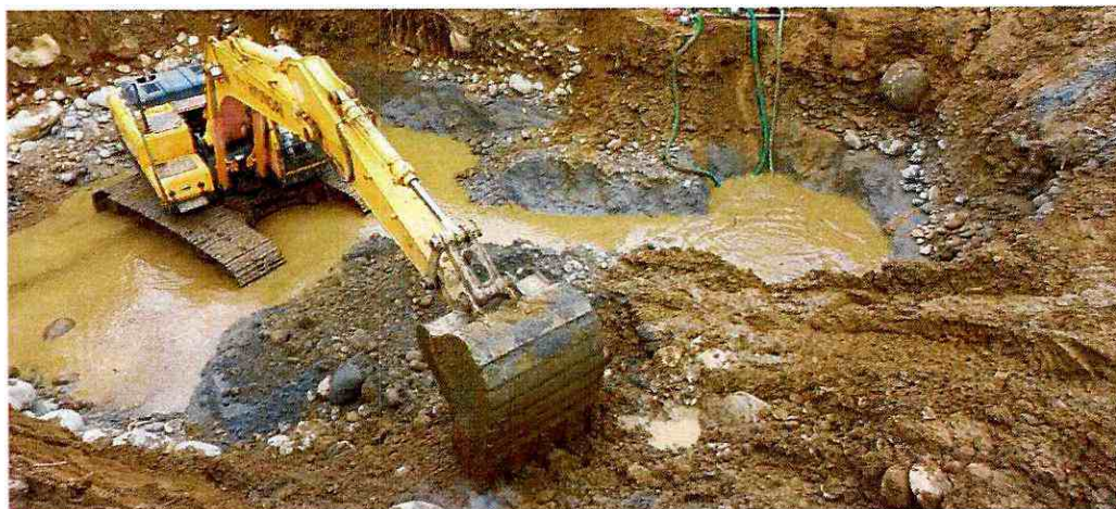
Fotografía No. 2. Excavación para torre margen izquierdo.
