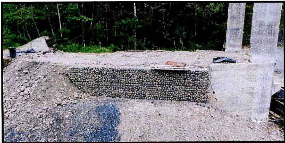
Fotografía 2. Muros de gaviones, margen izquierdo
