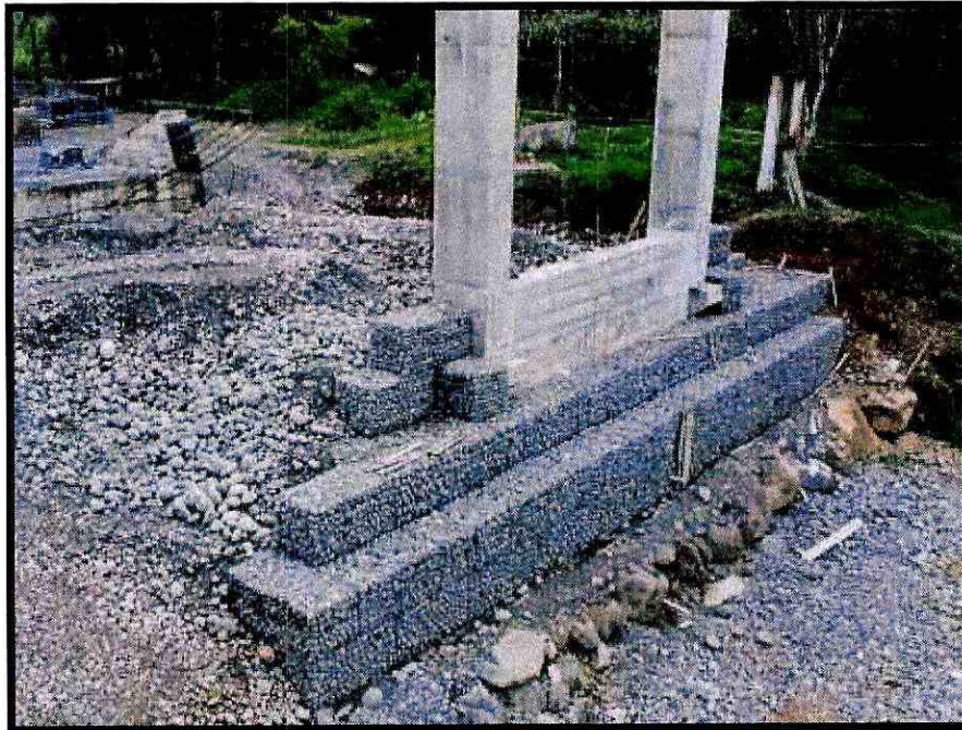
Fotografía 3. Muros de gaviones, margen derecho
