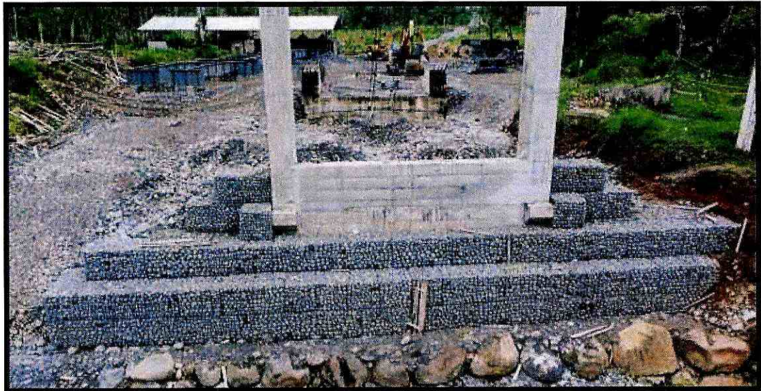
Fotografía 1. Muros de gaviones, margen derecho
