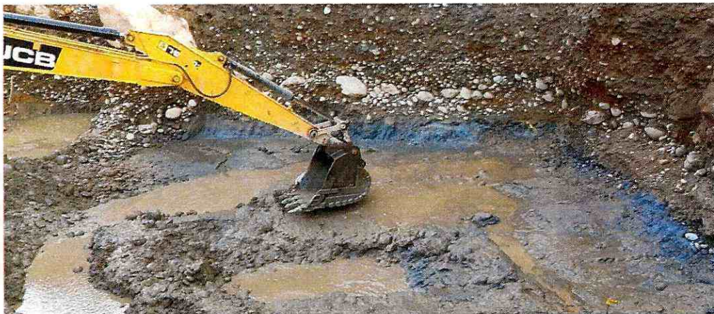
Fotografía No. 1. Excavación para torre margen derecho.
