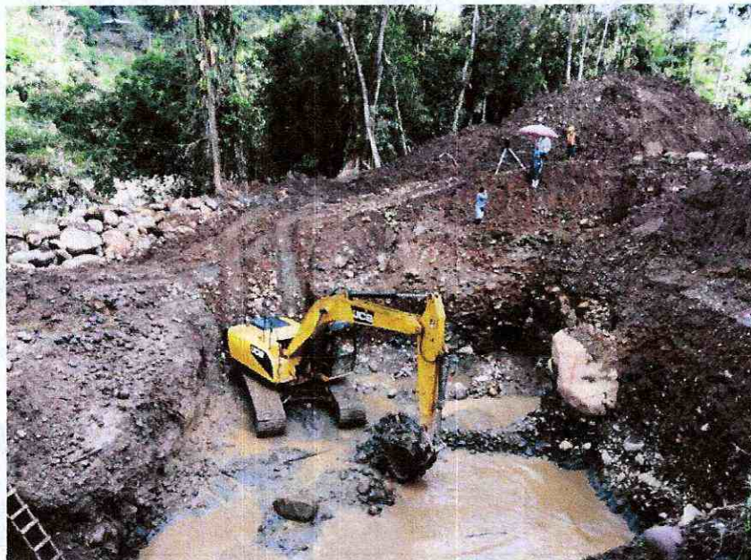
Fotografía 7. Excavación de anclajes - margen derecho.
