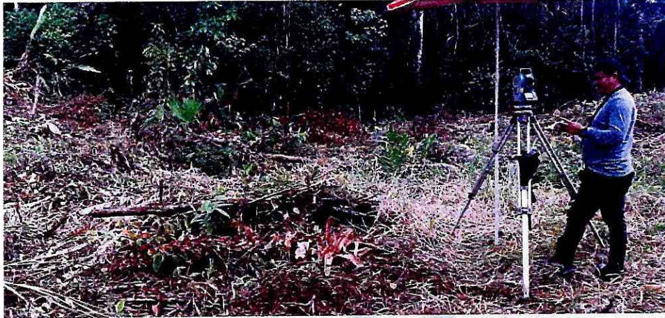
Fotografía 5: Replanteo y nivelación margen izquierdo del puente
