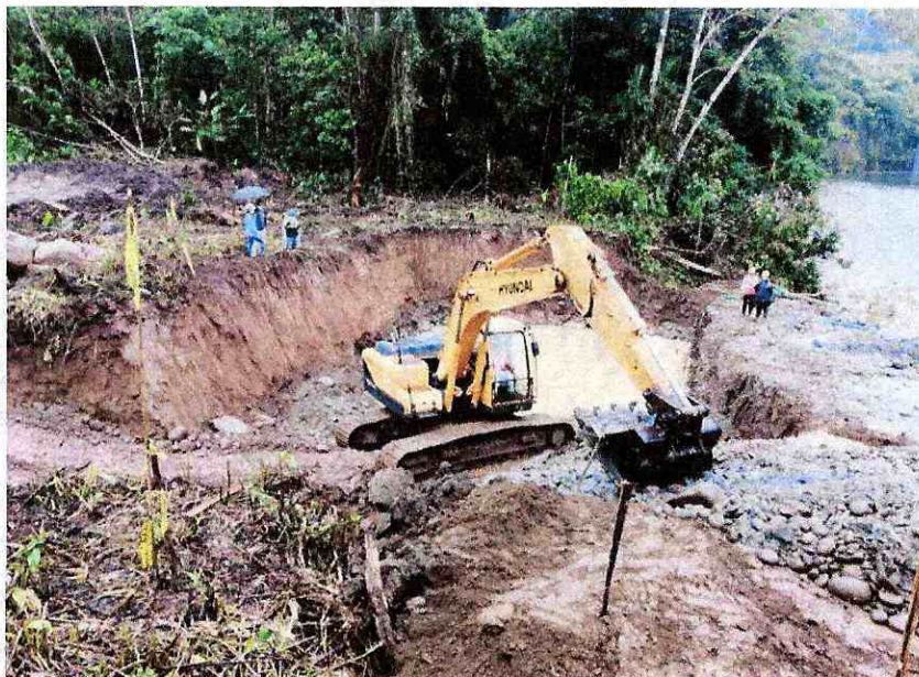
Fotografía 5. Excavación de cimentación, margen izquierdo.
