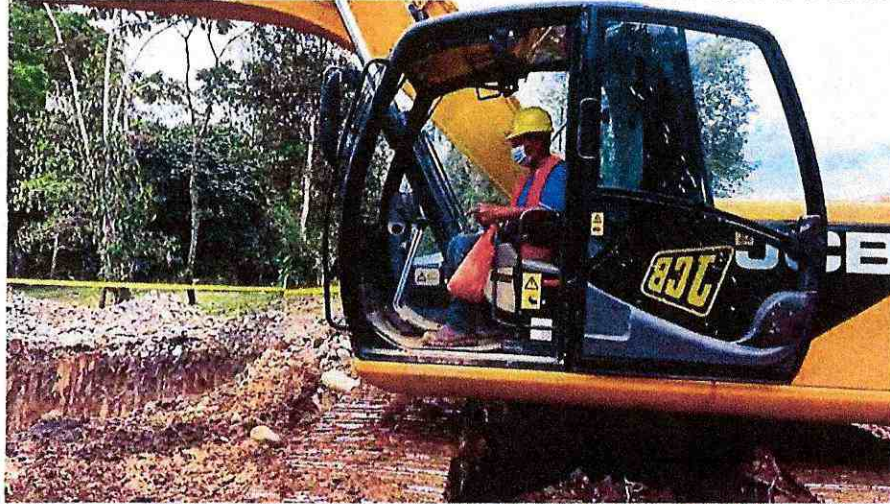
Fotografía 5. DOTACIÓN DE FUNDAS PLÁSTICAS A OPERADOR DE MAQUINARIA PESADA
