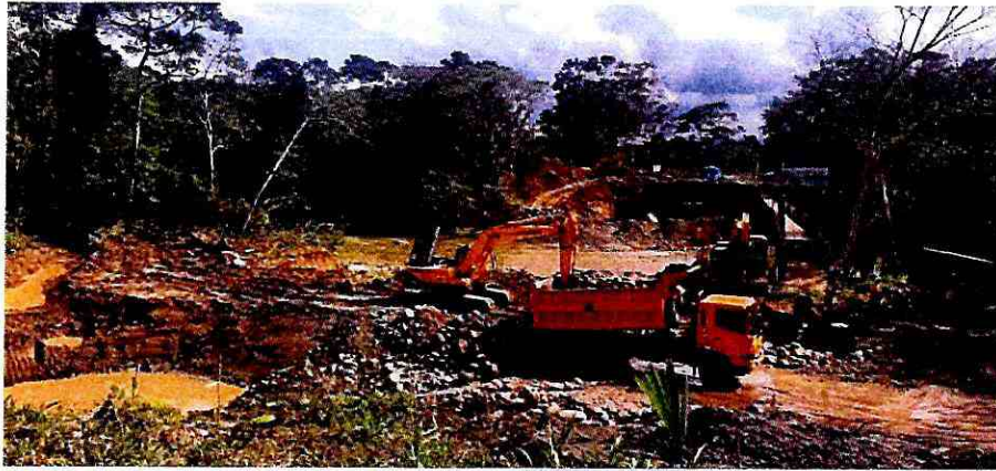
Fotografía 17: Cajón de anclaje margen izquierdo
