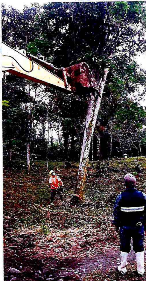
Fotografía 4: Desbroce, desbosque y limpieza margen derecho
