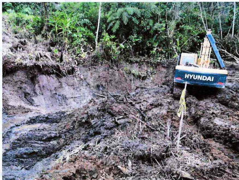
Fotografía 8. Excavación de anclaje, margen izquierdo.
