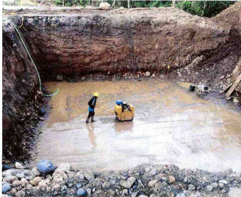
Fotografía 9. Relleno y compactación para anclaje - margen derecho.
