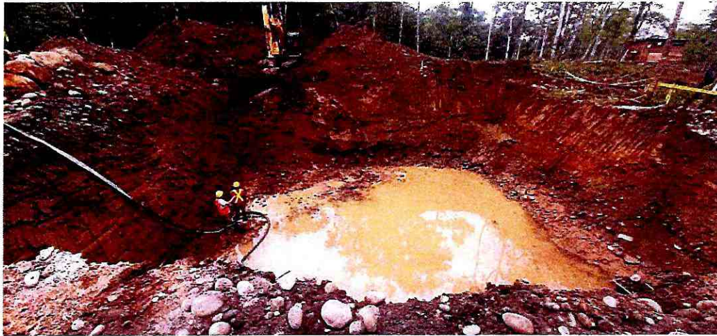
Fotografía 11: Excavación para cajón de anclaje margen derecho
