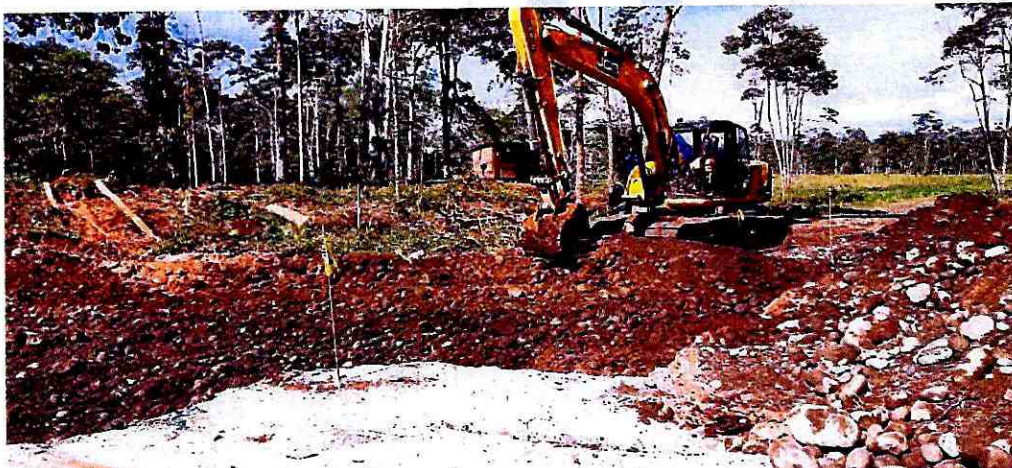
Fotografía 9: Excavación para cajón de anclaje margen derecho
