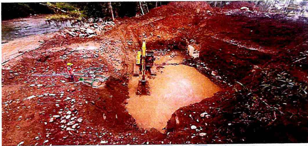
Fotografía 8: Excavación para cimiento de torre margen derecho
