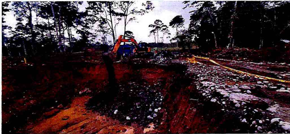
Fotografía 15: Cajón de anclaje margen derecho
