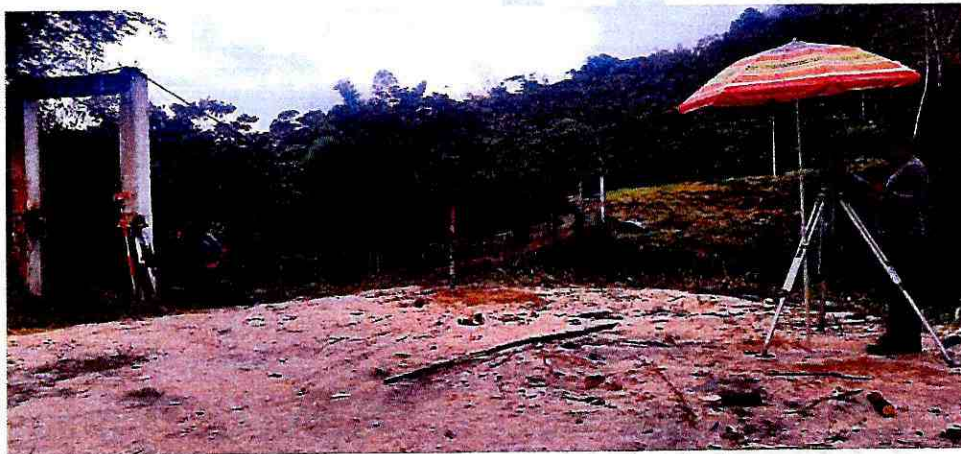
Fotografía 6: Replanteo y nivelación margen derecho del puente
