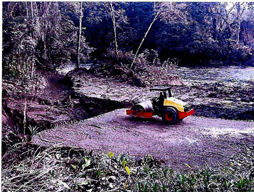
Fotografía 19: Cajón de anclaje margen izquierdo
