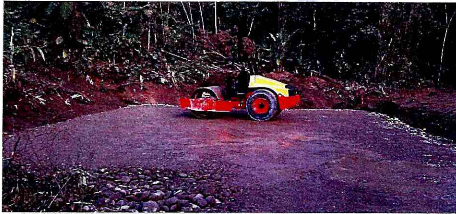
Fotografía 18: Cajón de anclaje margen izquierdo
