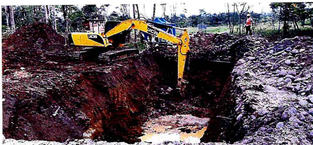
Fotografía 10: Excavación para cajón de anclaje margen derecho
