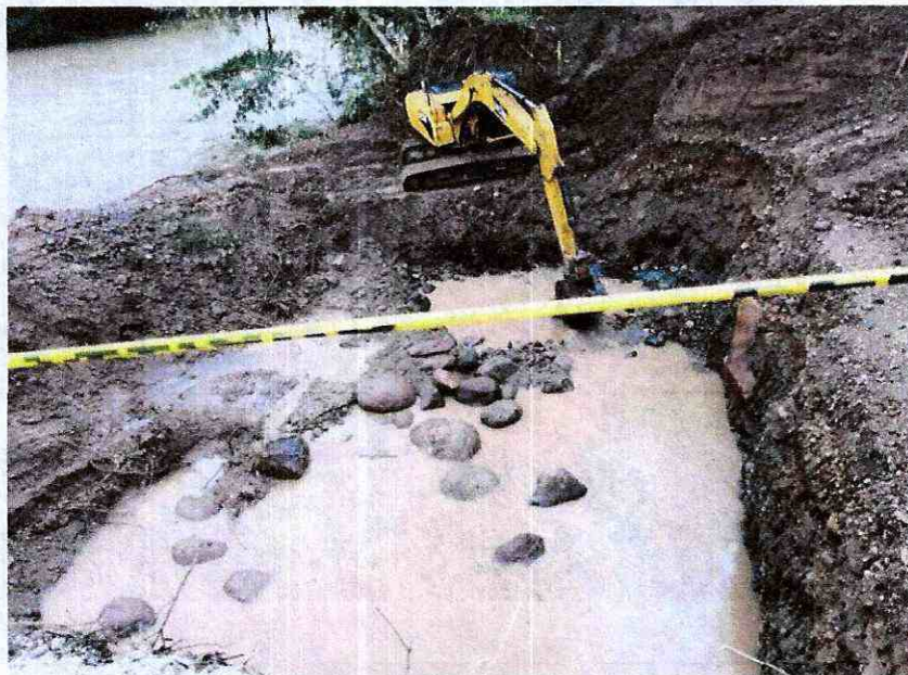
Fotografía 4. Excavación de cimentación - margen derecho
