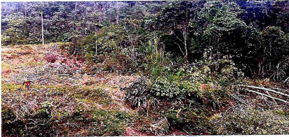
Fotografía 3: Desbroce, desbosque y limpieza margen izquierdo
