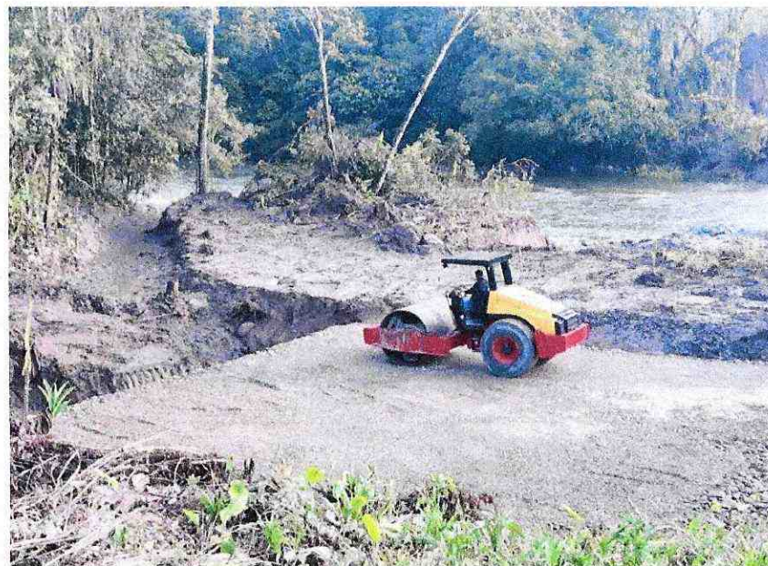
Fotografía 10. Relleno y compactación para anclaje - margen derecho
