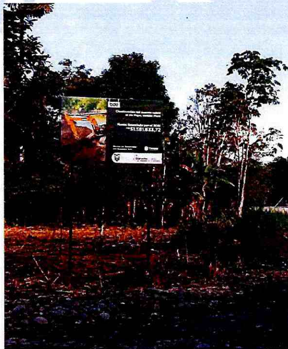
Fotografía 2: Rótulo al margen derecho del puente (Puyupungo)
