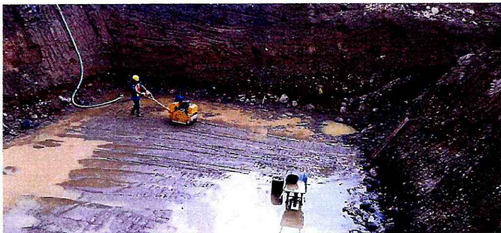
Fotografía 16: Cajón de anclaje margen derecho
