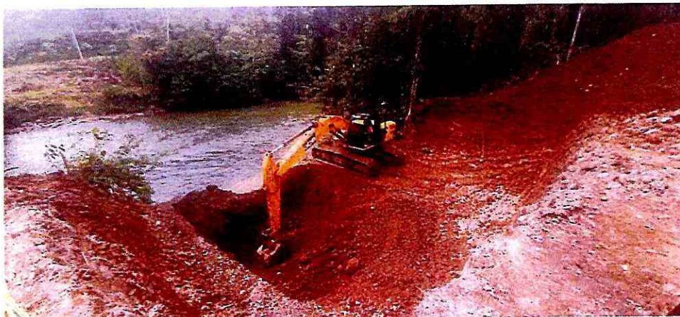
Fotografía 7: Excavación para cimiento de torre margen derecho
