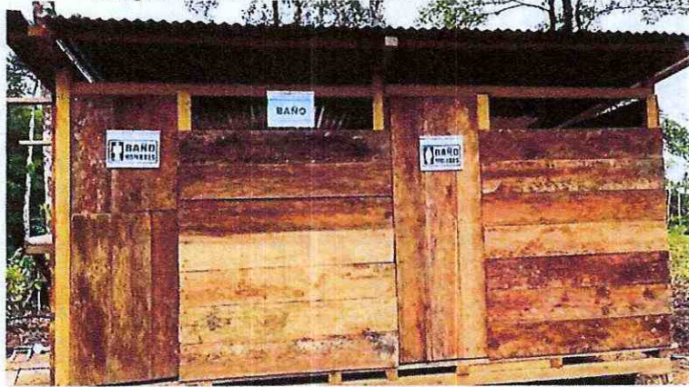
Fotografía 7. IMPLEMENTACIÓN DE BATERIAS SANITARIAS
