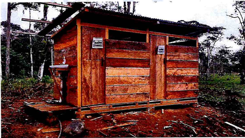
Fotografía 21: Letrina ubicada al margen derecho junto a la bodega
