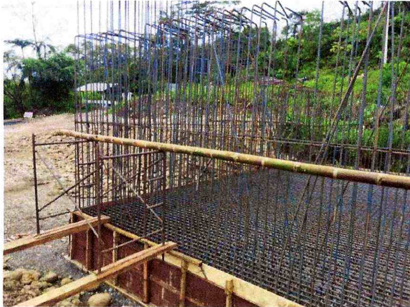
Fotografía 1. Encofrado de cimentación y acero de refuerzo vertical – margen izquierdo
