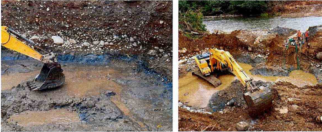
Fotografía No. 1. Excavaciones para torres
