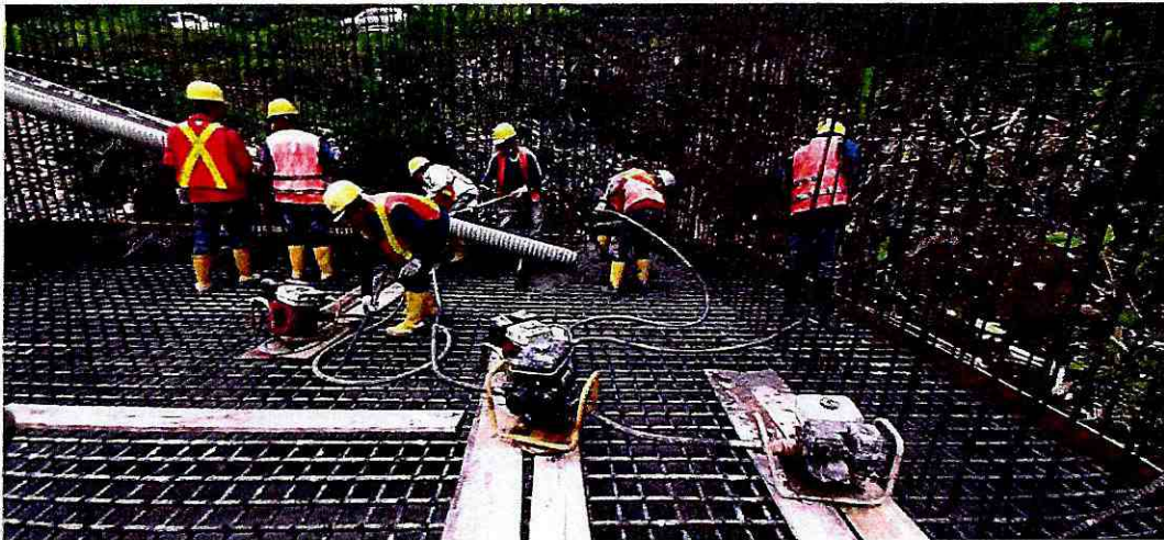
Fotografía 35: Fundido de zapata
