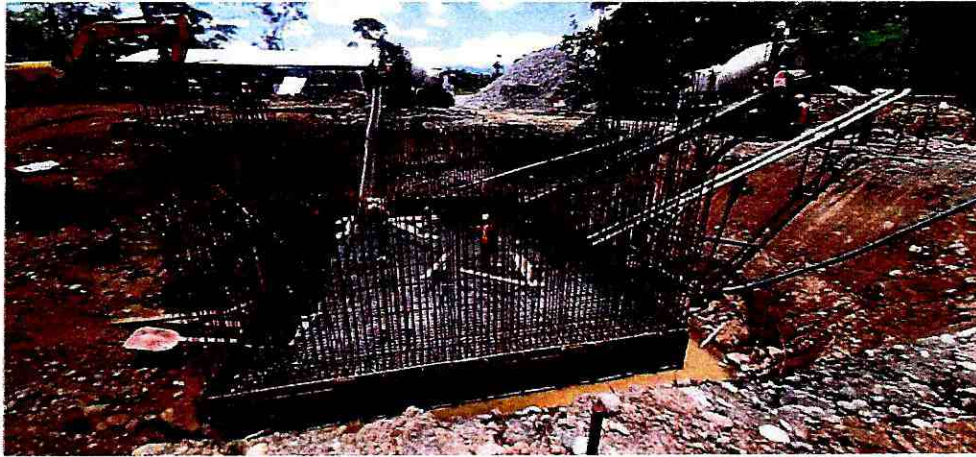
Fotografía 25: Fundido de zapata
