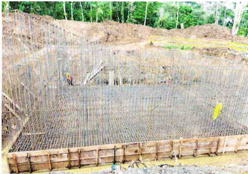
Fotografía 2. Encofrado de cimentación y acero de refuerzo vertical – margen derecho
