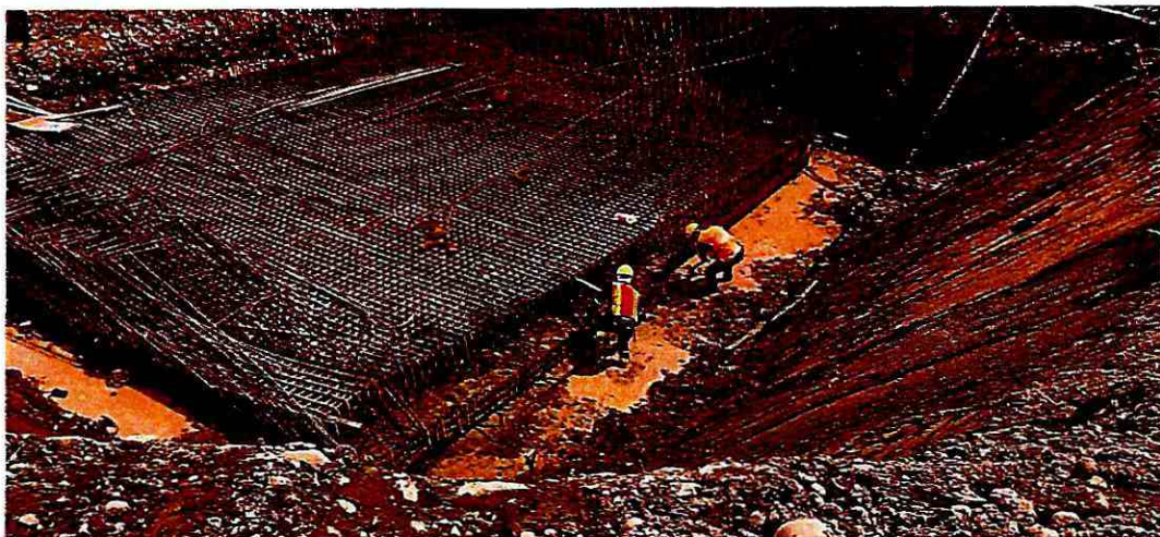
Fotografía 6: Limpieza del área
