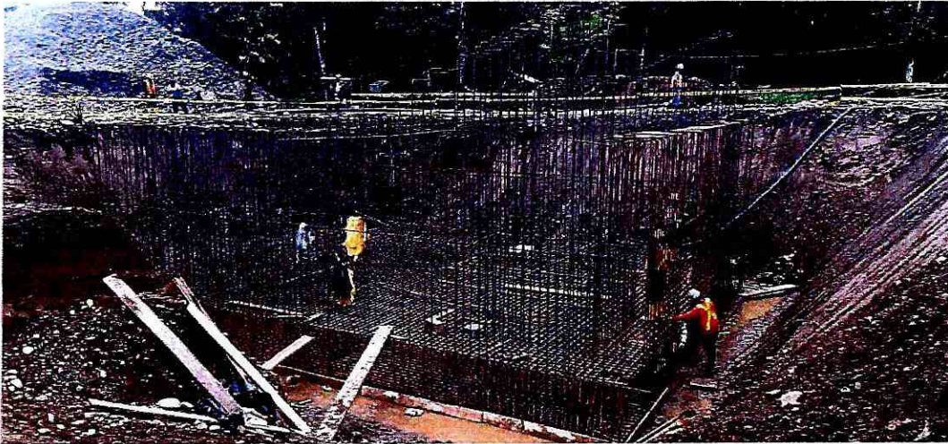
Fotografía 13: Armado de la parrilla superior de la zapata
