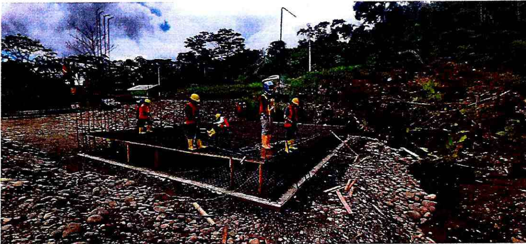
Fotografía 17: Armado de hierro vertical de paredes
