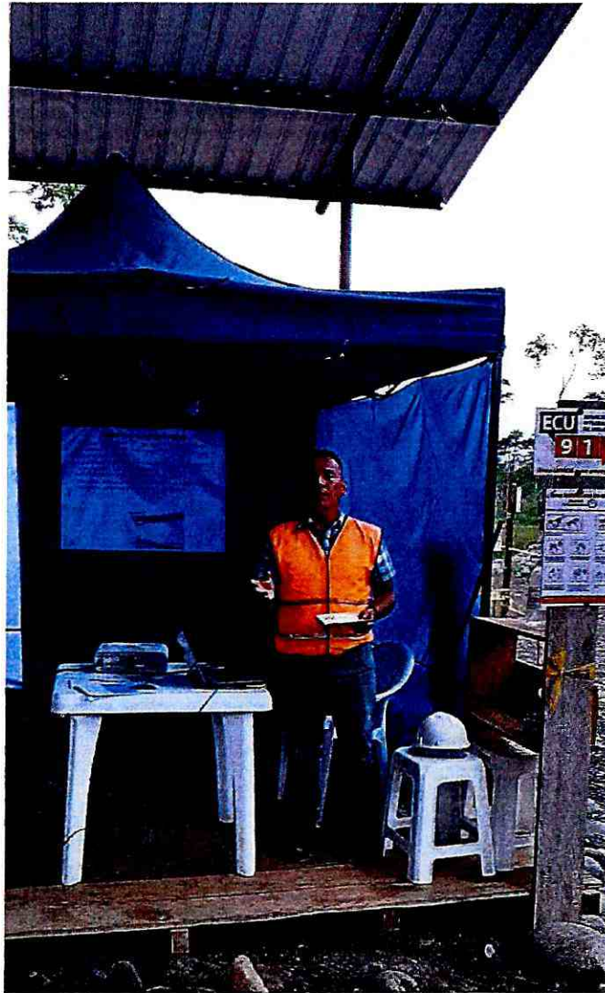
Fotografía 42: Charla impartida al personal de la obra
