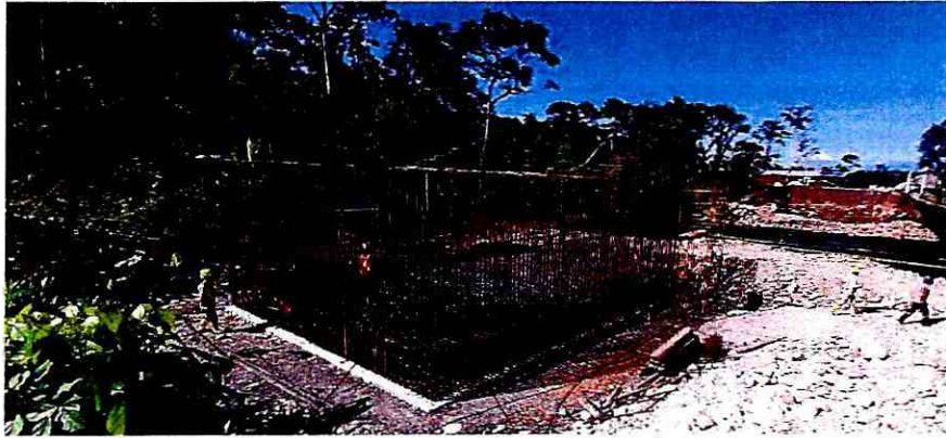
Fotografía 19: Armado de hierro vertical de paredes
