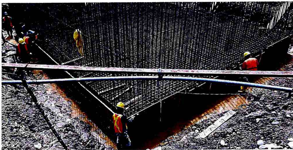
Fotografía 21: Encofrado de zapata
