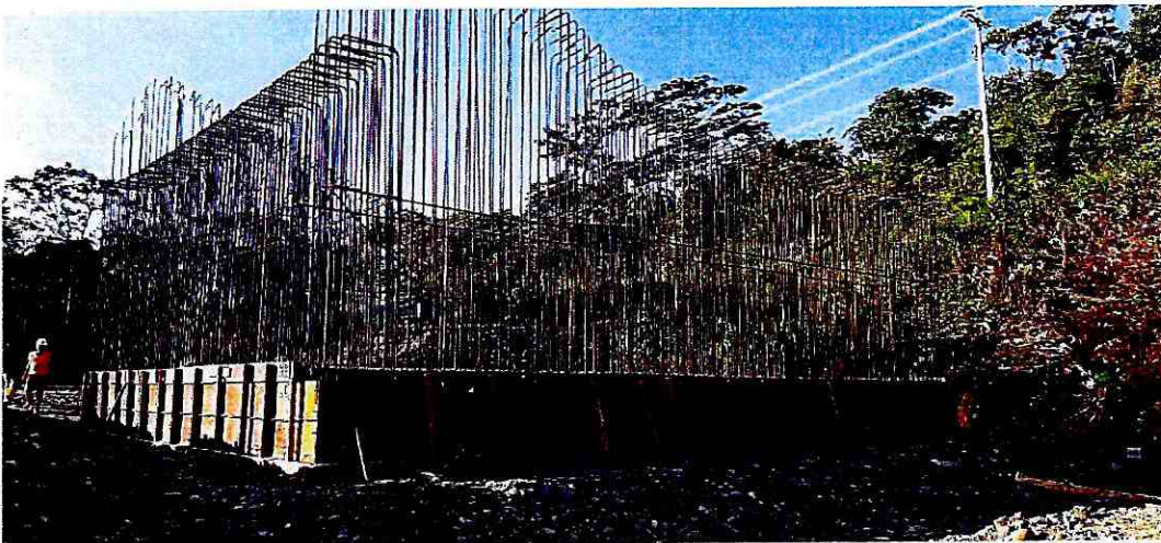
Fotografía 30: Encofrado de zapata
