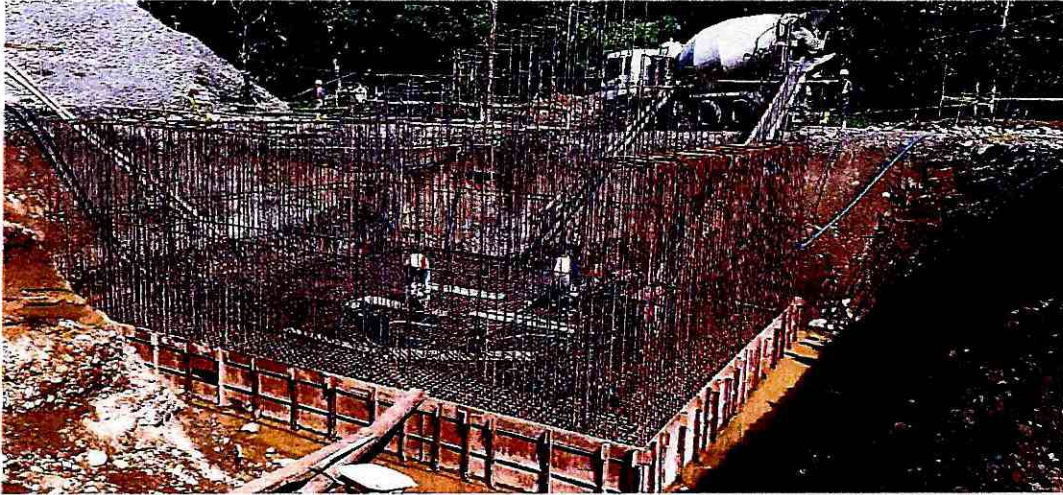
Fotografía 22: Fundido de zapata
