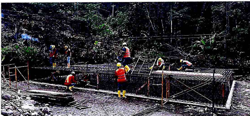
Fotografía 15: Armado de hierro vertical de paredes
