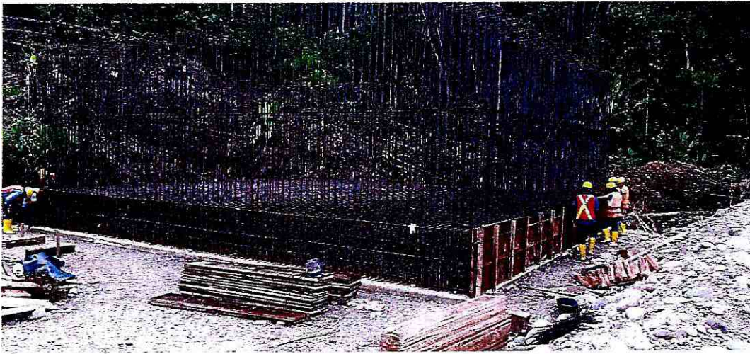
Fotografía 28: Encofrado de zapata
