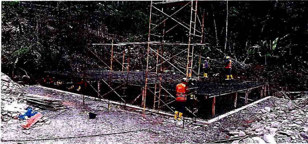
Fotografía 16: Armado de hierro vertical de paredes
