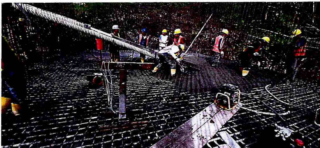
Fotografía 36: Fundido de zapata
