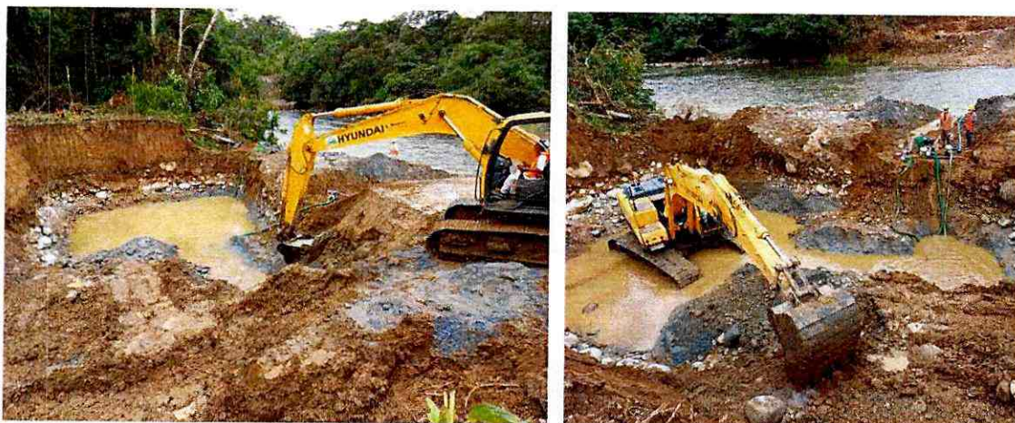
Fotografía No. 1. Excavación para torre margen izquierdo
