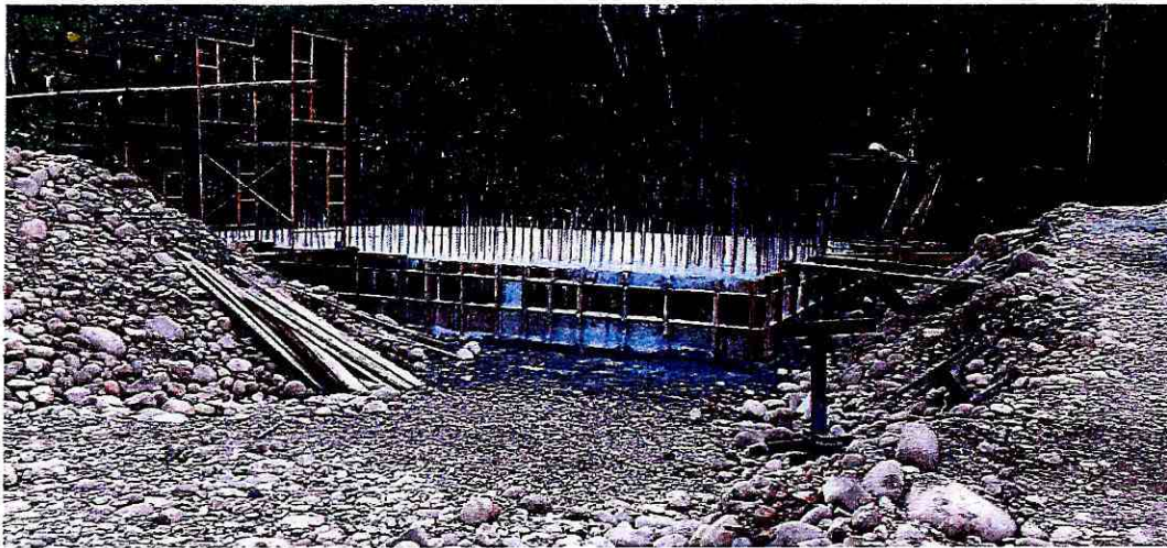
Fotografía 37: Fundido de zapata
