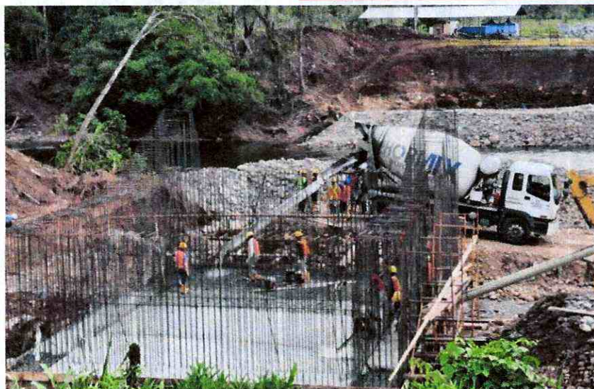
Fotografía 7. Armadura en muros – fundido – margen izquierdo
