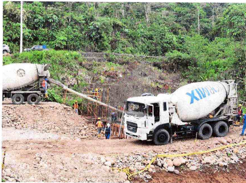
Fotografía 6. Fundido de cimentación de anclaje – margen izquierdo
