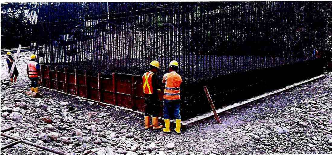
Fotografía 29: Encofrado de zapata
