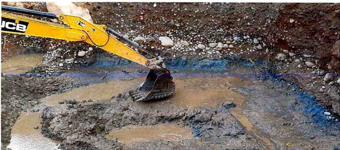
Fotografía No. 1. Excavación para torre margen derecho.
