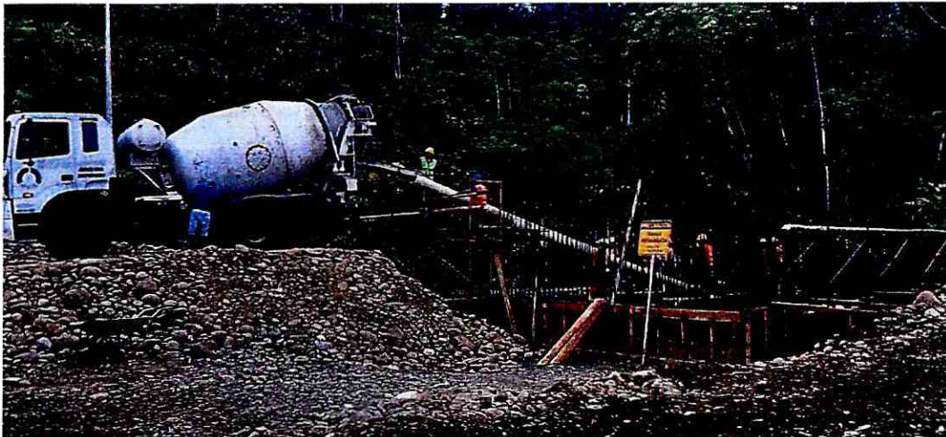
Fotografía 33: Fundido de zapata
