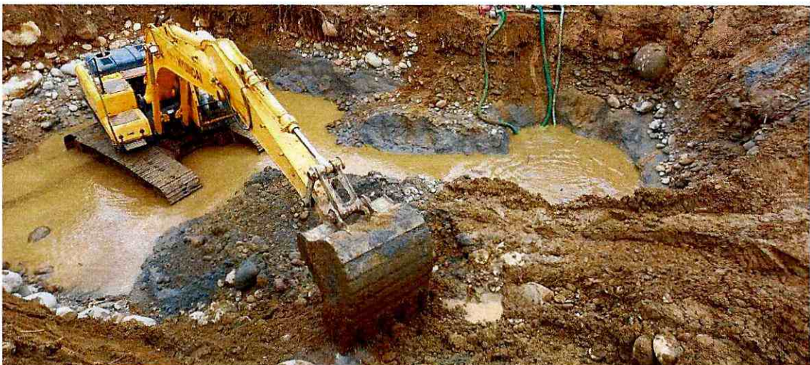
Fotografía No. 2. Excavación para torre margen izquierdo.
