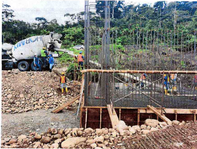
Fotografía 5. Fundido de cimentación de anclaje – margen izquierdp
