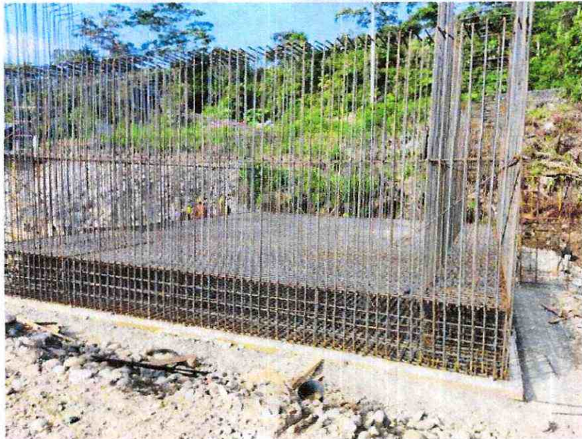
Fotografía 3. Armadura de refuerzo vertical en anclaje izquierdo
