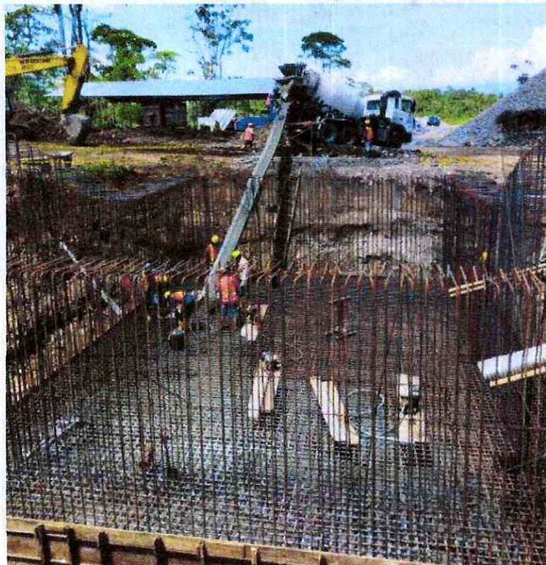
Fotografía 4. Fundido de cimentación de anclaje – margen derecho
