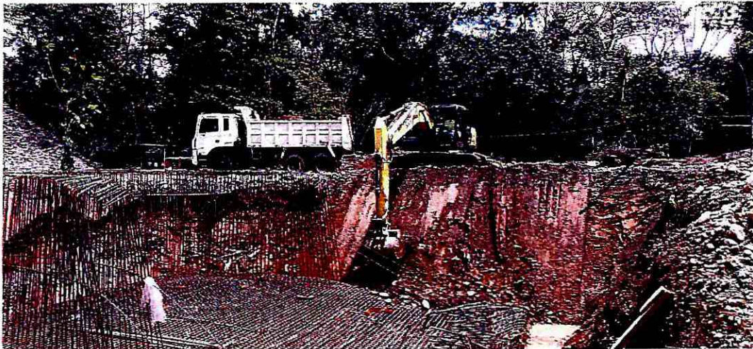
Fotografía 5: Limpieza del área
