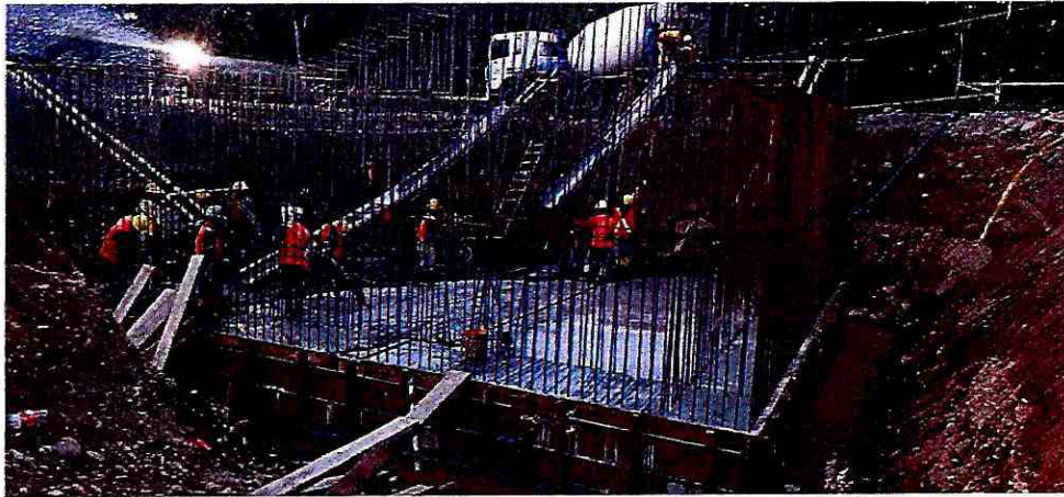
Fotografía 26: Fundido de zapata
