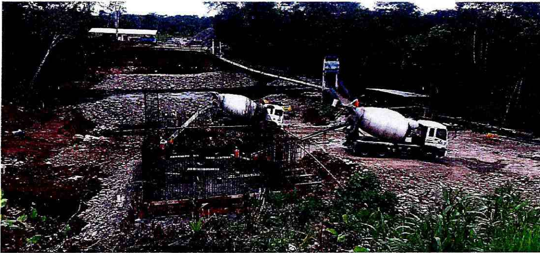
Fotografía 34: Fundido de zapata
