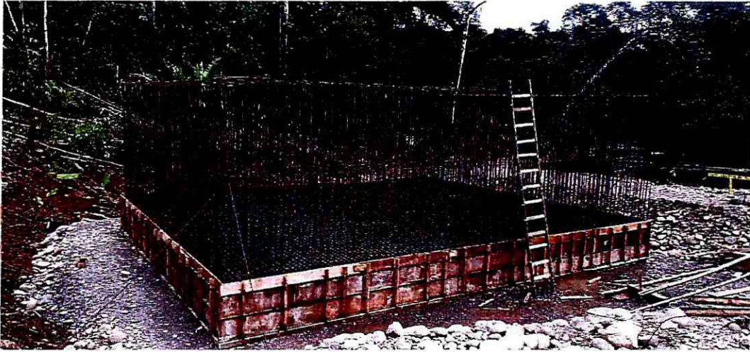
Fotografía 31: Encofrado de zapata
