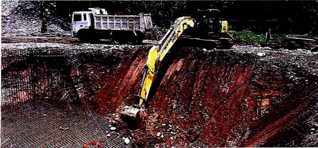
Fotografía 4: Limpieza del área
