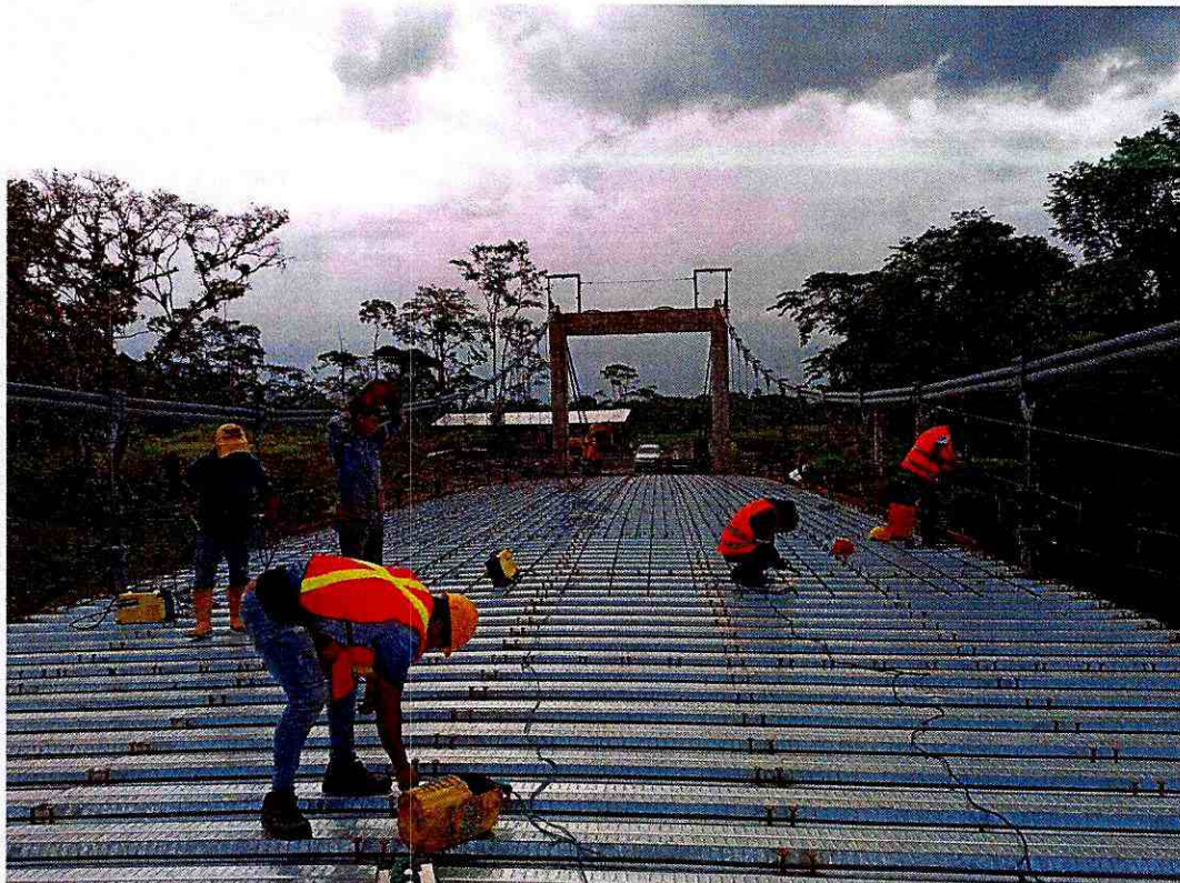
ANEXO RUBRO NRO. 31 Suministro y fabricación de lámina deck de placa colaborante e=0.76 mm
