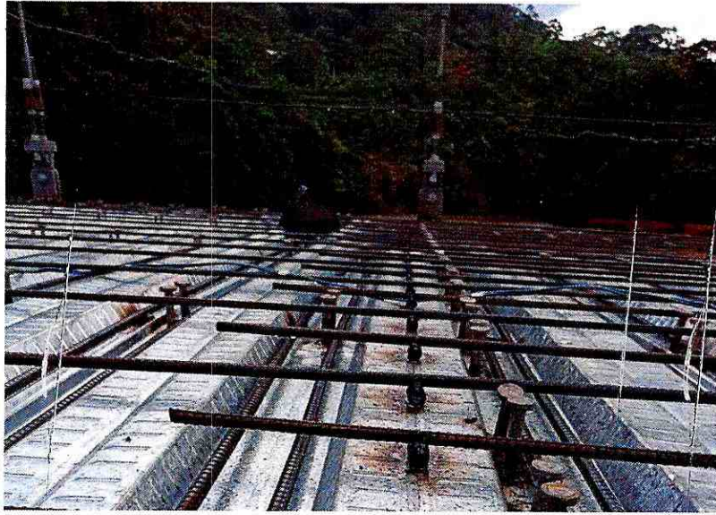
ANEXO RUBRO NRO. 31 Suministro y fabricación de lámina deck de placa colaborante e=0.76 mm
