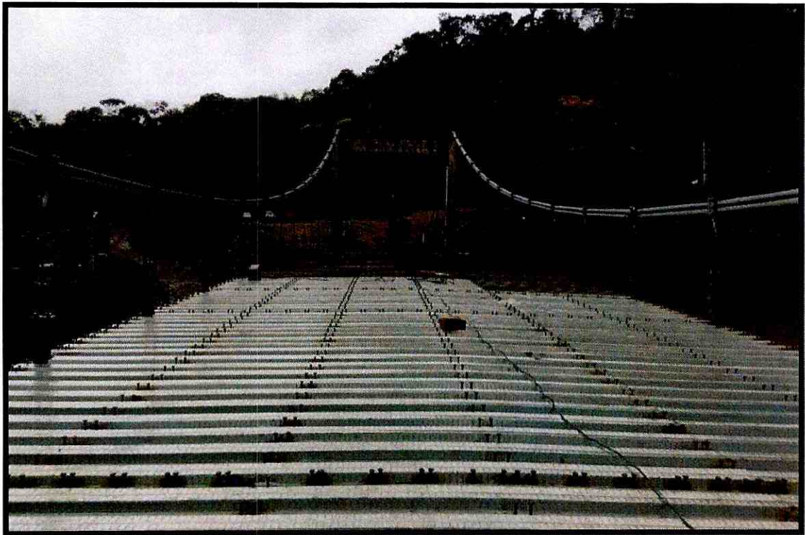
Fotografía 4. Colocación de conectores de corte
