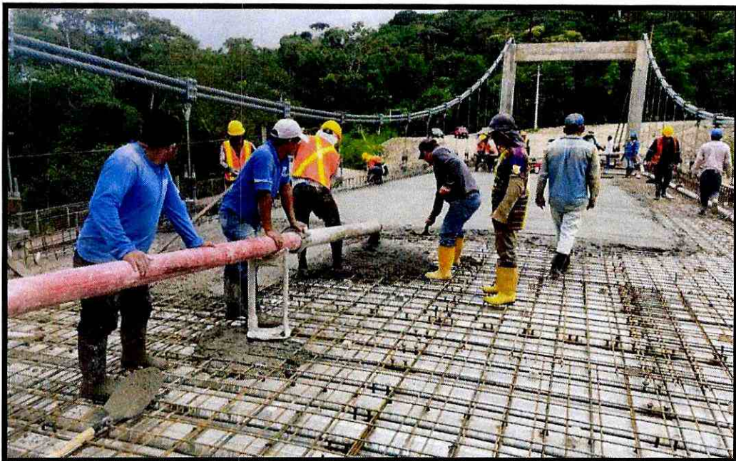
Fotografía 6. Acero de refuerzo y fundido de losa.
