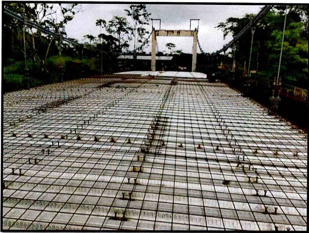
Fotografía 5. Colocación de malla electrosoldada
