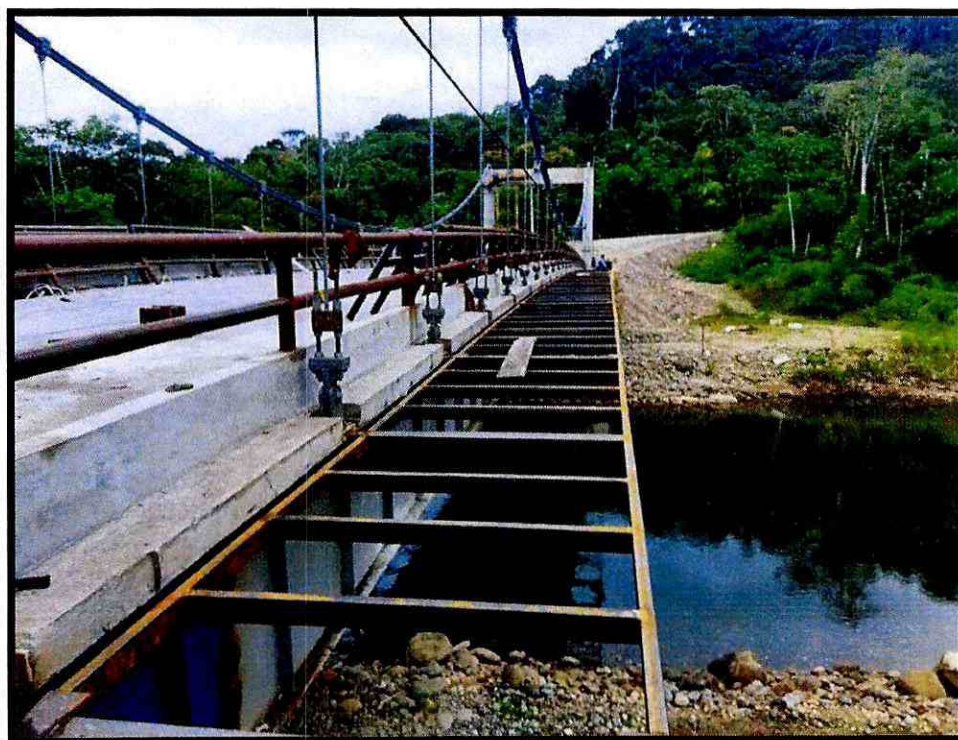
Fotografía 2. Montaje de estructura para peatones
