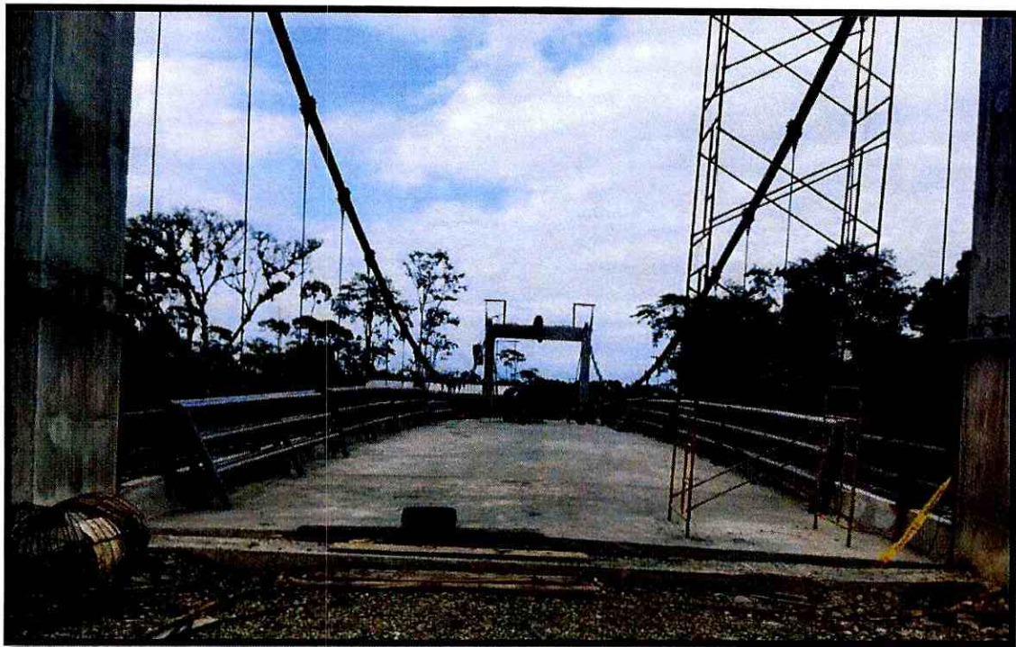
Fotografía 3. Montaje de pasamanos y losa fundida
