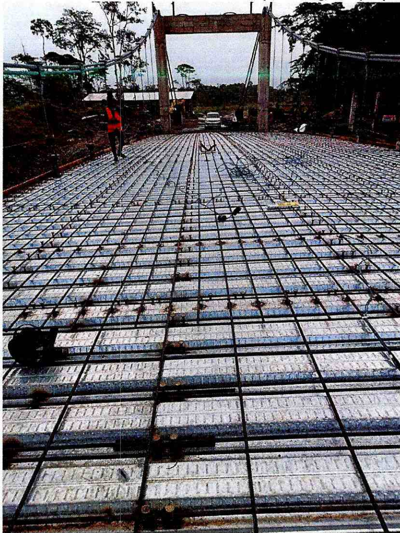
AEXO RUBRO NRO. 30 Acero de refuerzo en barras f_y=4200 kg/cm 2 (en puentes)
