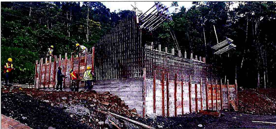
Encofrado (tramo 2)
