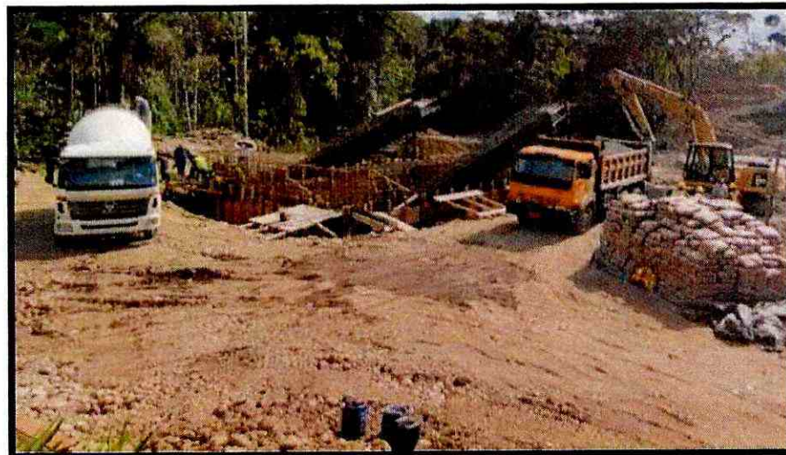
Fotografía 2. Trabajo de mezclado y fundido de muros.
