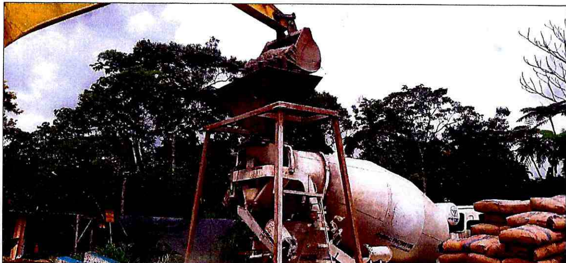
Hormigonado de muros (tramo 2)
