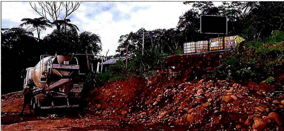
Hormigonado de muros (tramo 1)
