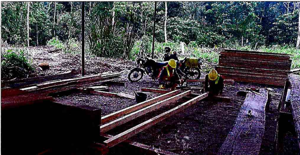
Elaboración de encofrados
