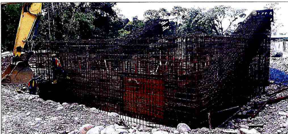
Encofrado de muros (tramo 1)
