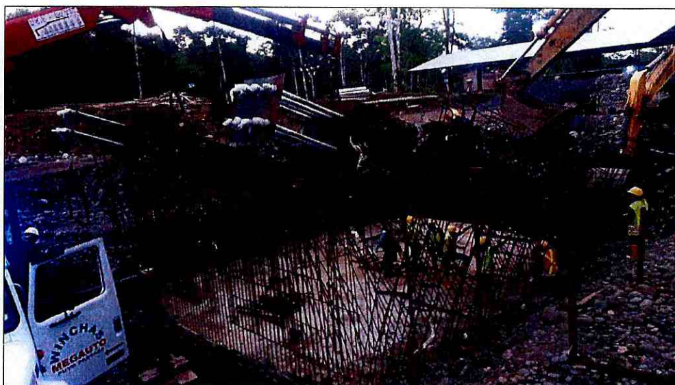
Montaje de vigas y tensores del anclaje derecho
