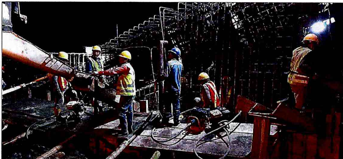
Hormigonado de muros (tramo 1)
