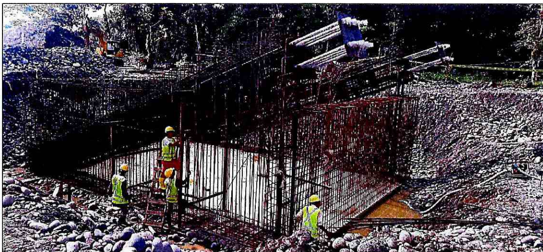
Colocación y amarre de hierro transversal de muros
