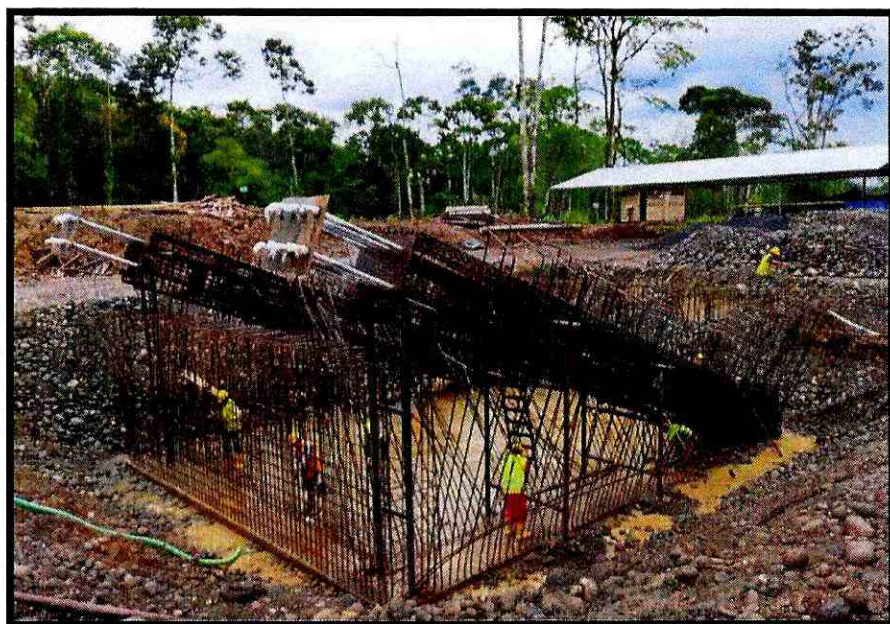
Fotografía 6. Aparatos mecánicos anclaje margen derecho.
