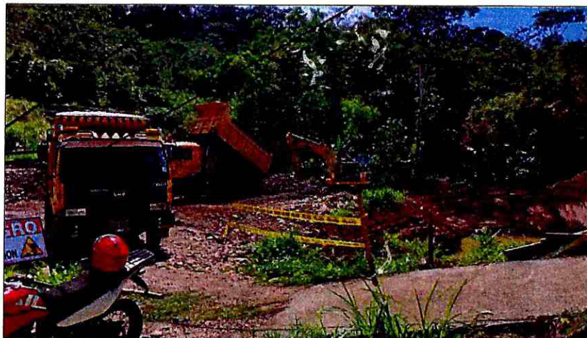
Relleno compactado cajón de anclaje margen izquierdo
