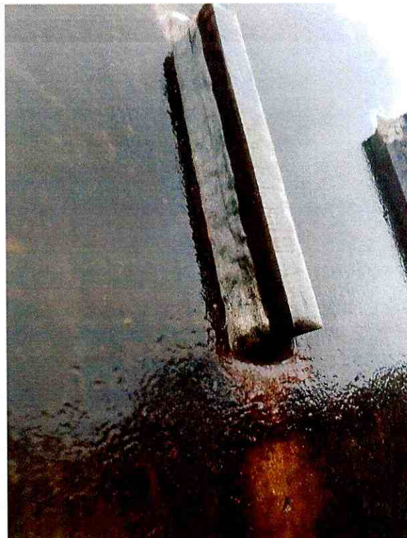
Fotografía 5. Cordón de soldadura de placa guía (pos 80)
