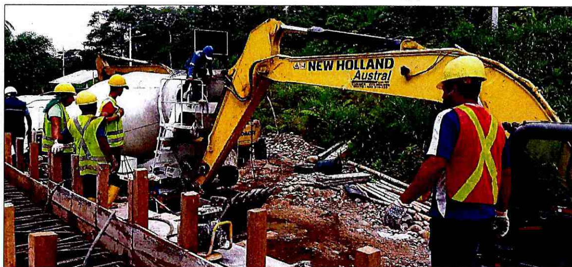
Hormigonado de muros (tramo 2)
