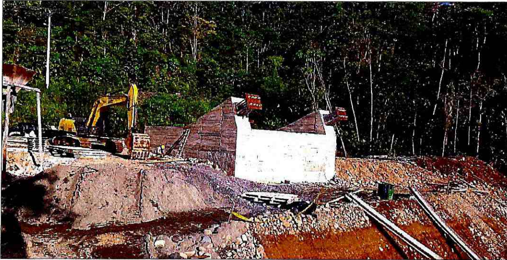
Cajón de anclaje margen izquierdo
