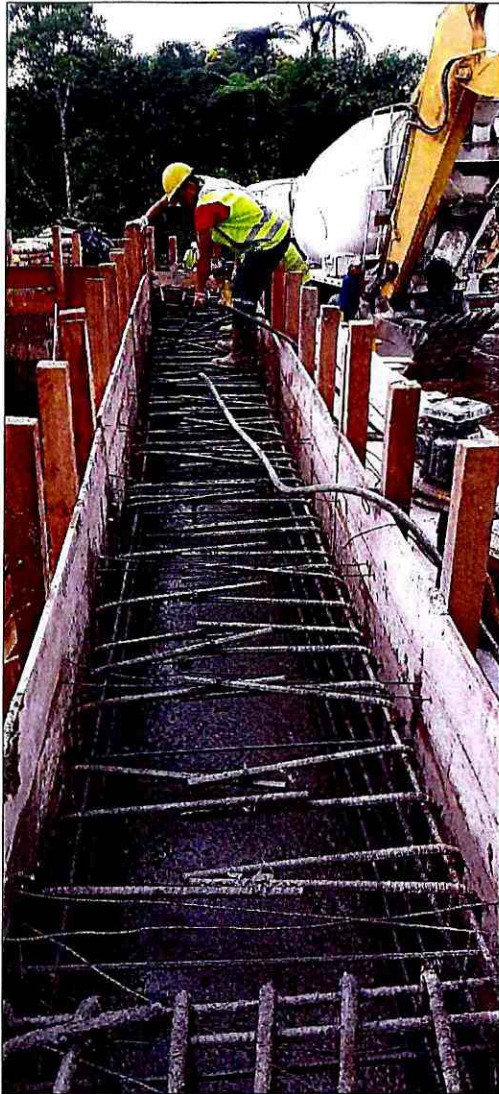
Hormigonado de muros (tramo 2)
