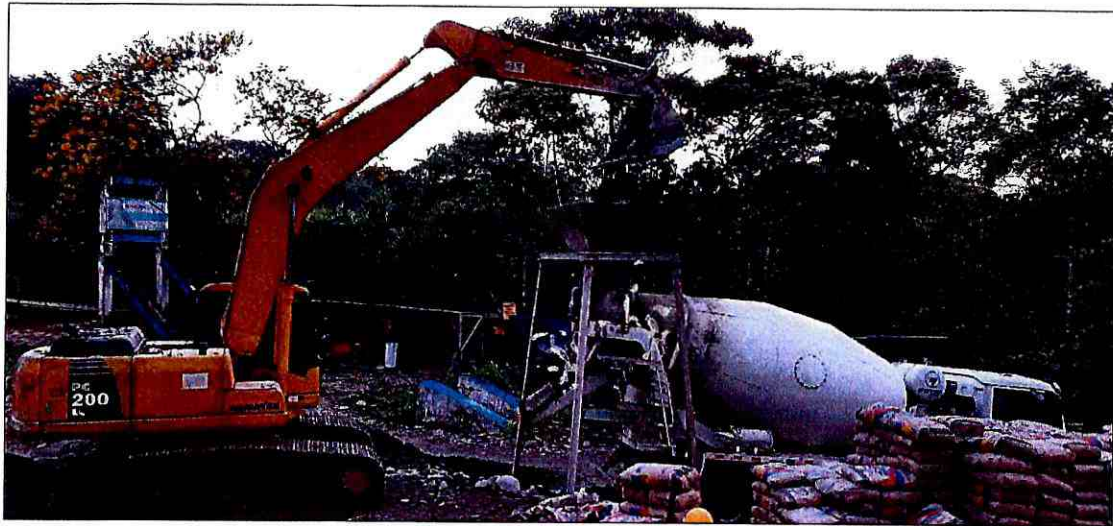
Hormigonado de muros (tramo 2)
