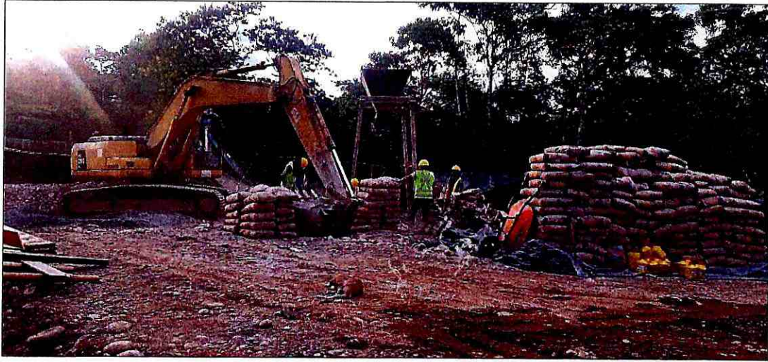
Hormigonado de muros (tramo 1)
