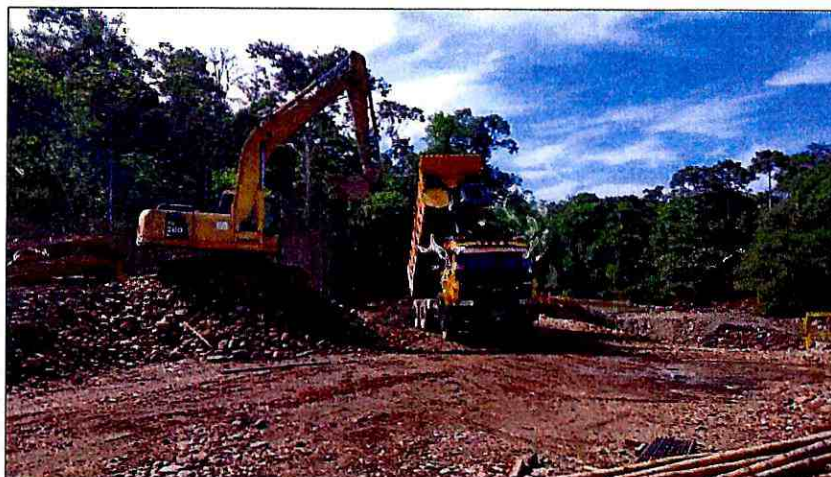
Relleno compactado cajón de anclaje margen izquierdo
