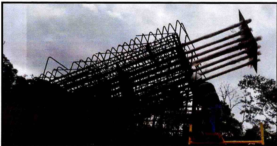
Fotografía 5. Verificación de alineamientos de templadores en anclaje.
