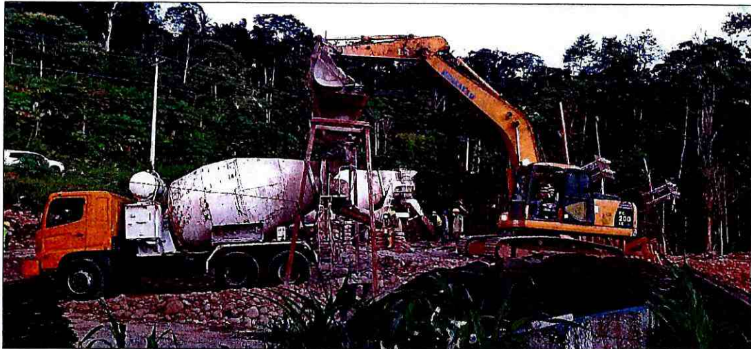
Hormigonado de muros (tramo 1)
