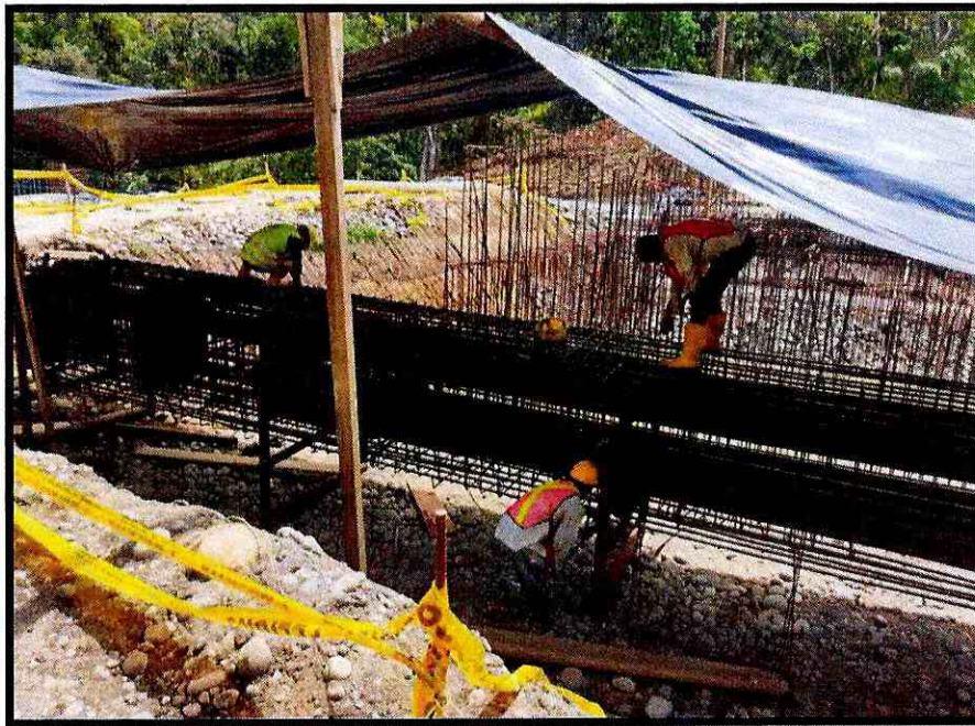
Fotografía 4. Armado de acero de refuerzo en anclajes – margen derecho.
