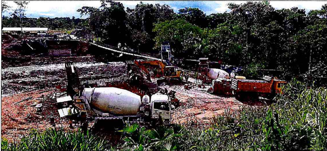
Hormigonado de muros (tramo 1)
