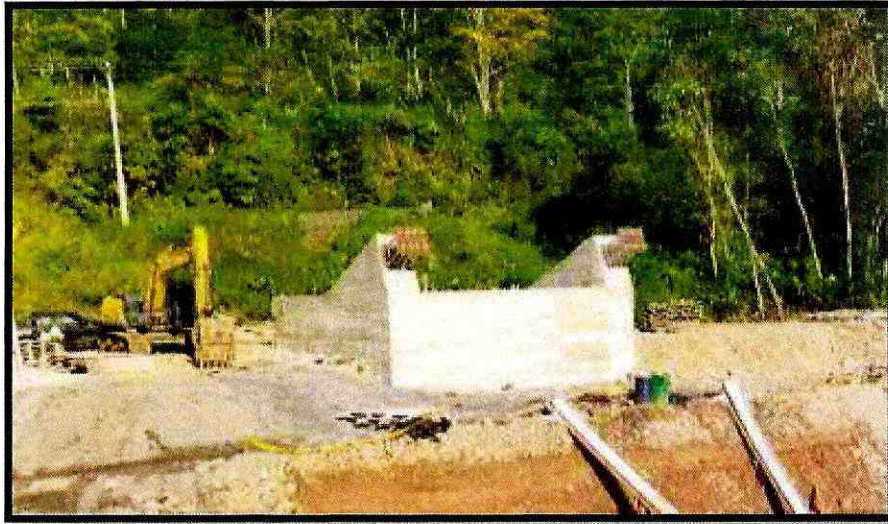
Fotografía 3. Fundido anclaje margen izquierdo
