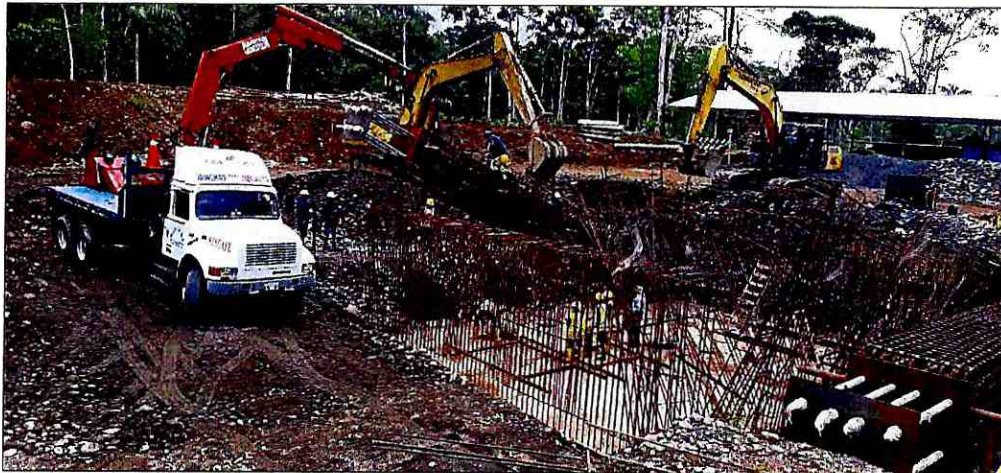
Montaje de vigas y tensores del anclaje derecho
