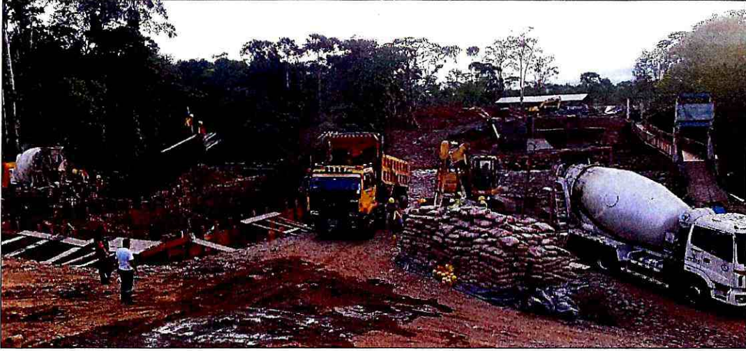
Hormigonado de muros (tramo 1)
