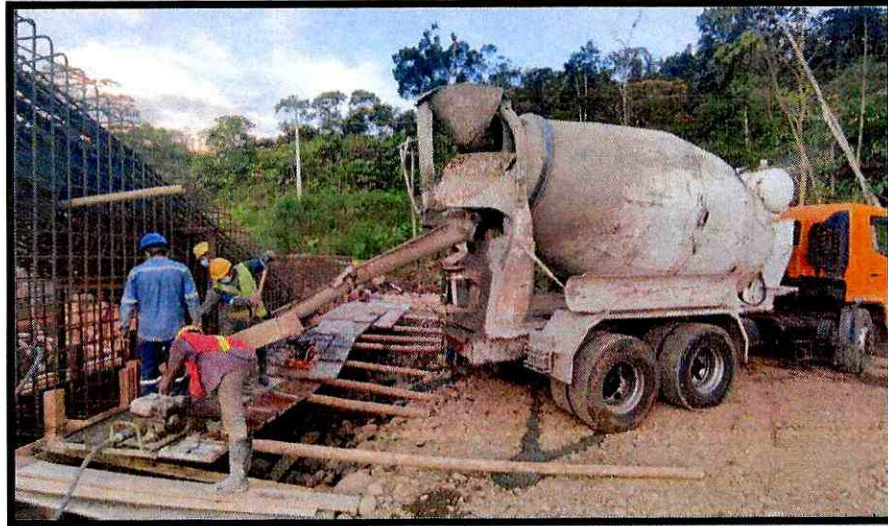
Fotografía 1. Fundido de anclaje del margen izquierdo
