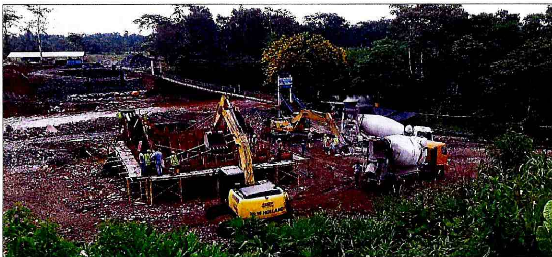
Hormigonado de muros (tramo 2)
