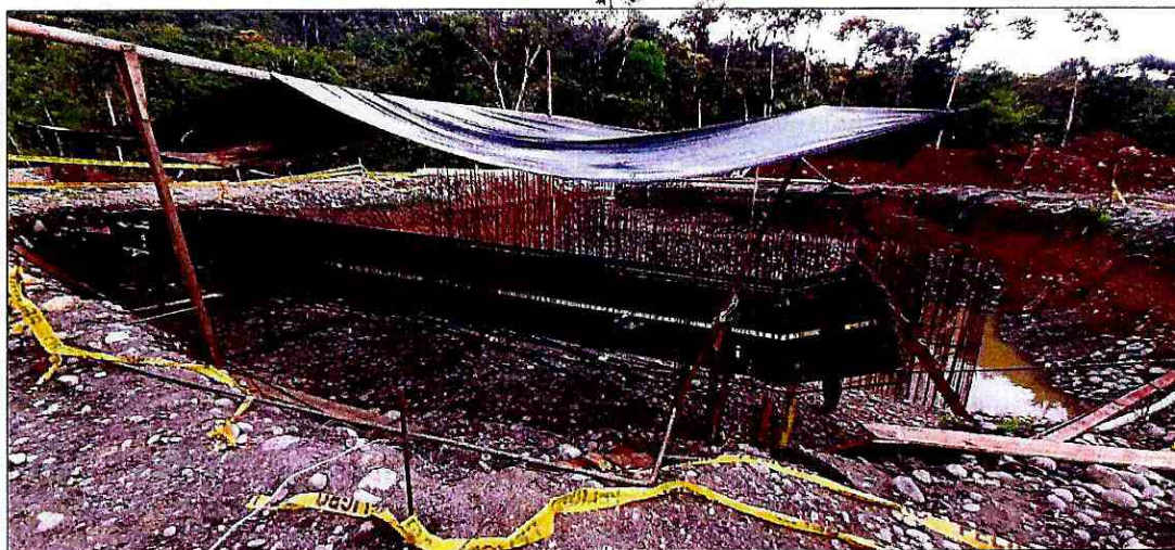
Armado y amarre del hierro de la viga de anclaje
