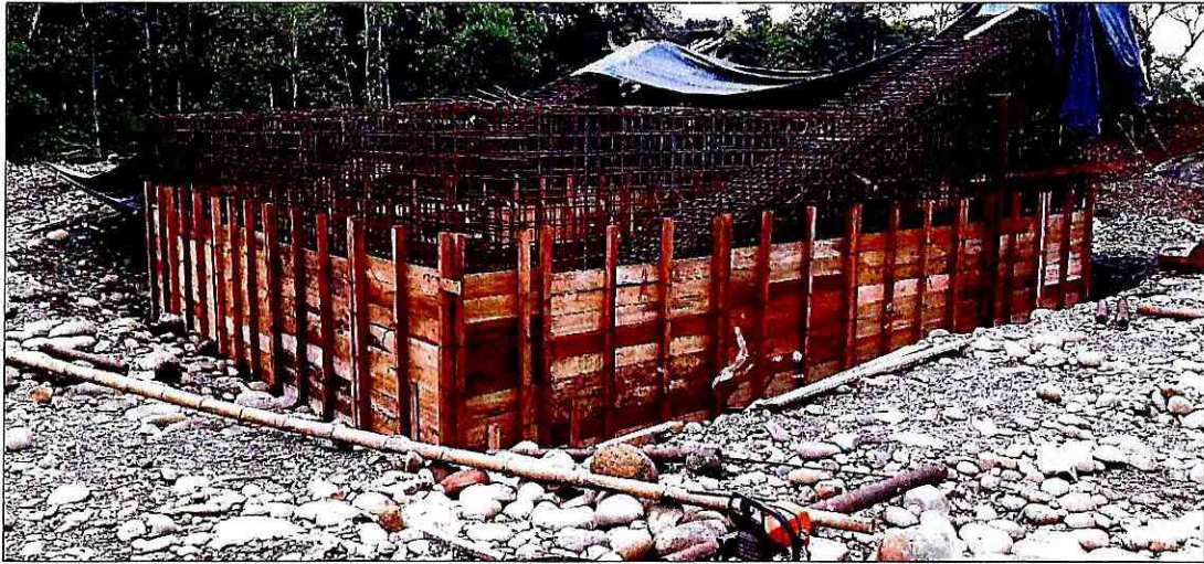
Encofrado de muros (tramo 1)
