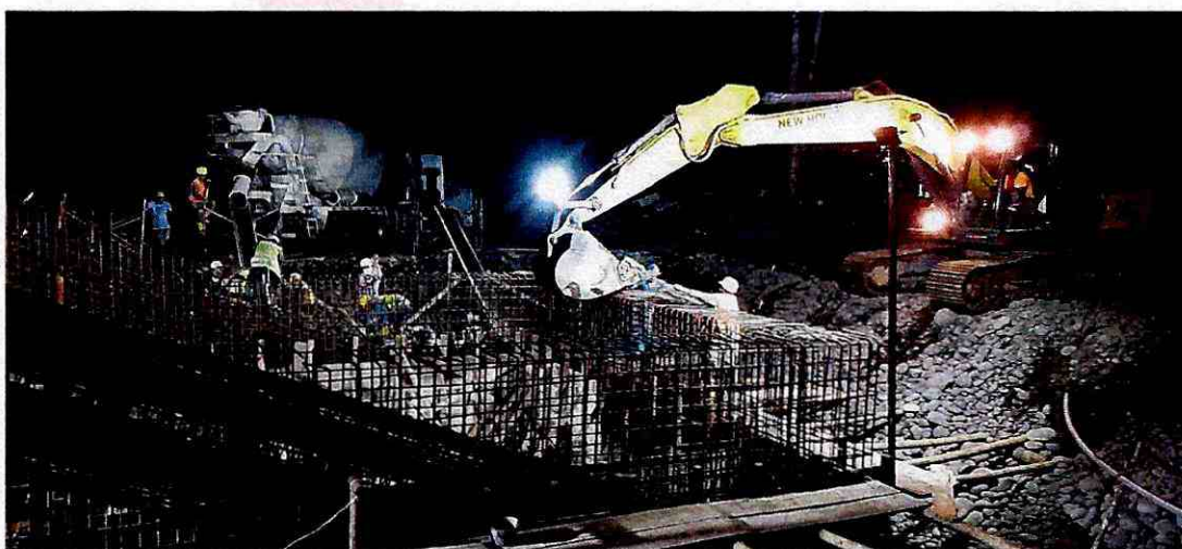
Hormigonado de muros (tramo 1)
