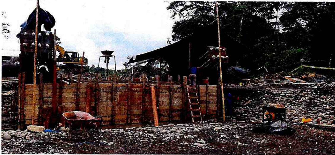
Encofrado (tramo 2)
