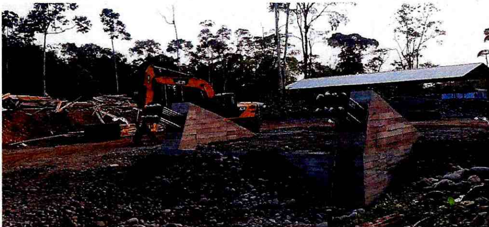
Relleno compactado cajón de anclaje margen derecho
