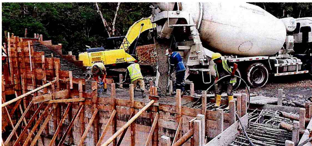
Hormigonado de muros (tramo 2)
