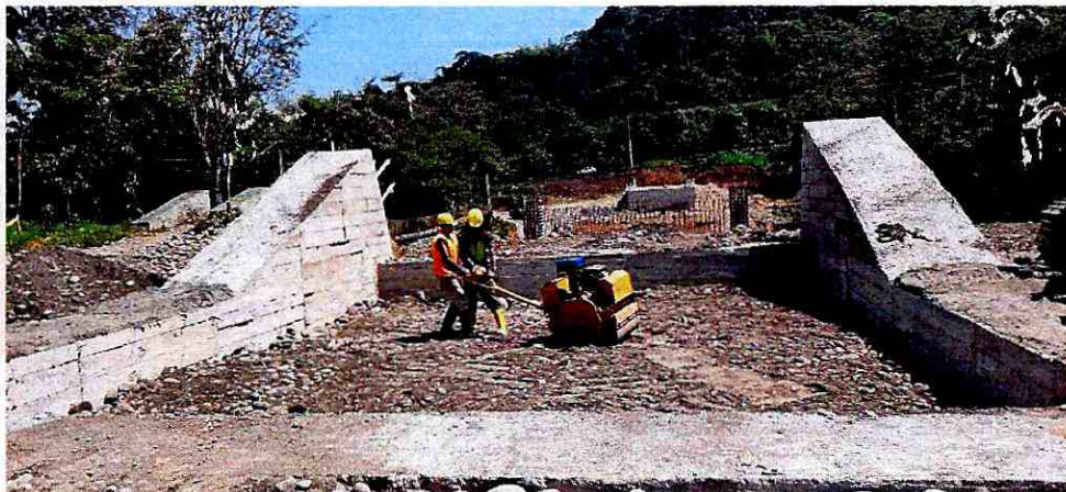
Relleno compactado cajón de anclaje margen derecho
