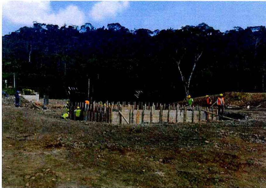
Fotografía 1. Encofrado de anclaje del margen derecho
