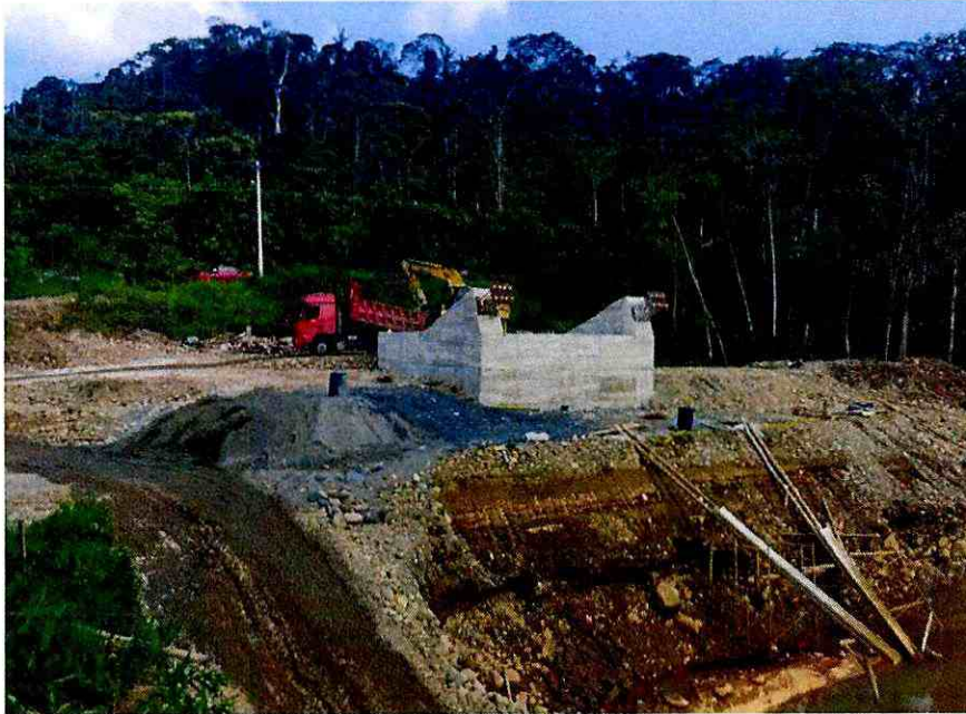
Fotografía 5. Relleno de anclajes.
