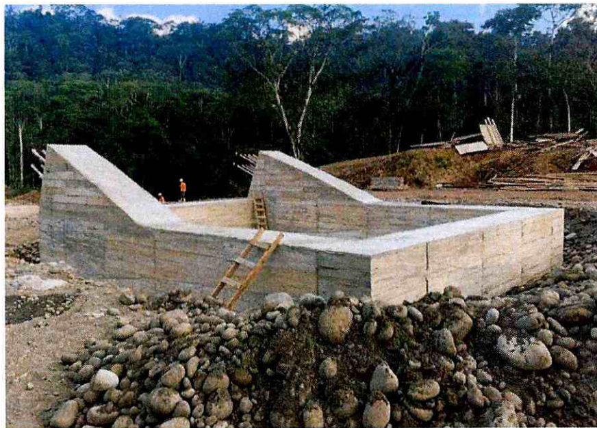
Fotografía 4. Desencofrado de anclaje derecho y e inicios de relleno.
