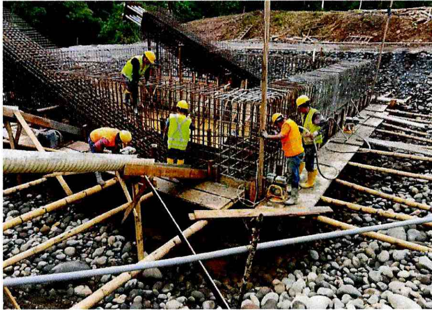
Fotografía 3. Fundido de anclajes – margen derecho.
