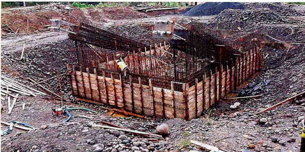
Encofrado de muros (tramo 1)
