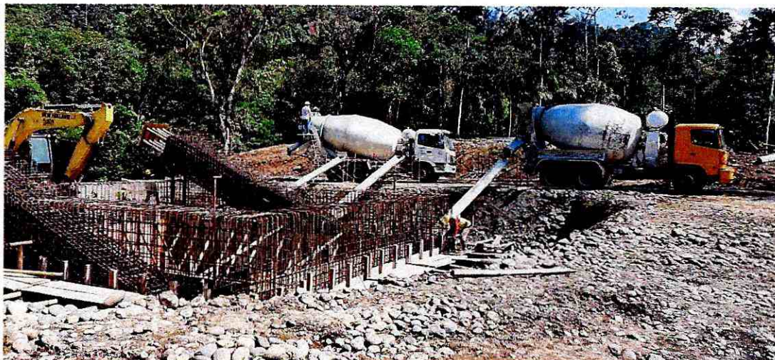
Hormigonado de muros (tramo 1)
