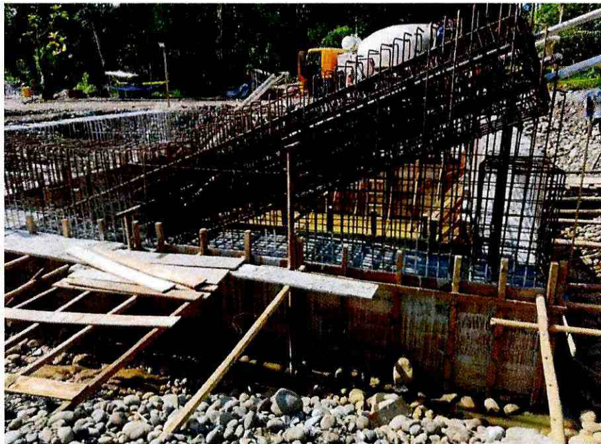
Fotografía 2. Anclaje y armadura – margen derecho
