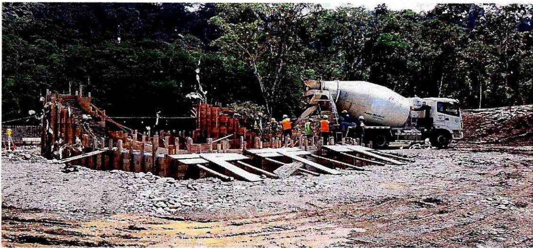
Hormigonado de muros (tramo 2)
