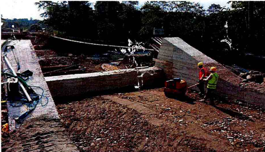
Relleno compactado cajón de anclaje margen izquierdo
