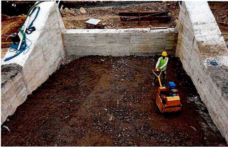
Relleno compactado cajón de anclaje margen izquierdo
