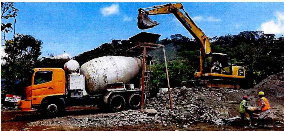
Hormigonado de muros (tramo 1)
