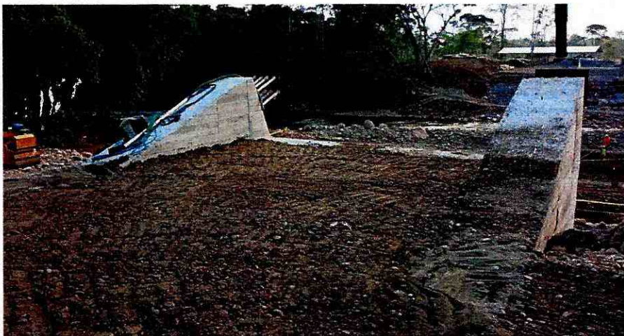
Relleno compactado cajón de anclaje margen izquierdo
