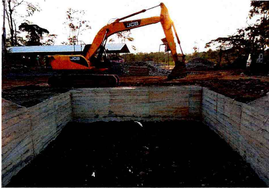
Relleno compactado cajón de anclaje margen derecho
