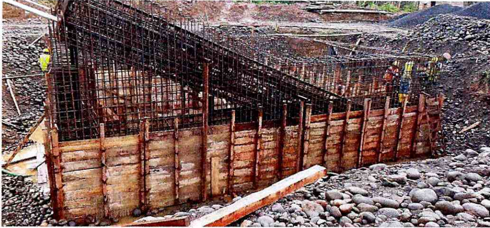
Encofrado de muros (tramo 1)
