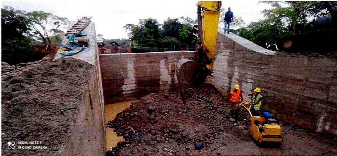
Relleno compactado cajón de anclaje margen izquierdo
