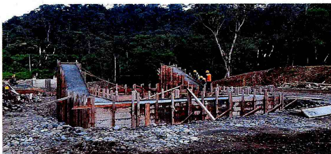
Hormigonado de muros (tramo 2)
