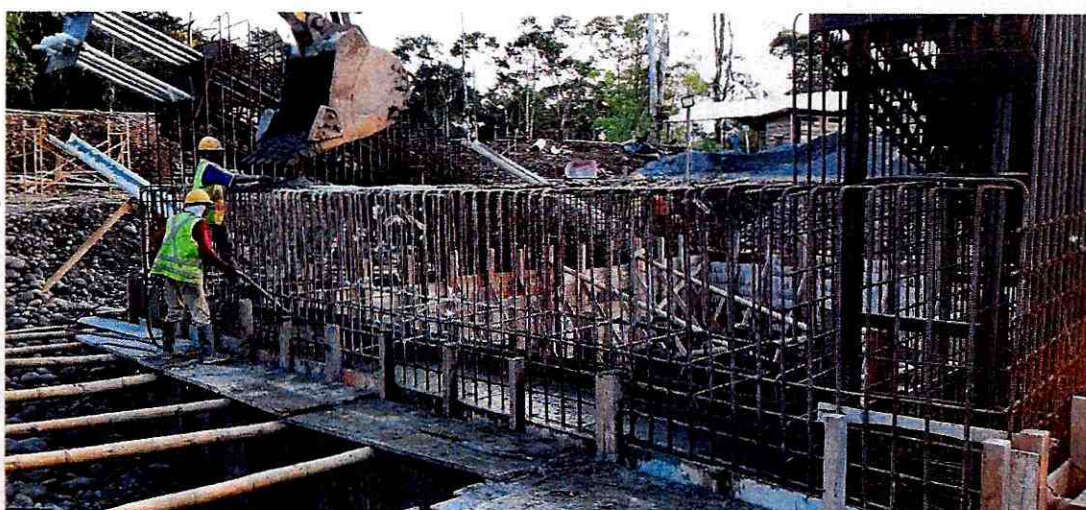
Hormigonado de muros (tramo 1)
