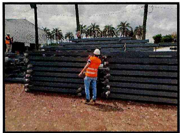
Fotografía 5. Revisión de pulido, esmerilado, acabado superficial, pintura, etiquetado y almacenamiento.
