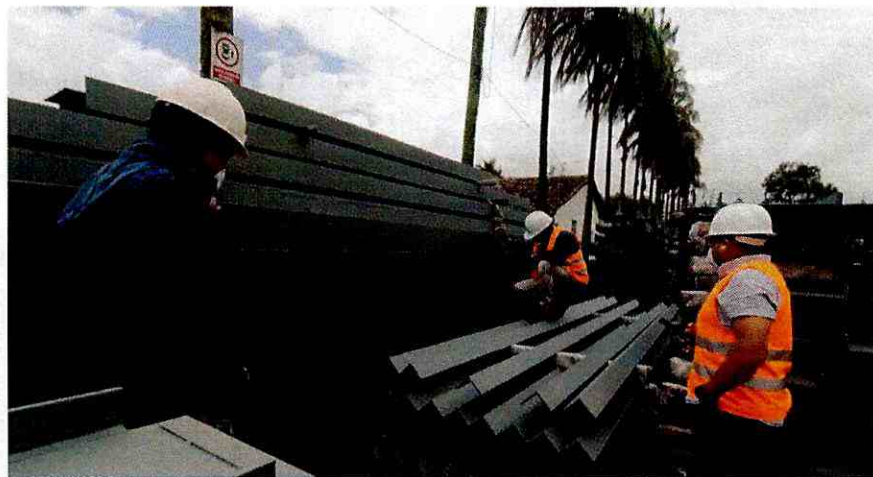
Fotografía 4. Almacenaje de vigas y arriostramientos.
