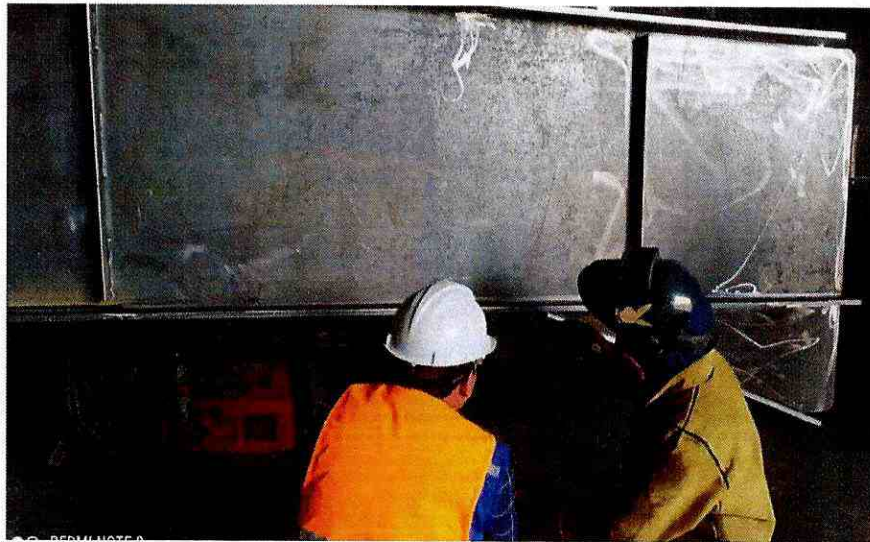
Fotografía 1. Verificación de soldadura en vigas transversales principales.
